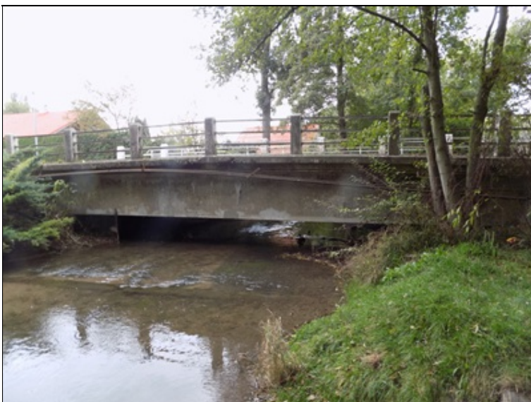
Pohled na konstrukci zprava.
