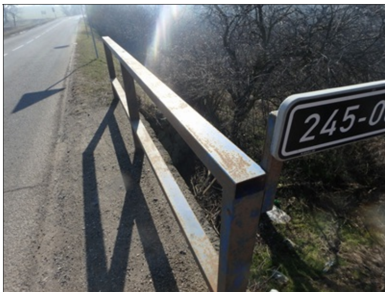
Koroze zábradlí.
