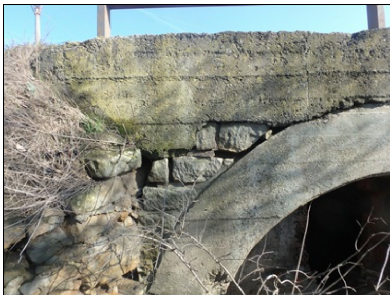
DTTO, degradace betonu římsy.
