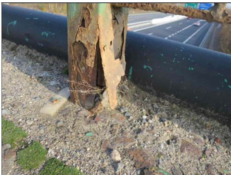
korozí zábradlí
