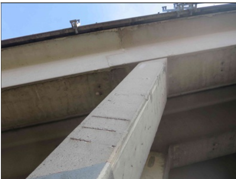
podhled 4. nosníku u P2
