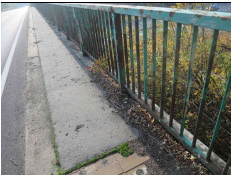
koroze zábradlí
