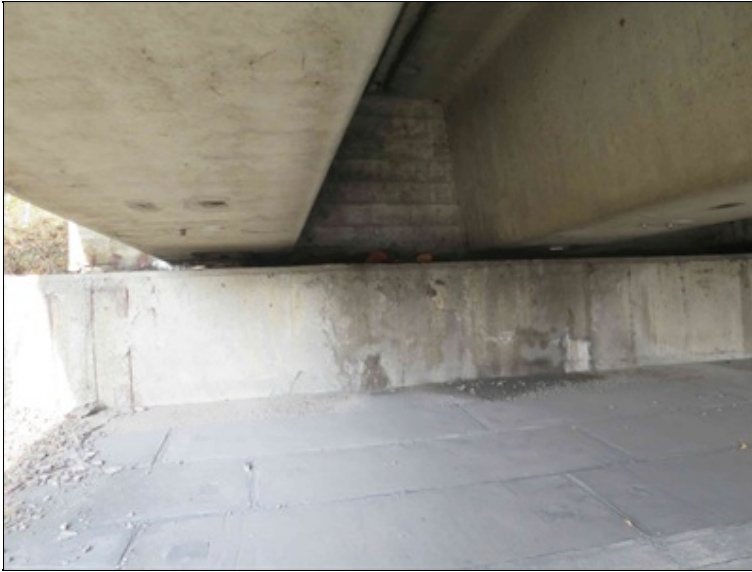
stopy po průsacích na líci O1
