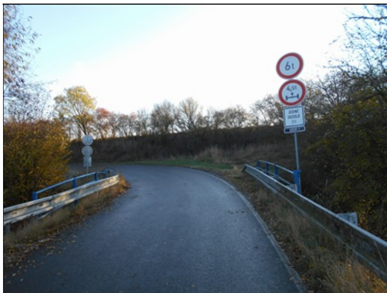
Příčné uspořádání na mostě-pohled proti směru zatížení.JPG
