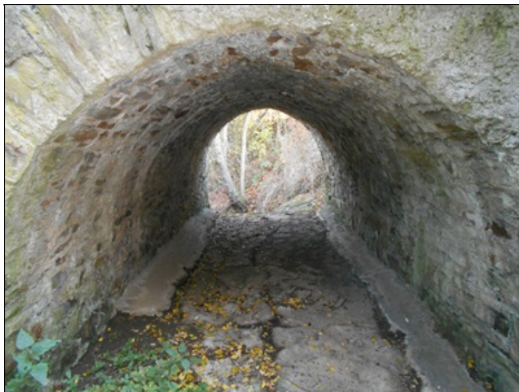
Poruchy zdiva na pravém rohu O2-stopy zatékání, výluhy, vyplavená malty.JPG
