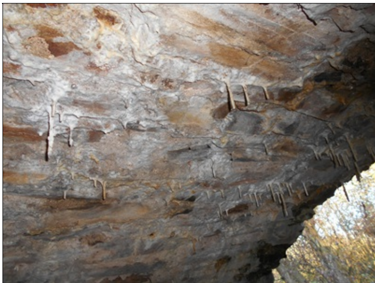
Krápníkové výluhy v klenbě na její pravé straně.JPG
