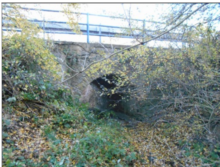
Pohled na levý bok mostu.JPG
