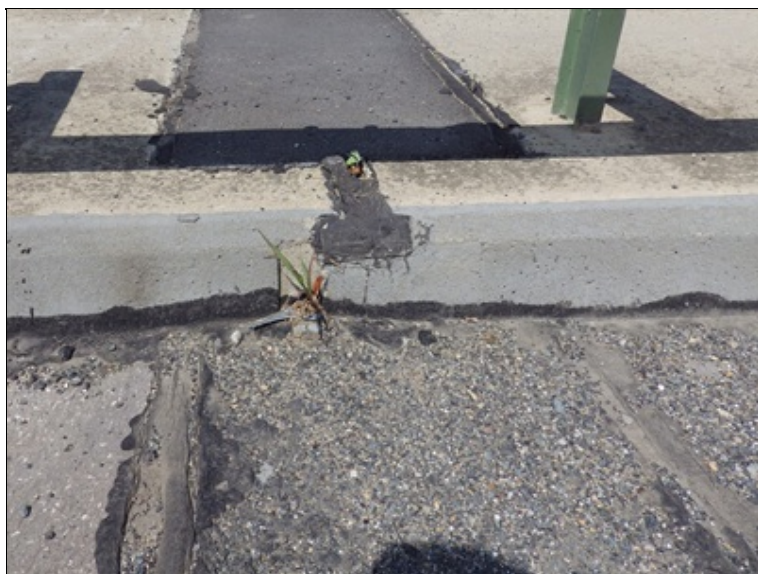
Mostní závěr nad podporou P3
