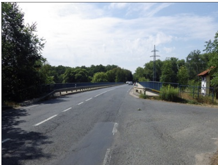
Pohled na most proti směru staničení (od Všetat).
