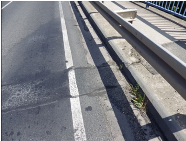
Mostní závěr nad podporou OP4
