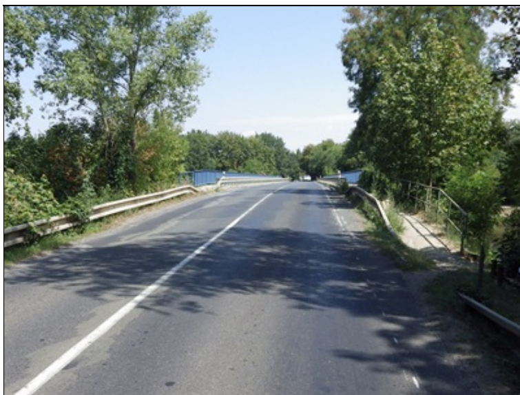
Pohled na most ve směru staničení (od Kostelce).
