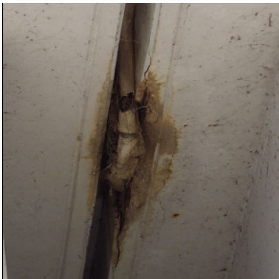
Mostní závěr nad podporou OP4
