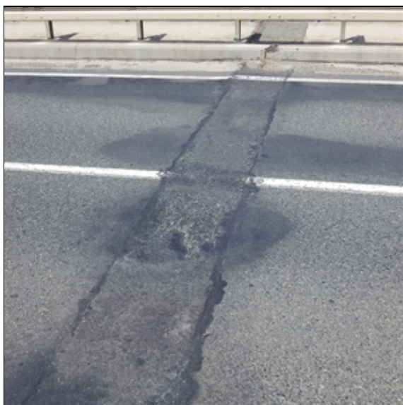
Mostní závěr nad podporou P2
