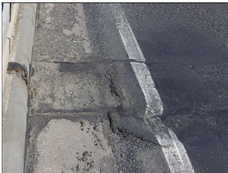
Mostní závěr nad podporou OP1
