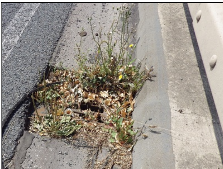
Zanesený odvodňovač s uchycenou vegetací.
