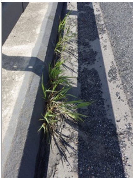
Uchycená vegetace podél římsy
