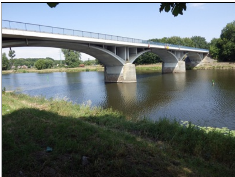
Pohled na most zprava (ve směru toku, opěra OP4 vpravo)
