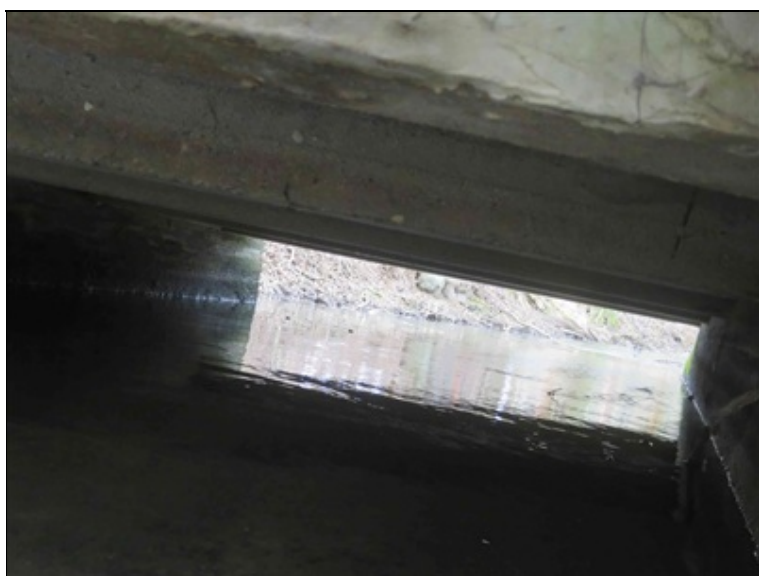
průhled mostním otvorem
