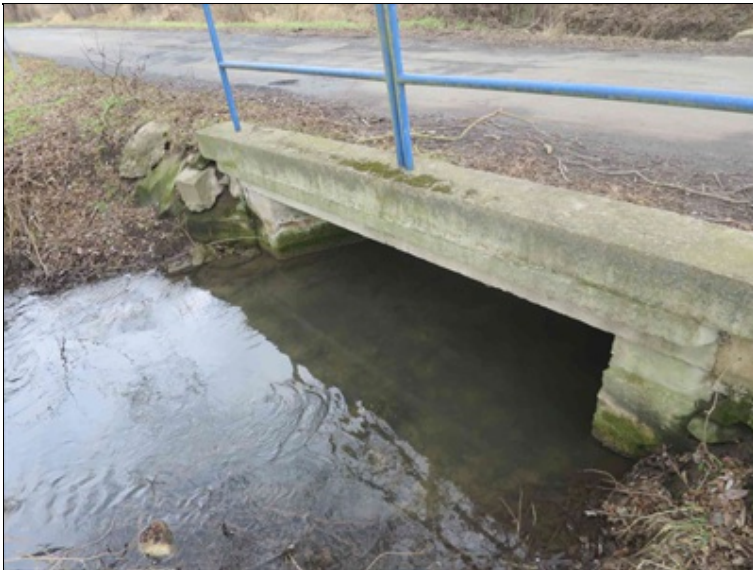
pravý bok mostu
