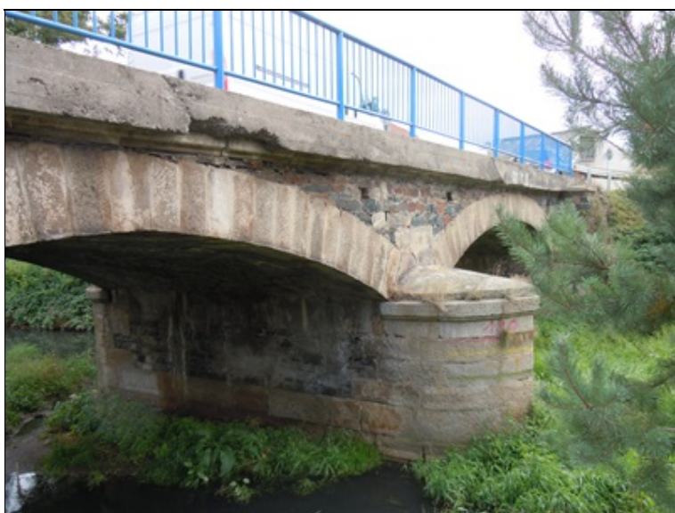
Římsa pole 1 vpravo, střední pilíř
