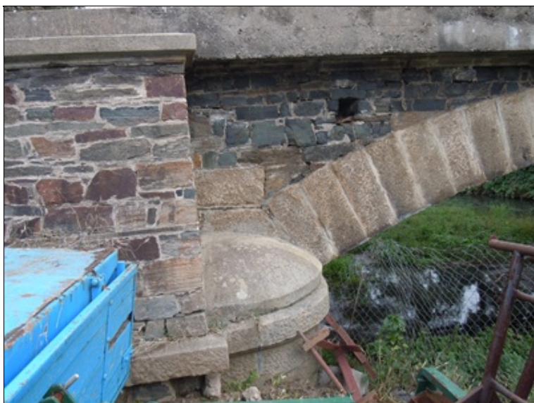
Křídlo opěry 1 vpravo
