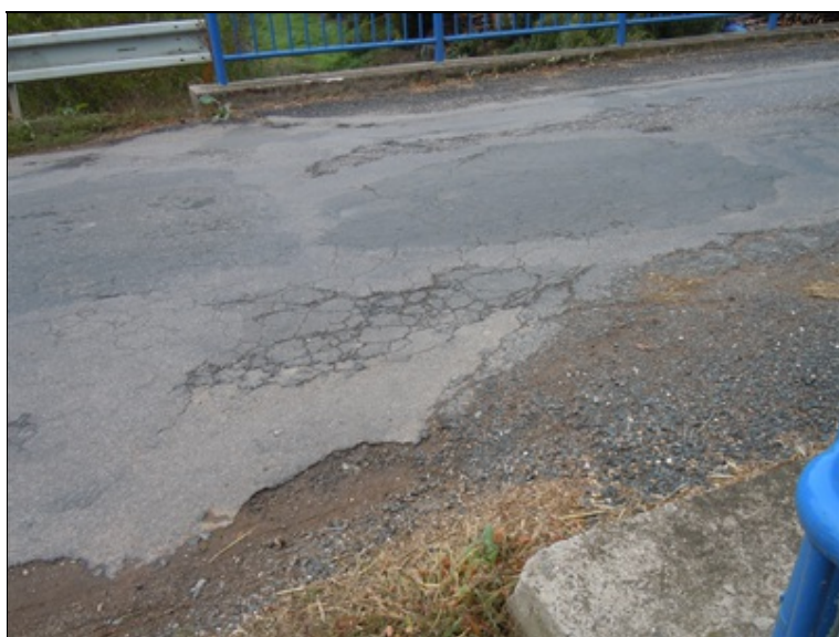
Stav vozovky na mostě, vegetace
