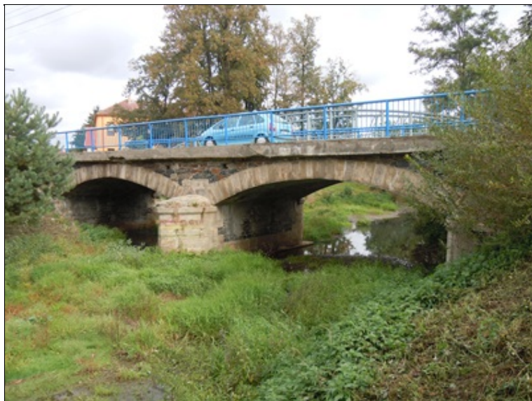
Pohled na most zprava
