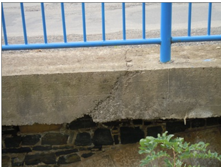
Pracovní spára římsy vlevo
