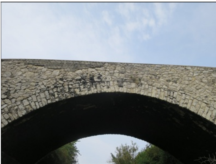
pohled na pravou poprsní zeď nad vrcholem klenby
