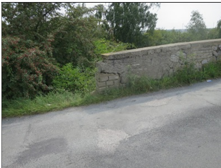
čelo pravé parapetní zídky za O2
