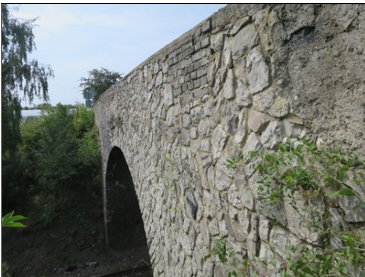
pohled na pravou parapetní zeď od O2
