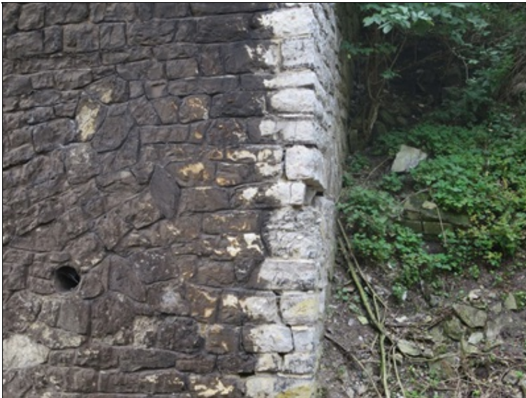
svislá trhlina ve zdivu hrany O2
