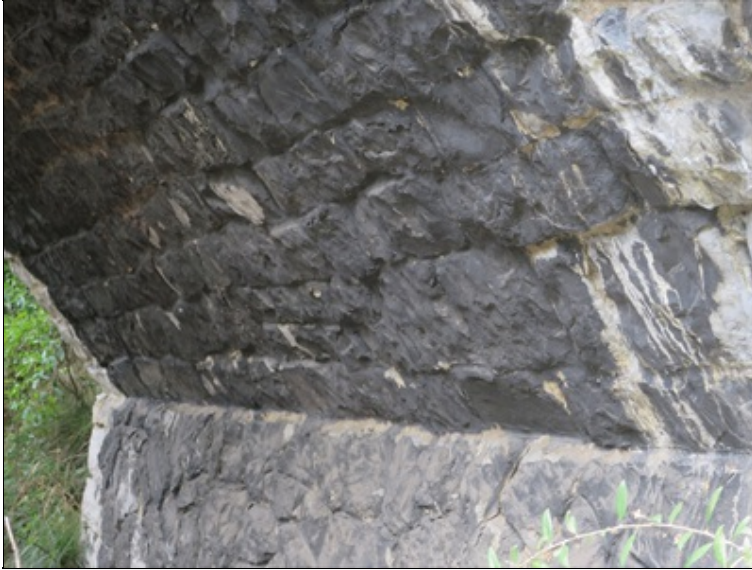
oblast vetknutí klenbového pasu do O2
