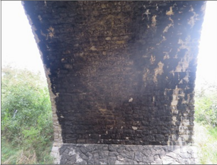
podhled klenbového pasu nad O2
