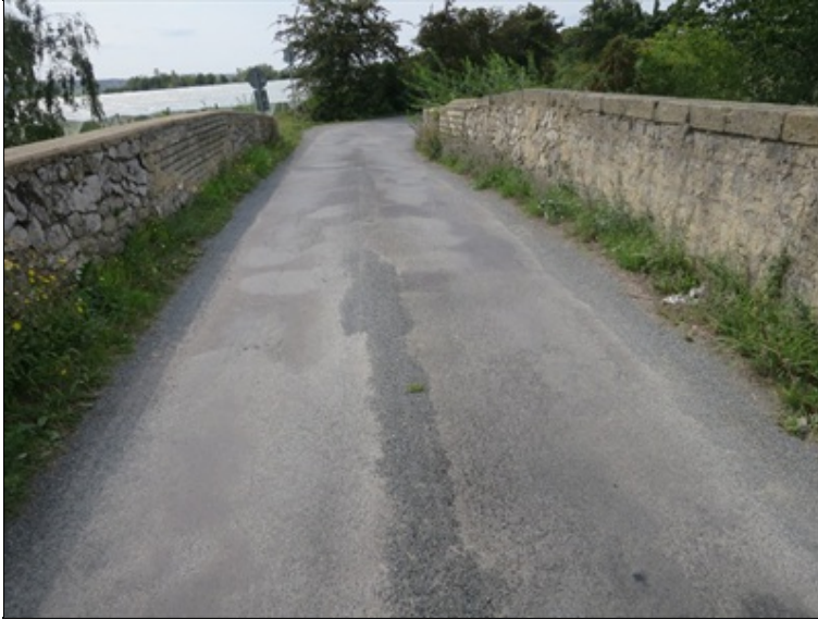
pohled na vozovku
