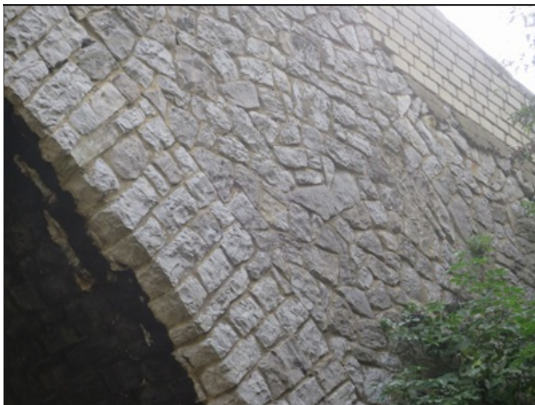
pohled na levou poprsní zeď nad O1
