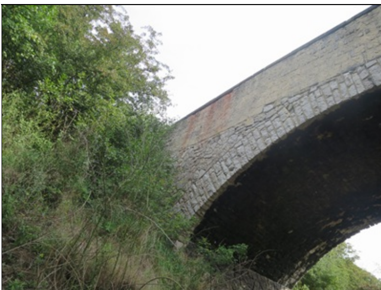
pohled na levou poprsní zeď nad O2
