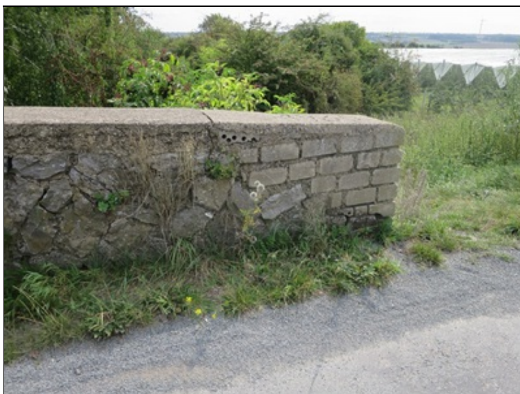
čelo pravé parapetní zídky před O1
