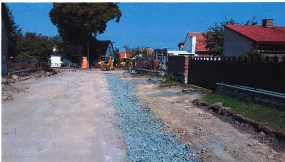
Sanace a rozjezdy MK
