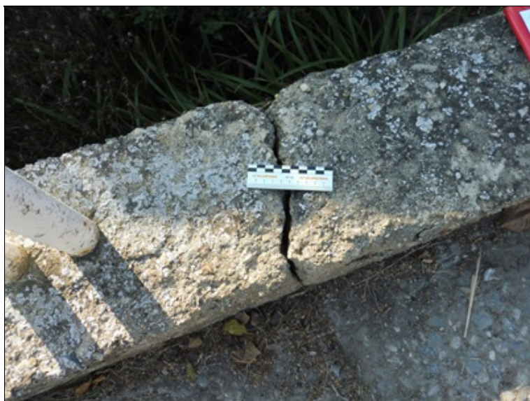
Levá římsa mostu.
