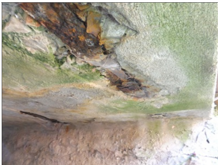
Podhled nosné konstrukce.
