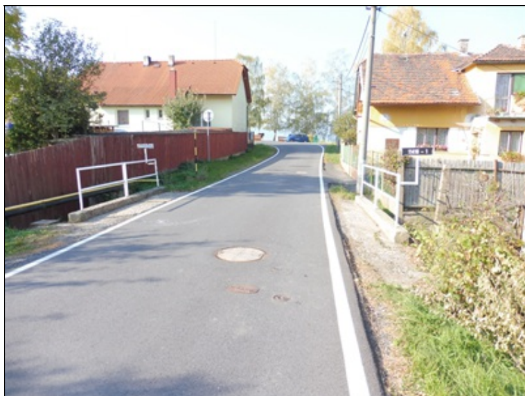
Pohled ve směru staničení.
