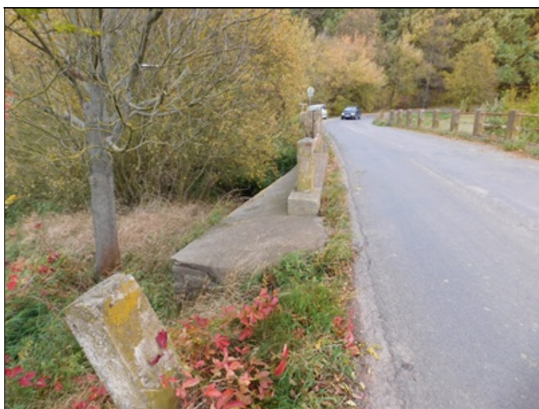
Levá krajnice, nabetonávka křídla opěry 1
