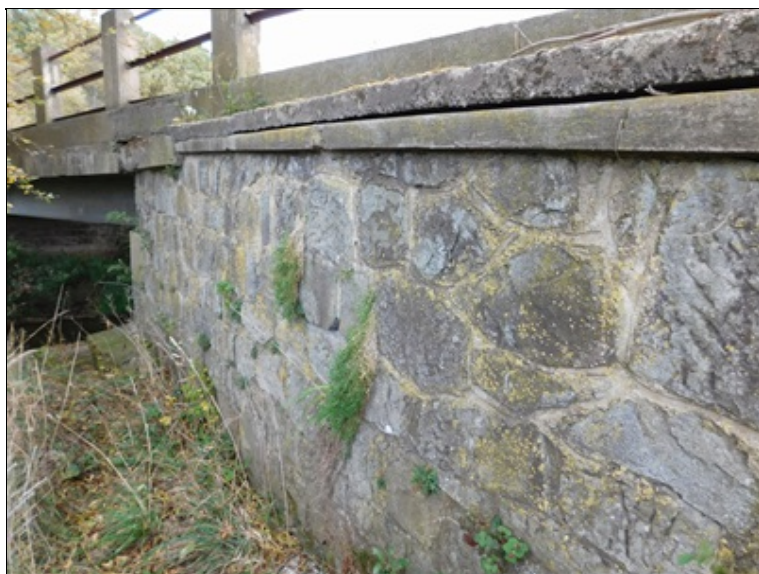
Oddělená nabetonávka říms křídél
