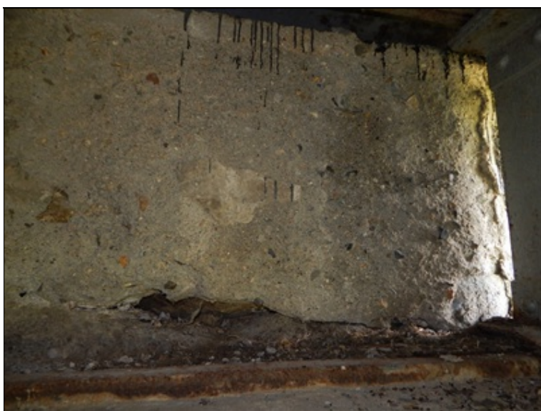
Spára v omítce a zdivu závěrné zídky
