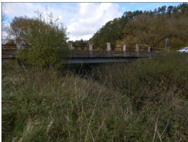
Pohled na most zprava
