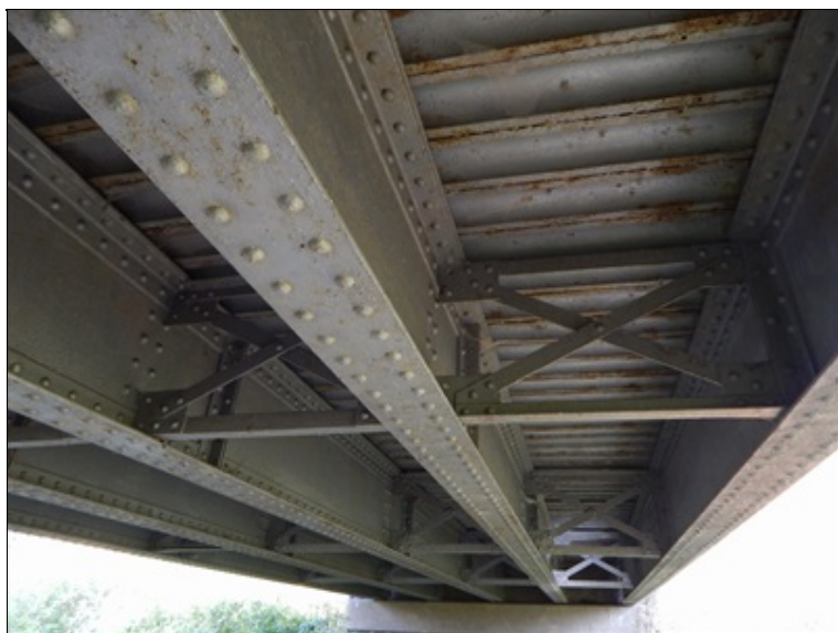
Podhled nosné konstrukce od opěry 1
