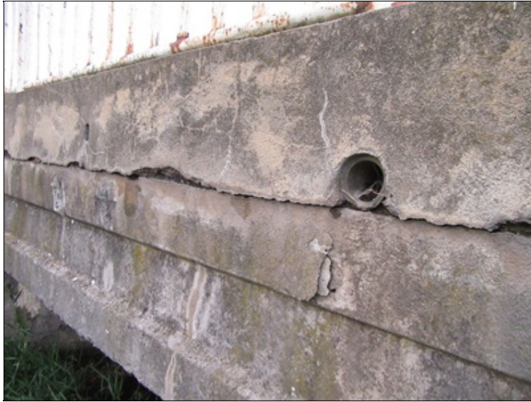
Levá strana mostu.
