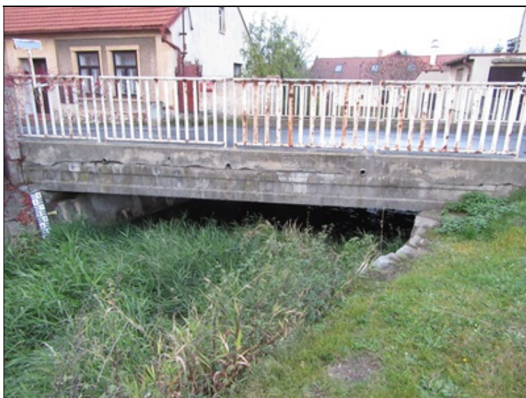
Levá strana mostu.
