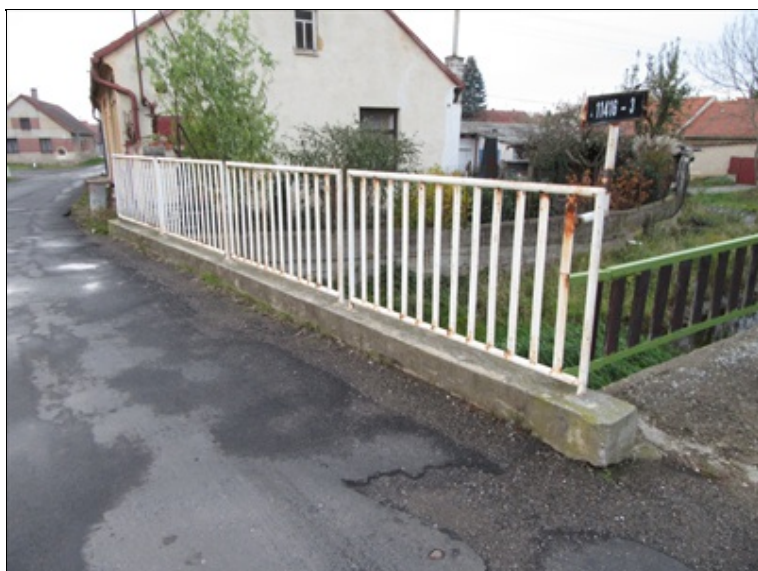
Pravá strana mostu.
