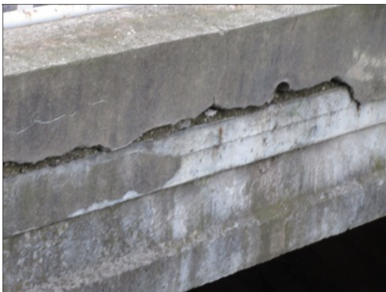
Pravá strana mostu.
