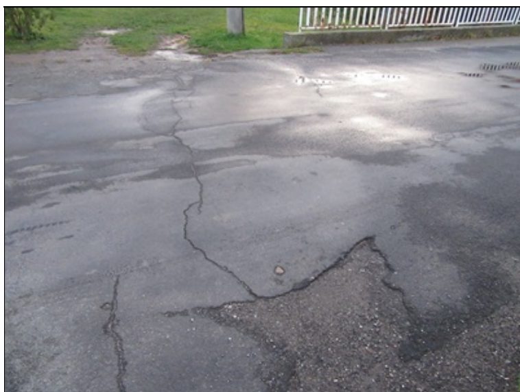
Vozovka před mostem.
