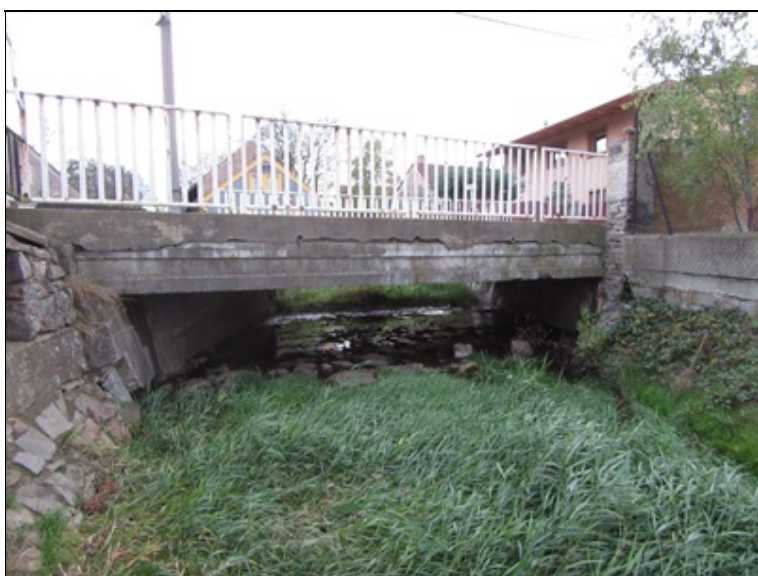
Pravá strana mostu.
