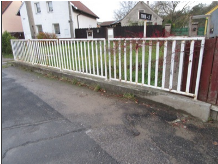
Levá strana mostu.
