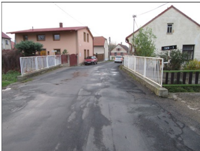
Pohled na most po směru staničení.
