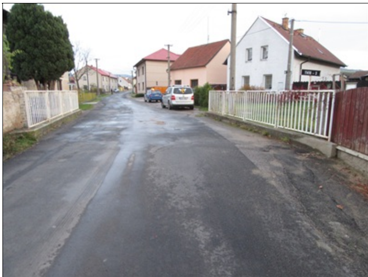
Pohled na most proti směru staničení.
