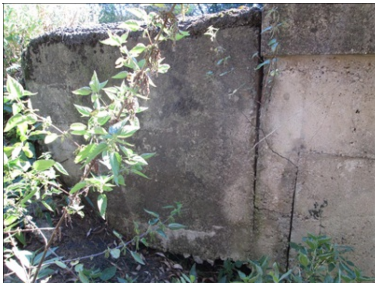
IMG_8762.JPG Otevřené spáry mezi OP a křídly OP
