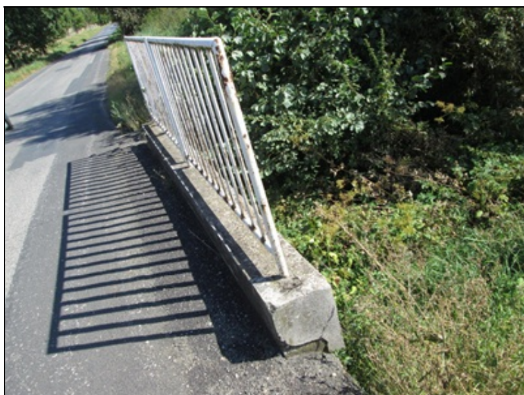
3-IMG_8752.JPG Pravá strana mostu
