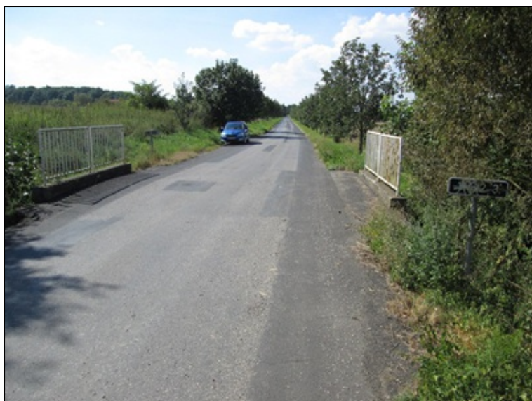
2-IMG_8756.JPG Pohled na most proti směru staničení.
