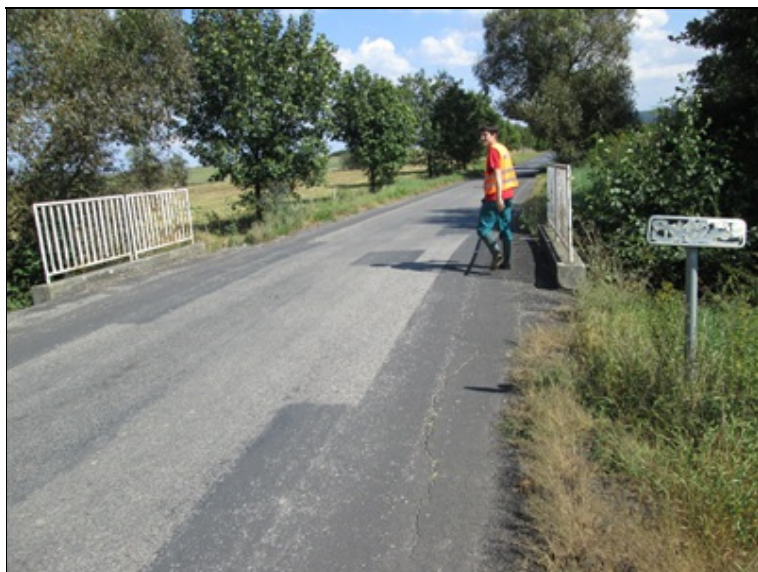
1-IMG_8751.JPG Pohled na most ve směru staničení.
