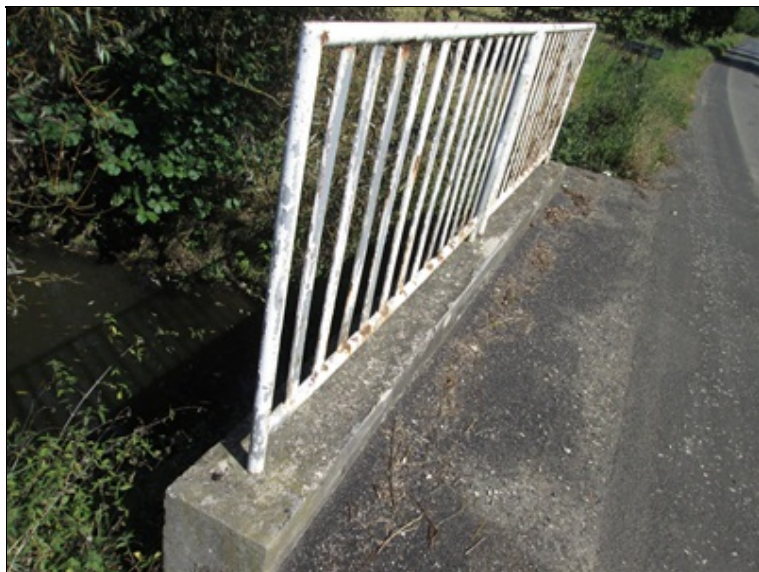
4-IMG_8754.JPG Levá strana mostu.
