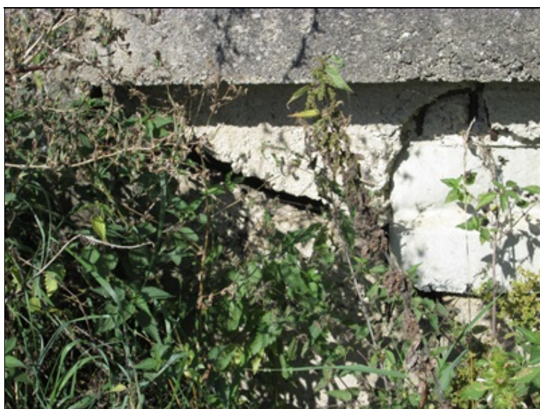
IMG_8768.JPG Otevřené spáry mezi OP a křídly OP
