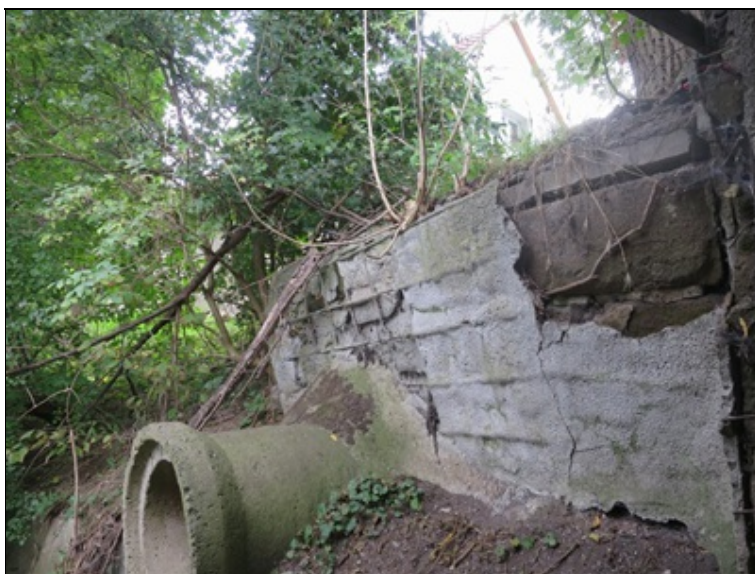
levé křídlo O3
