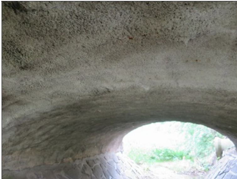
podhled klenbového pasu ve 2. poli
