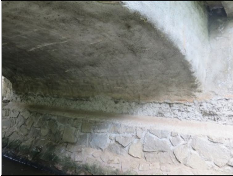
vetknutí klenbového pasu do O1
