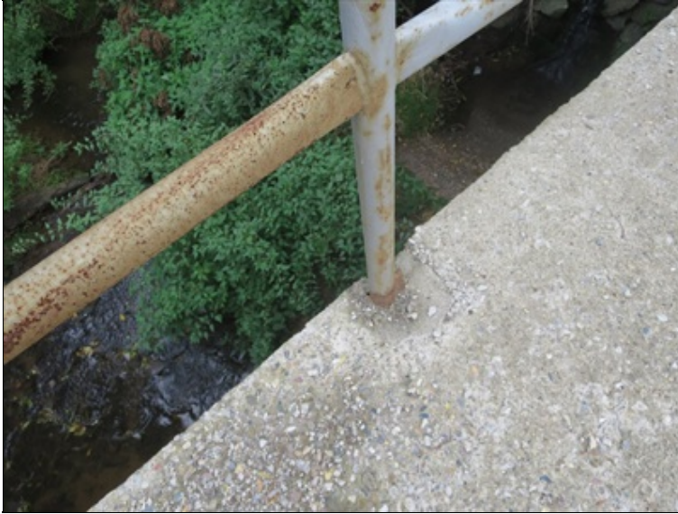
detail kotvení zábradlí do římsy
