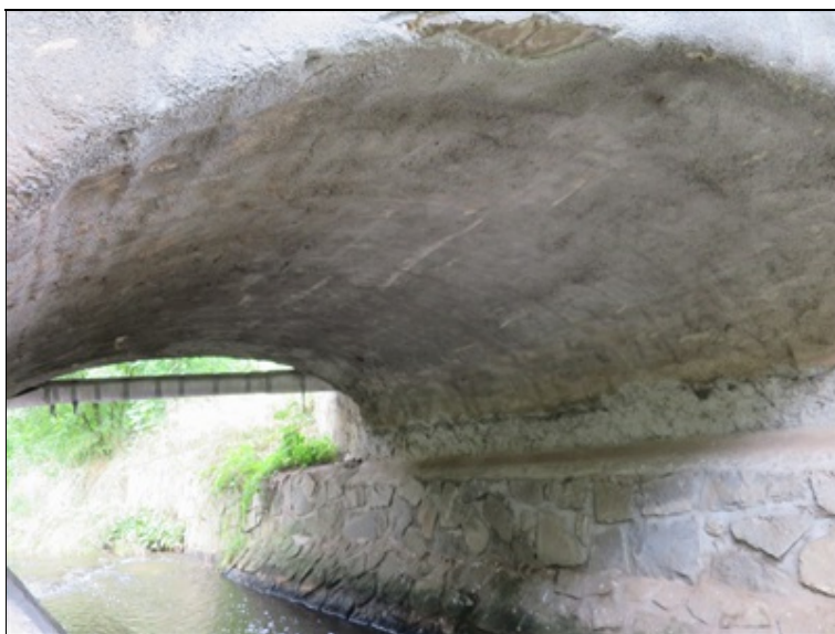
podhled klenbového pasu v 1. poli
