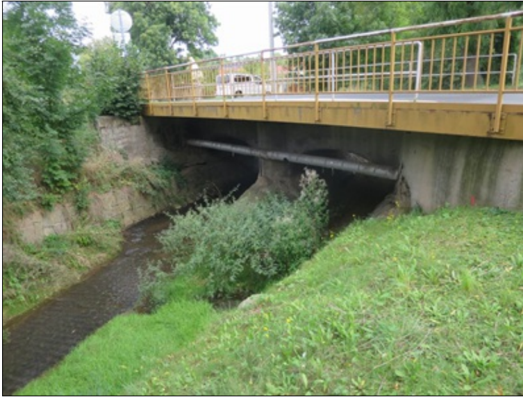
pohled na pravou stranu mostu
