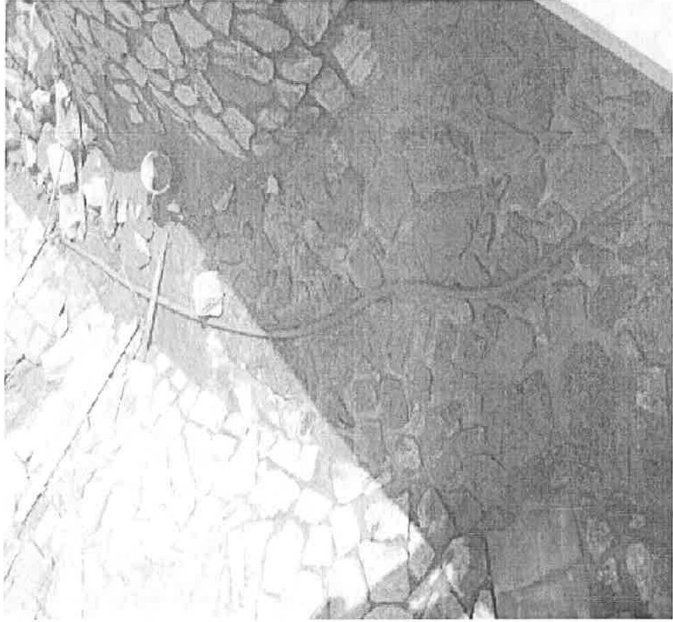
Obr. č. 4 čerpání vody během spárování základy z kamene - nátok
