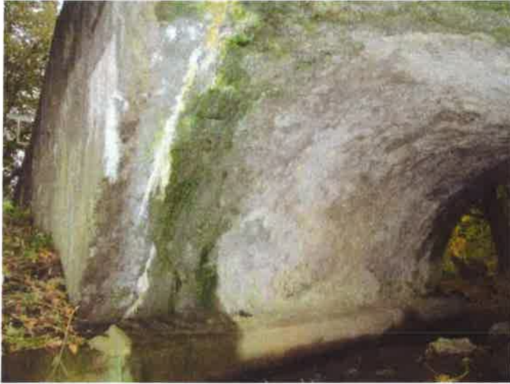
P strana klenby. Výluhy, mokré skvrny, biologické napadení.
