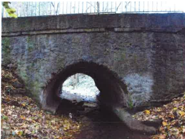
Pohled na levou stranu mostu.
