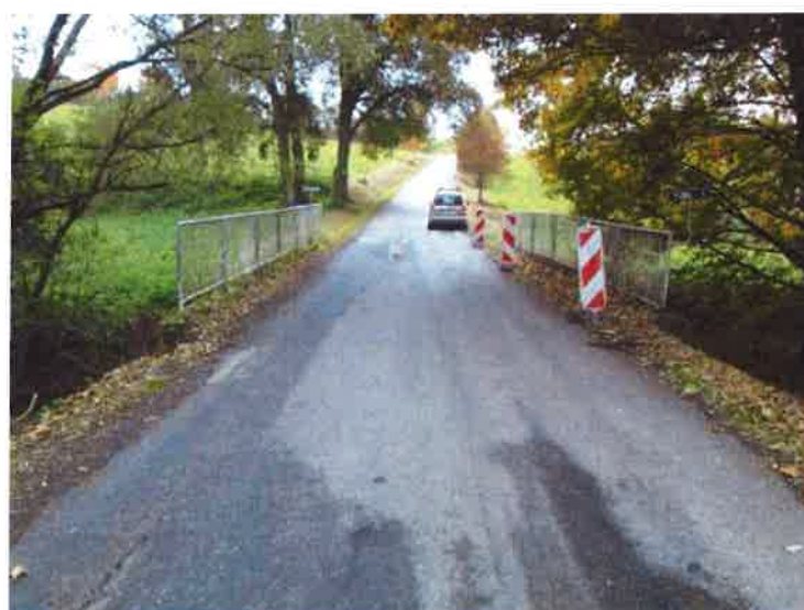
Pohled na most proti směru staničení.
