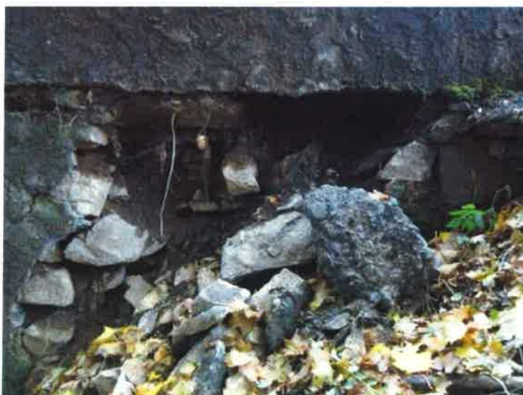
L křídlo OP1 - detail rozpadlé části.
