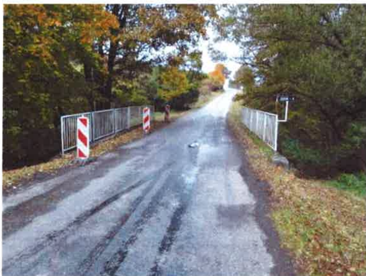
Pohled na most po směru staničení.
