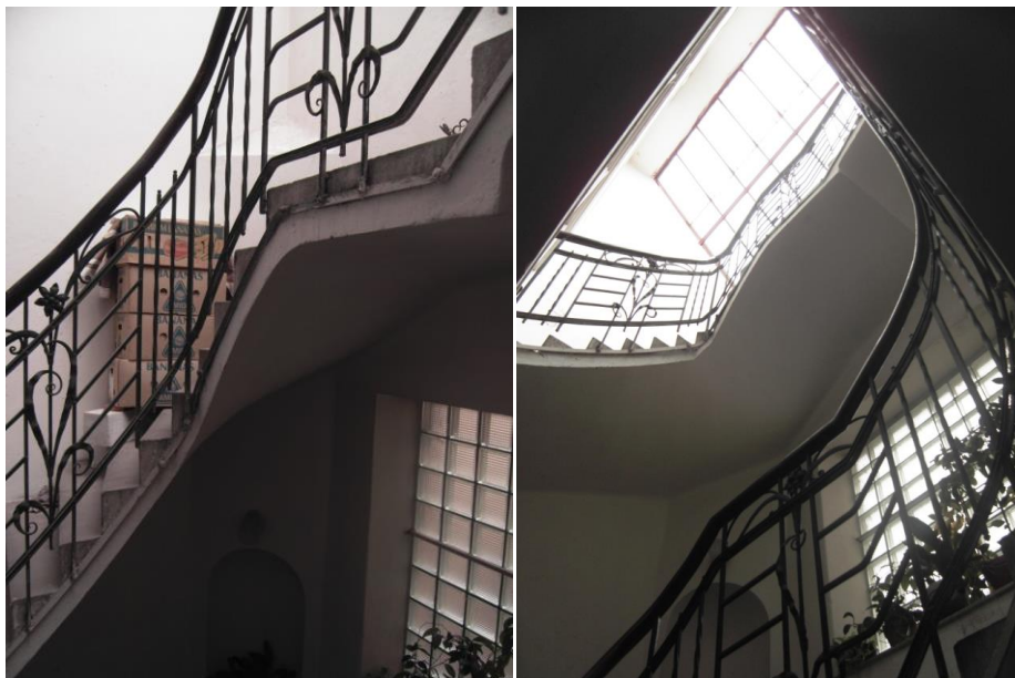
Pohled na ladnou křivku jednoramenného schodiště, které je součástí první přístavby.
