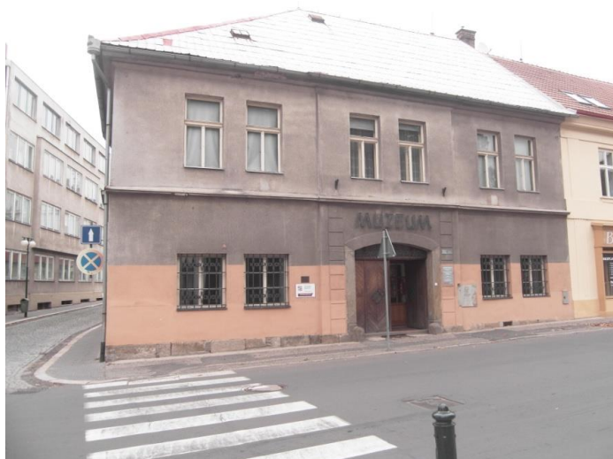
Stávající stav fasády objektu muzea
