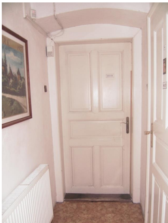
Pohled na typické původní ,masivní ,kazetové dveře.
