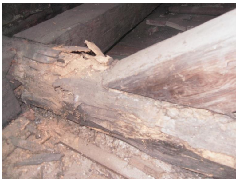
Pohled do krovu nad hlavní částí objektu. Část vazného trámu druhé plné vazby je poničen hnilobou
