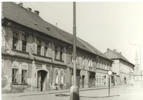
Objekt před rekonstrukcí fasády
