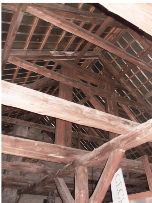
Pohled do krovu nad hlavní částí objektu. Část vazného trámu druhé plné vazby je poničen hnilobou
