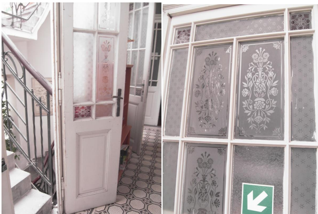
První patro je ve schodišti odděleno prosklenou stěnou s dvoukřídlými dveřmi. Původní Prosklení pískovanými skly s dekorem
