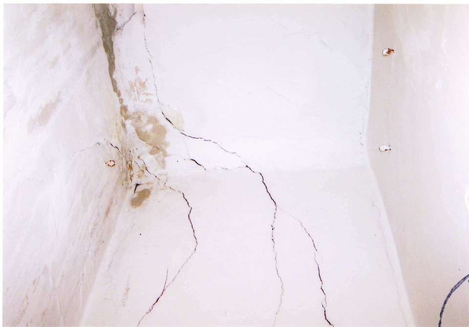
foto č. 9 – stav stropu komory ve 2.NP, patrn vliv zatékání
