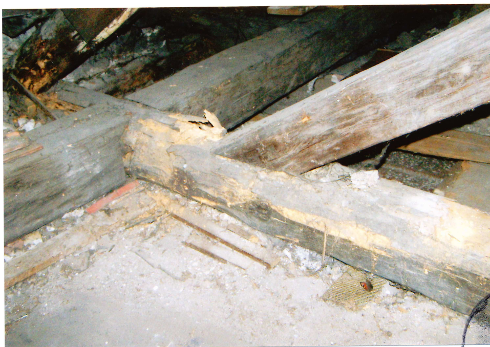
foto č. 6-detail poškození trámů Tesaříkem krovovým
