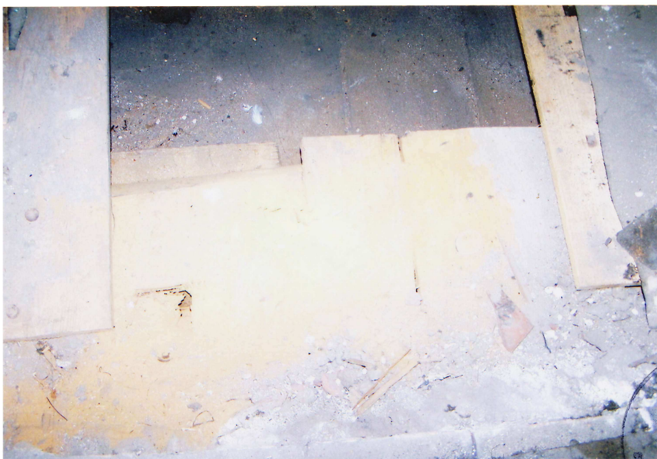
foto č. 2- stav stropního trámu nad 2.NP v sondě-poškození Tesaříkem krovovým
