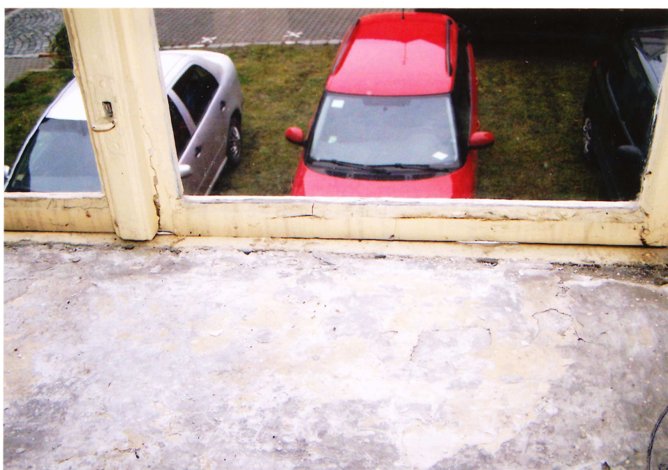
foto č. 10 – netěsnost okna a rozklížení středového profilu okna ve 2.NP
