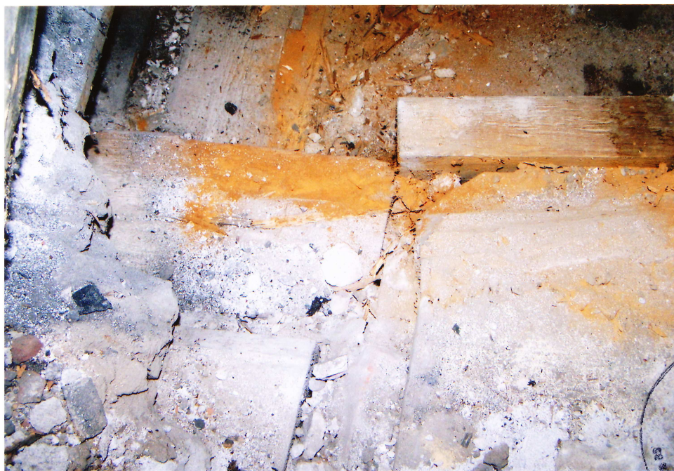
foto č. 1 - stav stropního trámu nad 2.NP v sondě-poškození Tesaříkem krovovým
