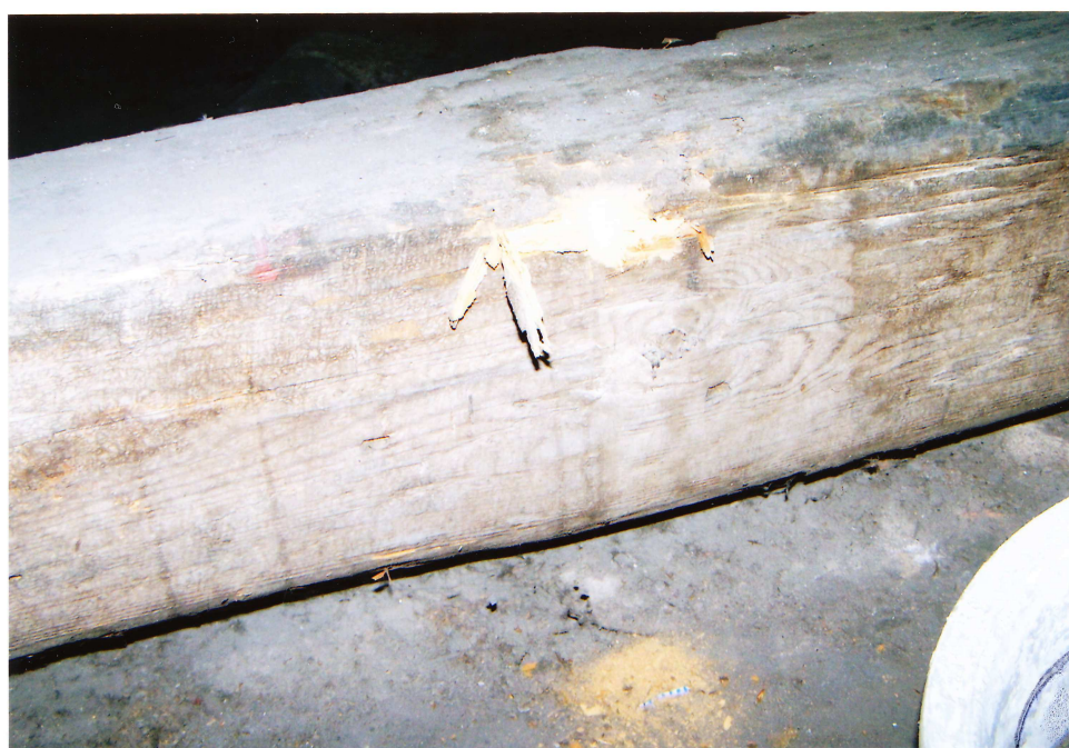
foto č. 8 - poškození vazného trámu Tesaříkem krovovým
