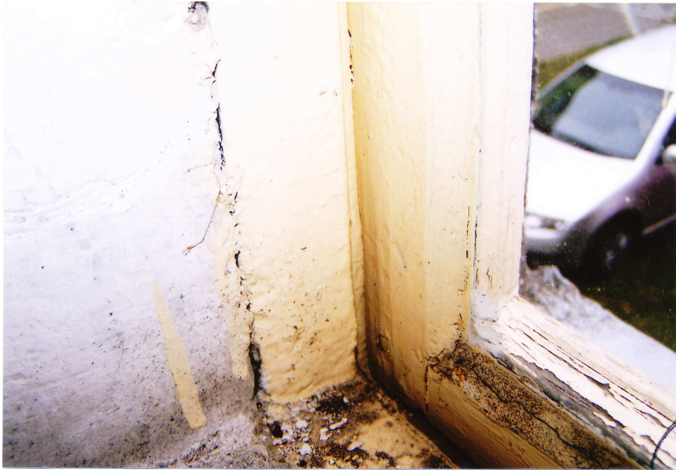
foto č. 13- začínající hniloba vnějšího okna ve 2.NP
