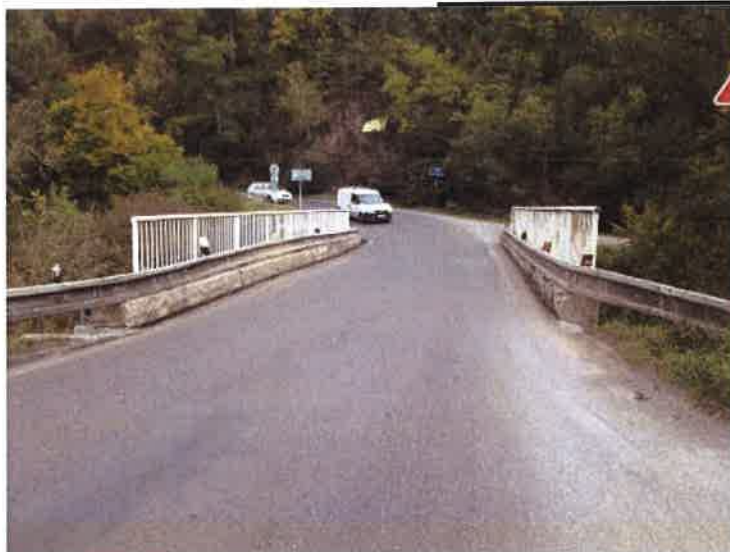
Pohled na most po směru staničení.
