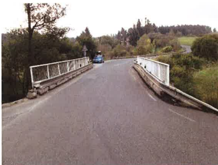
Pohled na most proti směru staničení.
