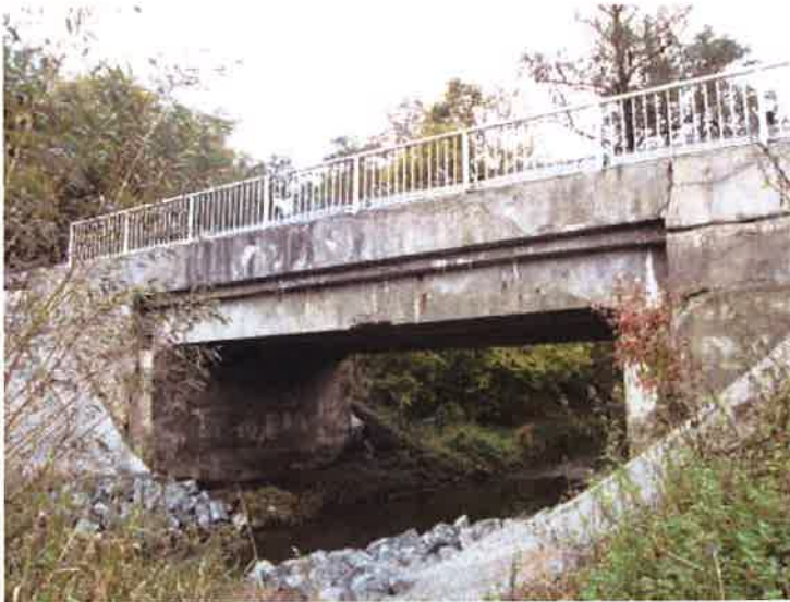
Pohled na levou stranu mostu.
