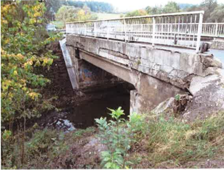
Pohled na pravou stranu mostu.
