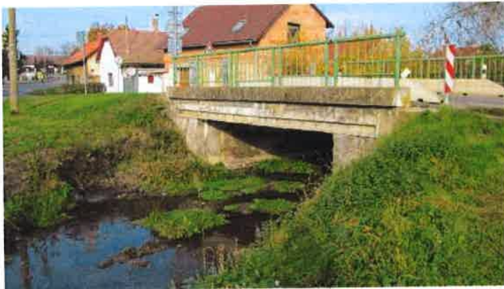
Pravá strana mostu
