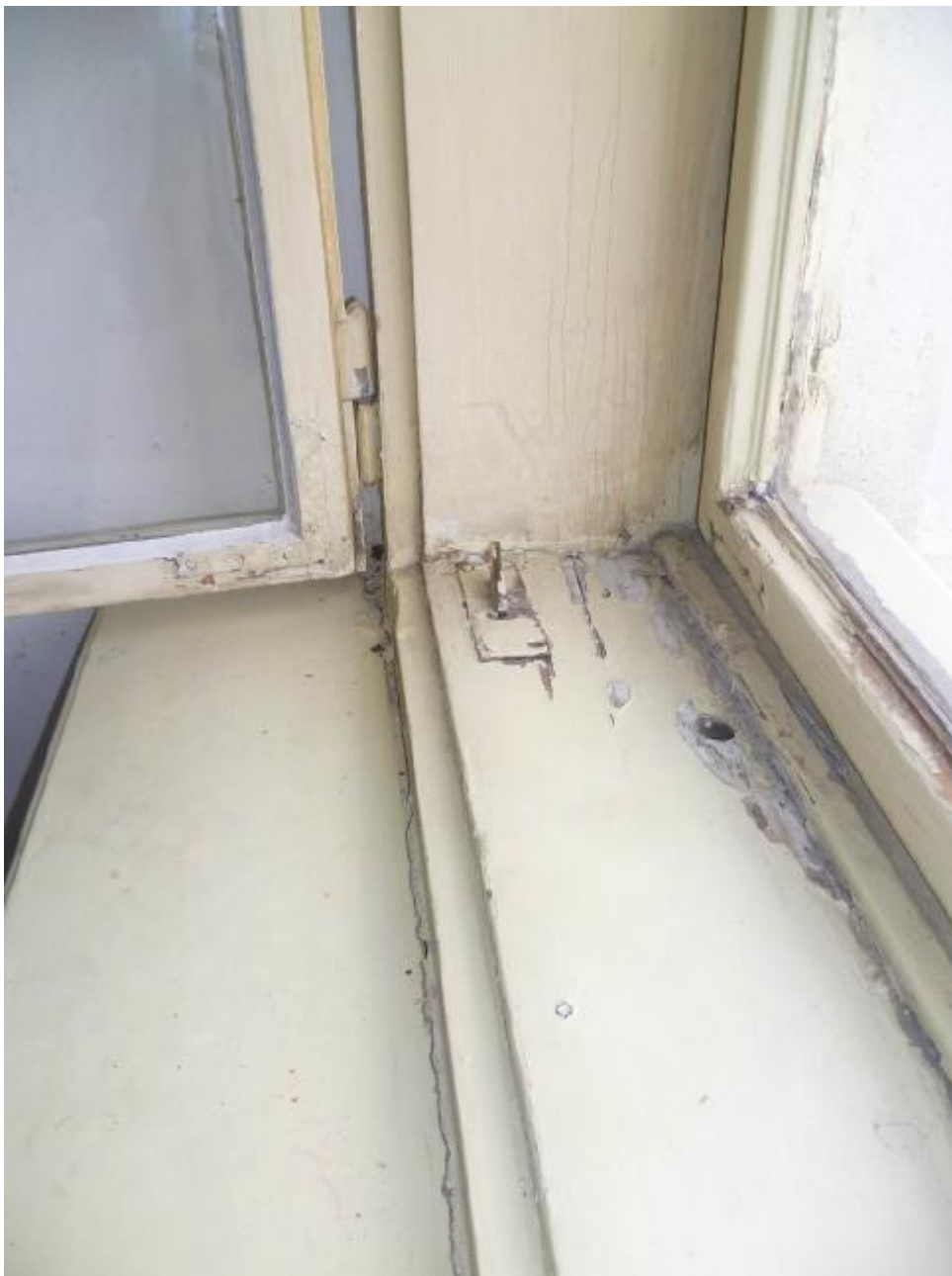
Obrázek 7 – současné špaletové okno – detail špaletového ostění
