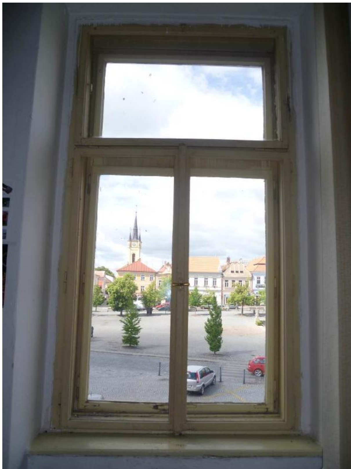
Obrázek 5 – současné špaletové okno - interiér
