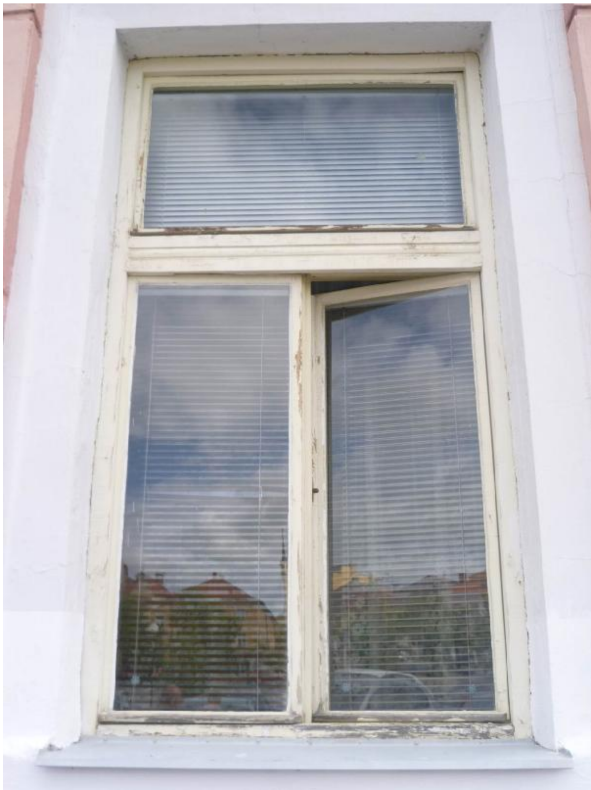
Obrázek 6 – současné špaletové okno - exteriér
