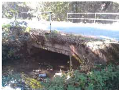
Pohled na levou stranu mostu.
