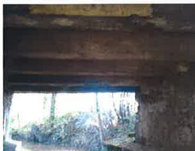
Pohled do mostního otvoru a podhled NK.
