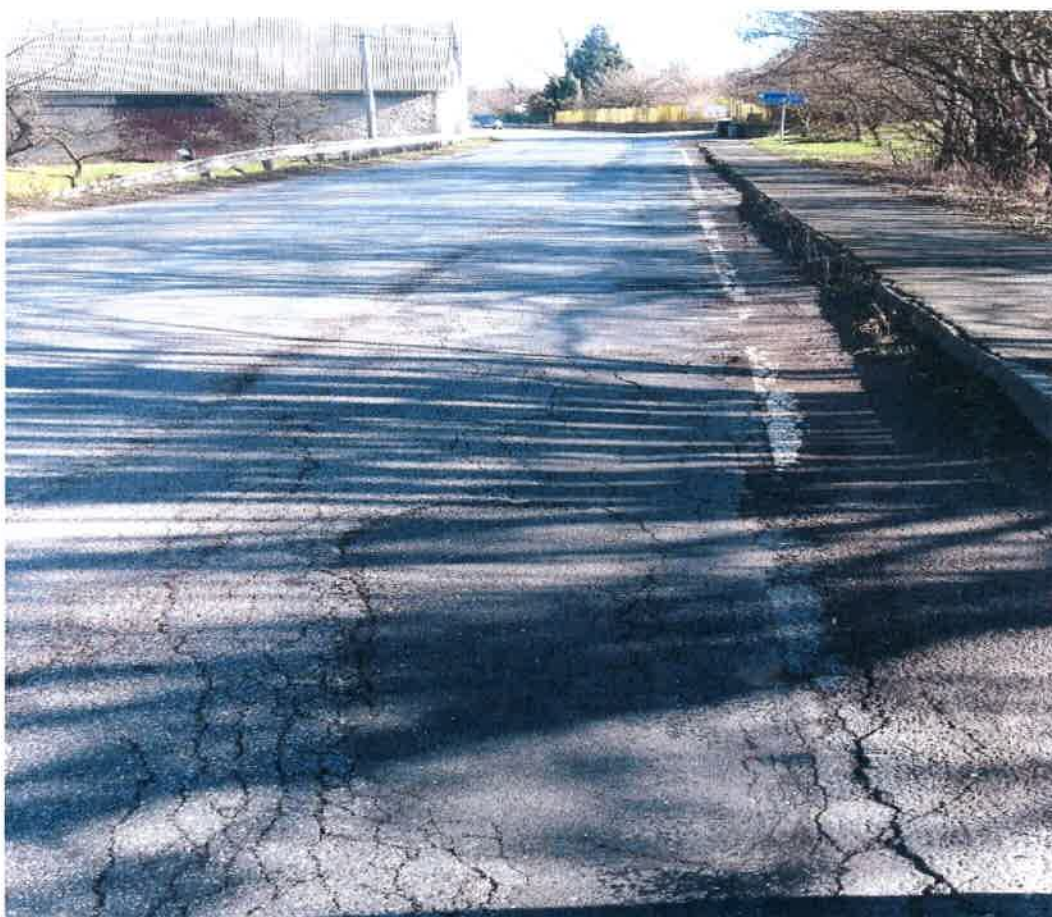
II/335 staničení cca 26,661
