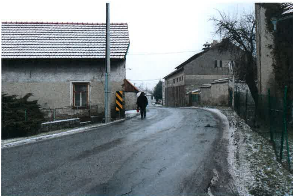
II/335 staničení cca 26,661
