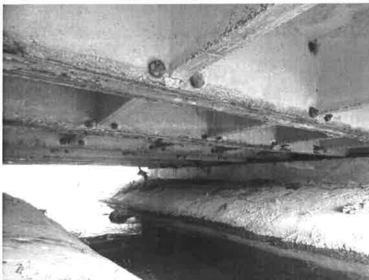
Detail separace krycí vrstvy a koroze betonářské výztuže. Koroze spojovacích šroubů.
