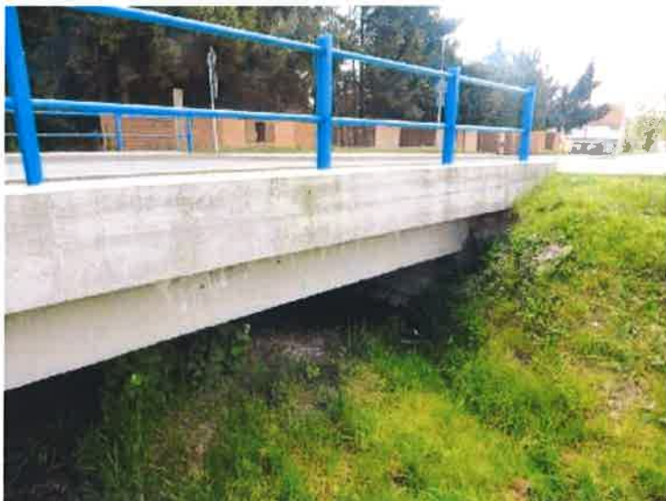
Pohled na pravý bok mostu.
