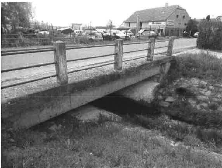
Pohled na pravý bok mostu.
