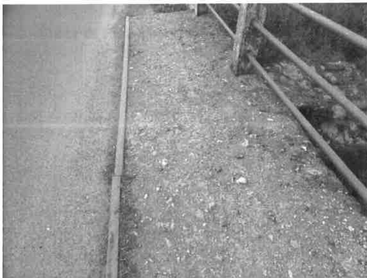
Hlubková plošná degradace horního líce betonového chodníku na pravé straně.
