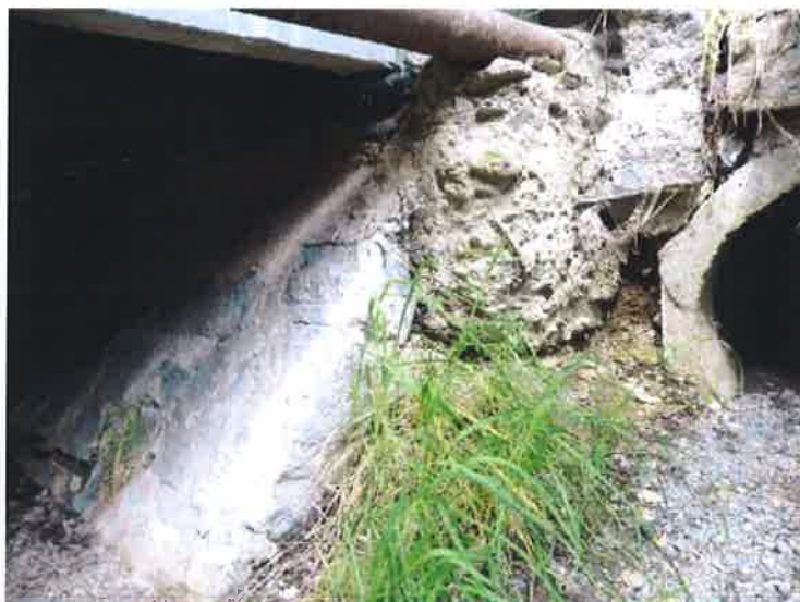
Nedostatečné podepření chráničky inženýrských sítí na levé straně opěry OP1.
