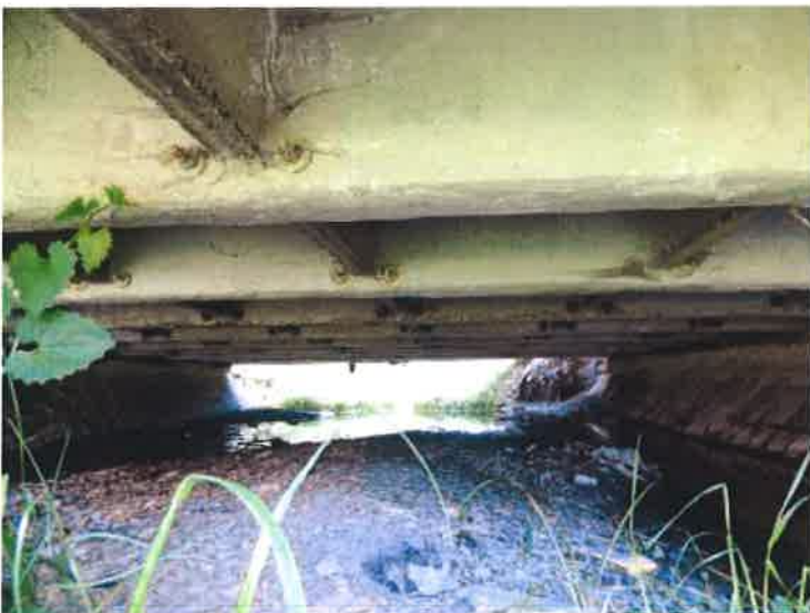
Spodní líc nosné konstrukce.
