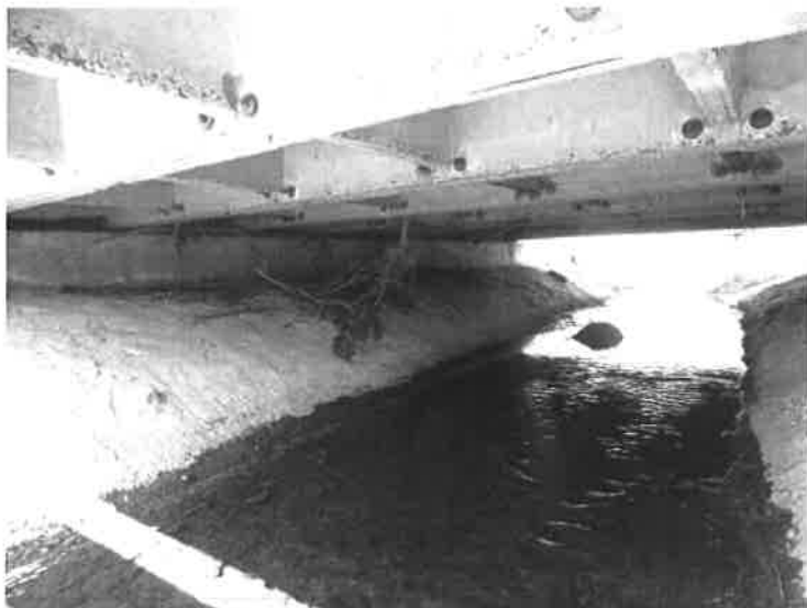
Spodní líc nosné konstrukce.
