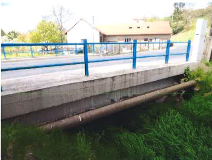
Pohled na levý bok mostu s dvojicí ocelových chrániček.
