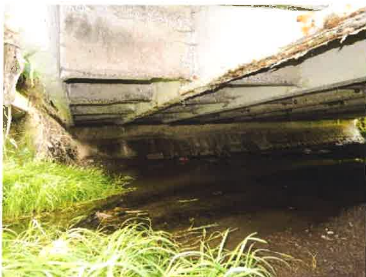
Silné průsaky ve spáře mezi nosníky, na spodní pásnici obnažená silně korodující betonářská výztuž.
