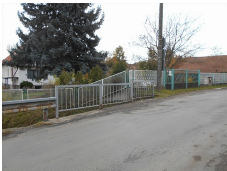
Pohled na levou stranu mostu-nevyhovující svodidlo, korodující zábradlí.JPG
