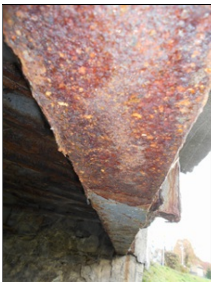
Korodující nosník z podhledu.JPG
