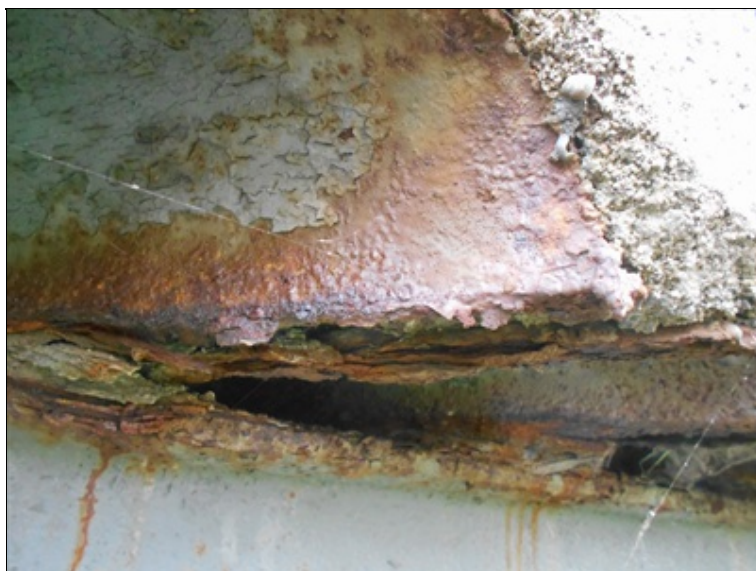
detail uložení zkorodované mostnice na korodující nosník.JPG
