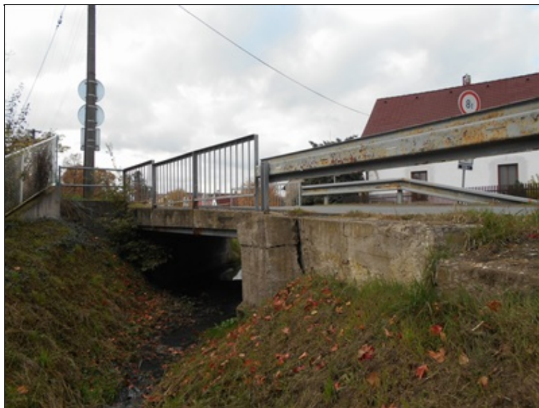
Pohled na levý bok mostu- popraskaný beton opěry a křídla.JPG
