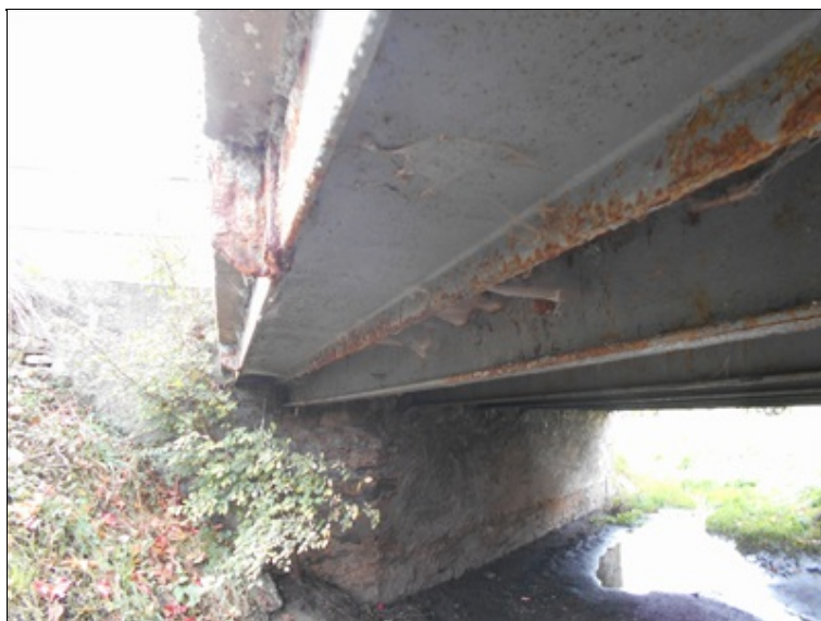
Pohled na O 2 -koroze nosníku, zdivo poškozené v úrovni tekoucí vody, zanesené koryto potoka,.JPG
