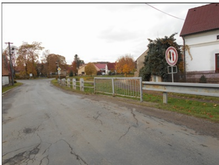
Pohled na pravou stranu mostu - nevyhovující svodidlo, korodující zábradlí.JPG
