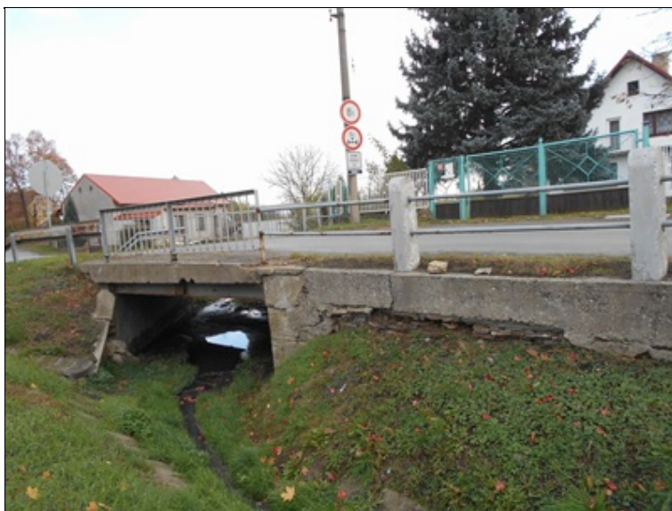
Pohled na most z pravé strany -poškozený beton římsy, zdivo křídla bez malty, rozvolněné, vyvalené vnějším směrem .JPG
