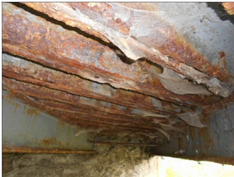
Nk z pod mostu - korodující mostnice Zorés a hlavní nosníky.JPG
