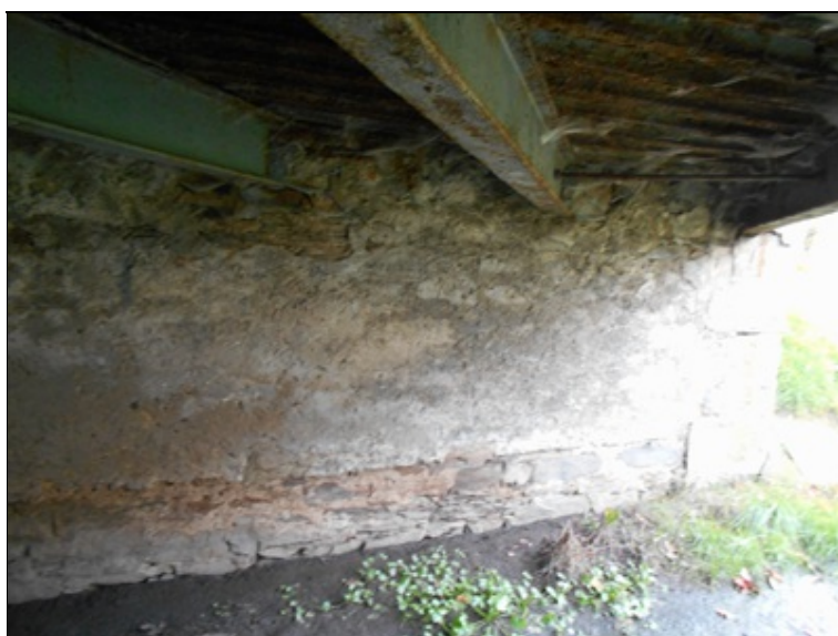
Pohled na O1-opadaná ochranná omítka, v úrovni protékající vody, vyplavená malta, nános bahna v korytě potoka.JPG
