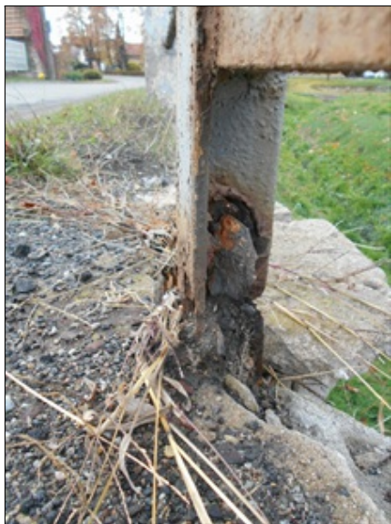
detail korodujícího sloupku zábradlí.JPG
