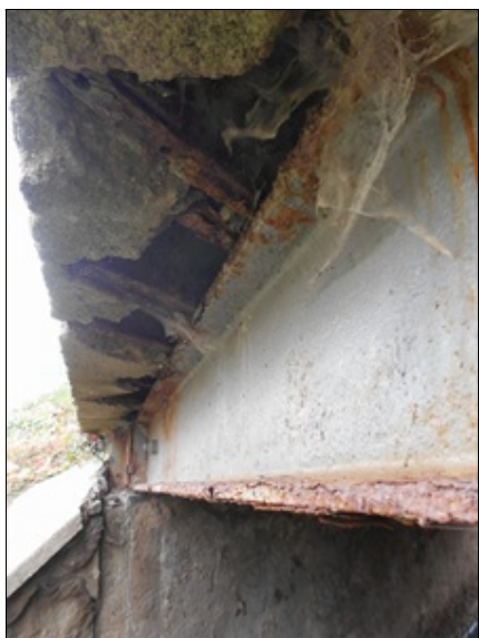
Pravá straně mostu-zkorodované mostnice, rozpadlá římsa, korodující nosník,.JPG
