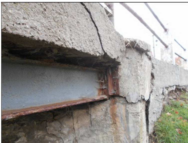
Stopy zatékání na pravém boku O2-korodující nosník, poškozené zdivo opěry a hlavně křídla.JPG
