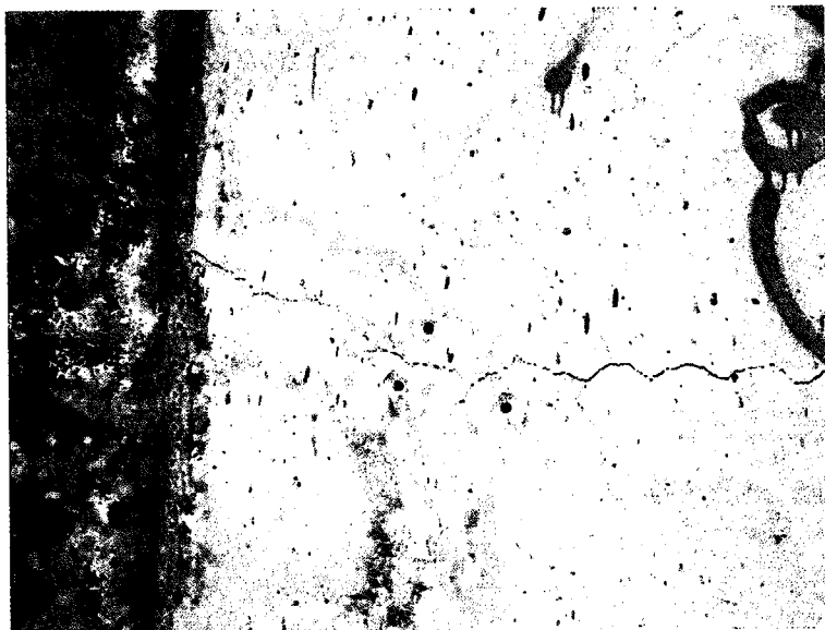
pilíř P5 typická síť převážně horizontálních a svislých trhlin, slabé výkvěty; zkušební místo odběru vzorku RCT 2
