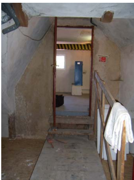
Přístupová cesta ke strojovně
