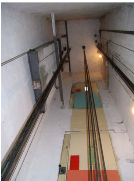
Vrchní část šachty
