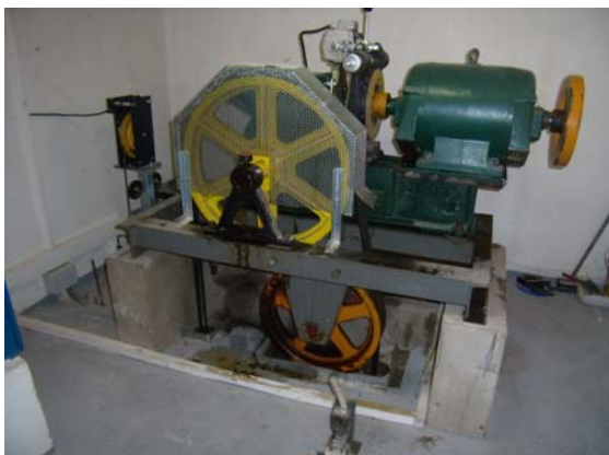
Původní výtahový stroj s odkláňcí kladkou
