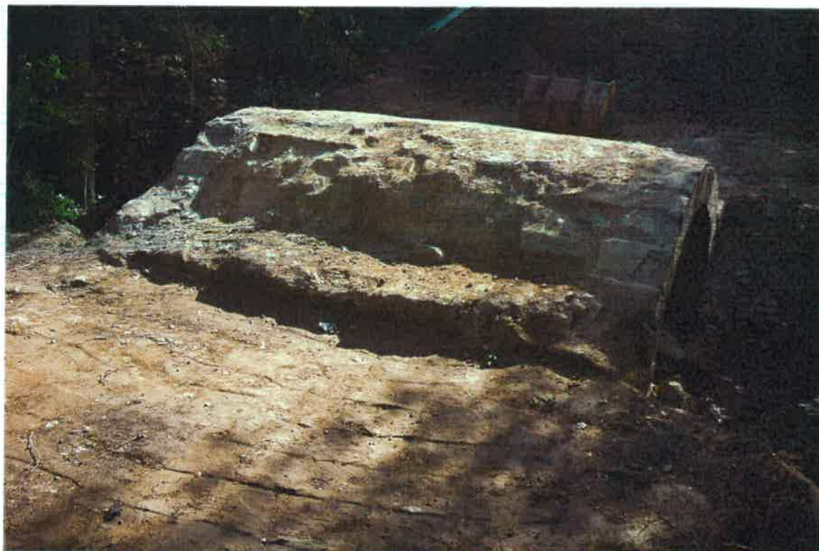
III/11320 Zvánovice, oprava mostu ev.č. 11320-2
