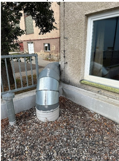
Vzt jihozápadní roh objektu
