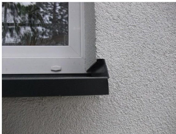
Obrázek 2 Detail zatažení parapetního plechu do ostění
