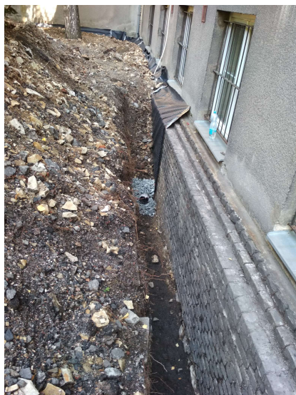
obr.6 odvlhčování suterénního zdiva v r 2019
