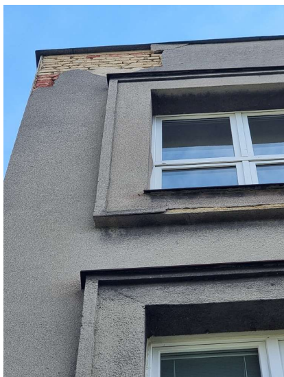
obr. 1-3. poškození omítek
