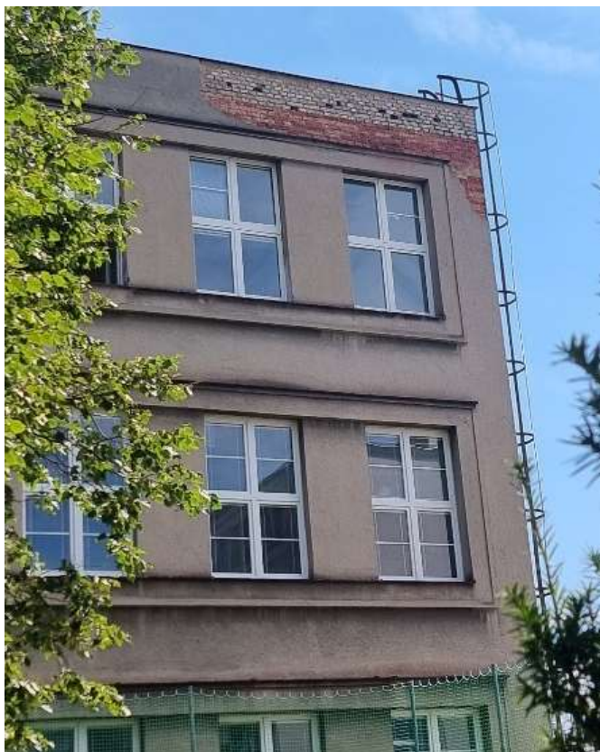
obr.4 atika západní fasády
