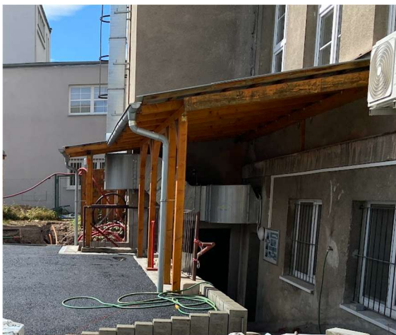
obr.11 přístřešky do dvora
