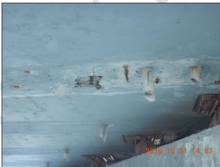
Foto 14: Detail koroze měkké výztuže v místě odvodňovačů u členěné podpěry P2; patrná koroze měkké a degradace krycí vrstvy betonu
