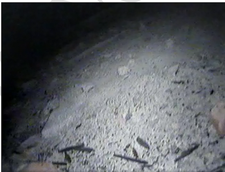
Foto 18: Pohled na spodní líc dutiny mezi nosníky; na fotografii patrné korozní zplodiny měkké výztuže dobetonávky
