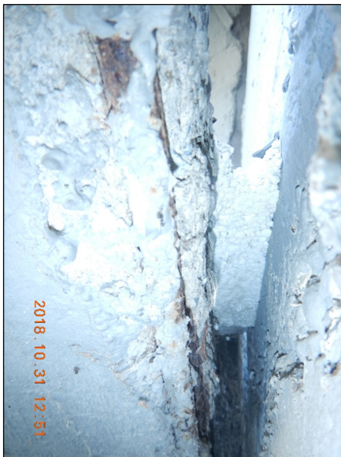
Foto 37: Detail dilatace mezi nosnou konstrukcí a opěrou O1; z fotografie patrný expandovaný polystyren v dilatační spáře
