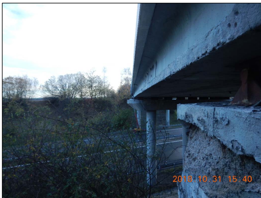
Foto 47: Pohled na opěru O4 směrem od Prahy; vysoká degradace povrchových vrstev betonu a hloubkové až extrémní koroze výztuže; patrné odlupování povrchových vrstev betonu
