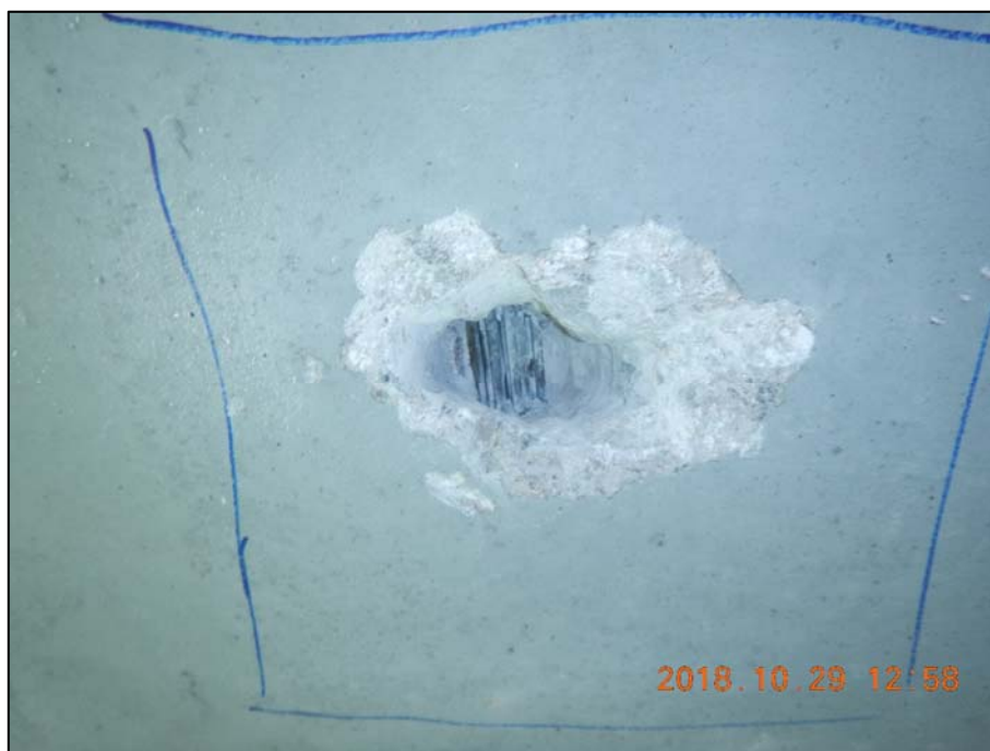
Foto 3: Pohled na sondu 2, která byla provedena v krajním nosníku středního pole směrem od Karlových Varů; osa předpínacího lana cca 450 mm od kraje nosníku, krytí lana cca 61 mm na hranu
