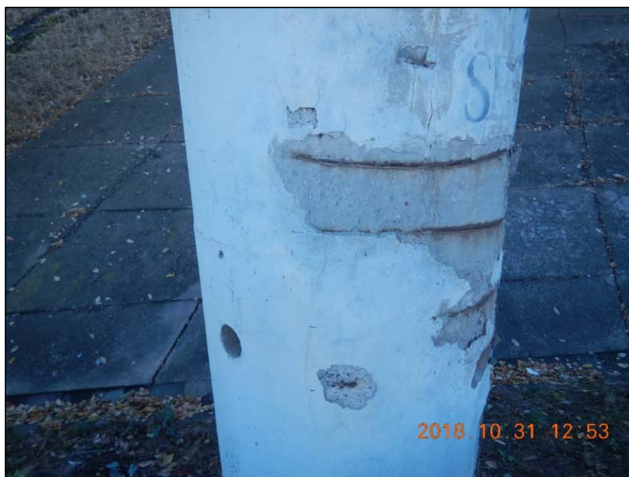
Foto 55: Detail chybějící krycí vrstvy betonu a silně až hloubkově korodující výztuže středního sloupu členěné podpěry P2
