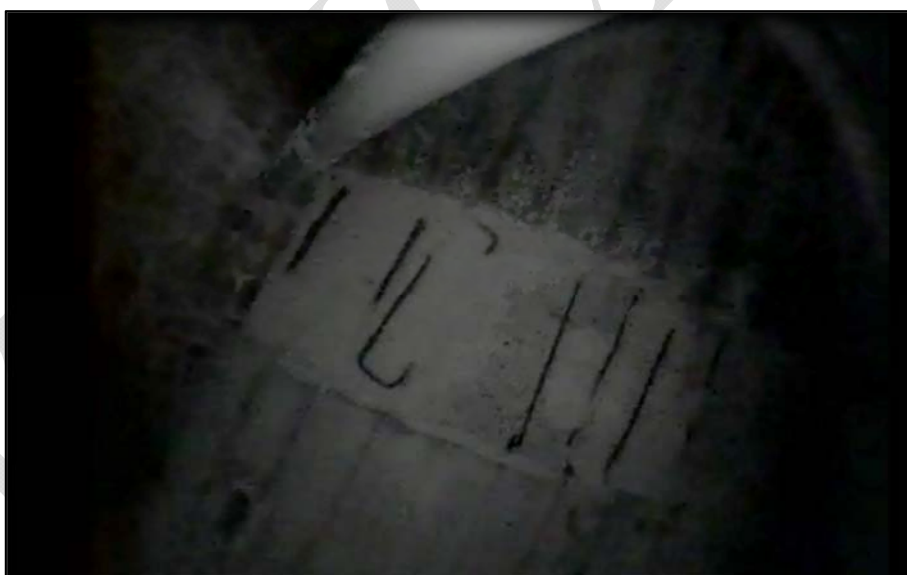
Foto 22: Pohled na konec nosníku krajního pole v místě opěry O4; na snímku patrné stopy po zatékání, koroze měkké výztuže dobetonávky a probíhající PE trubky odvodnění z vozovky
