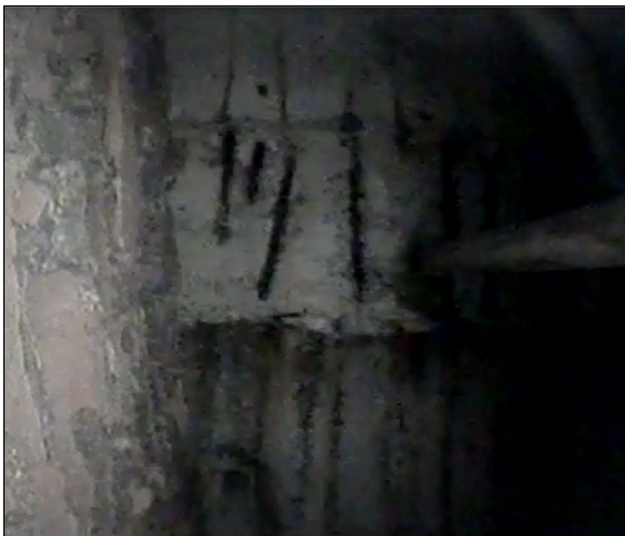
Foto 17: Pohled na konec nosníku krajního pole v místě podpěry 2; na snímku patrné stopy po zatékání, koroze měkké výztuže dobetonávky a probíhající PE trubky odvodnění z vozovky, včetně vyzdívky mezi nosníky
