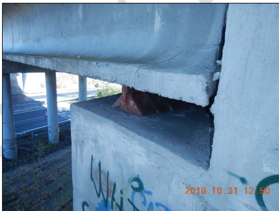
Foto 34: Pohled na uložení nosné konstrukce na úložný práh opěry O1 směrem od Karlových Varů; nosná konstrukce uložena na pevných ocelolitinových kloubech; v místě uložení trhlin v I-nosníku (detail viz foto 35 a 36)
