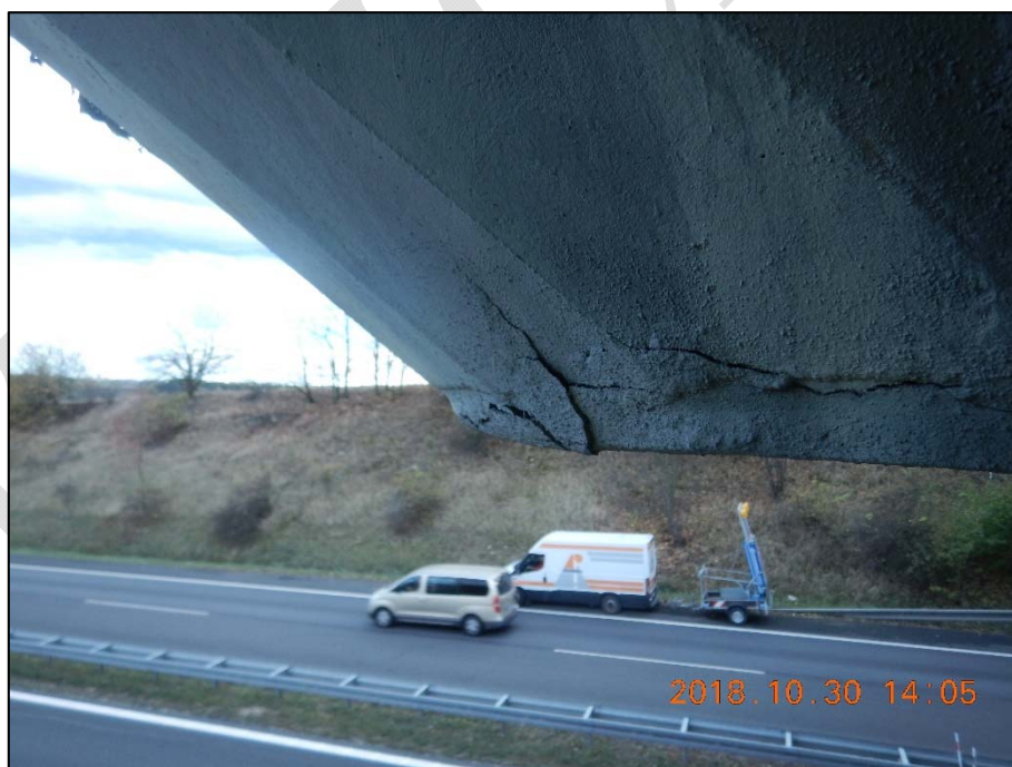
Foto 20: Detail spodního líce a boku úložného prahu na členěné opěře P3; degradace povrchové vrstvy betonu a patrné stopy po stékání dešťové vody
