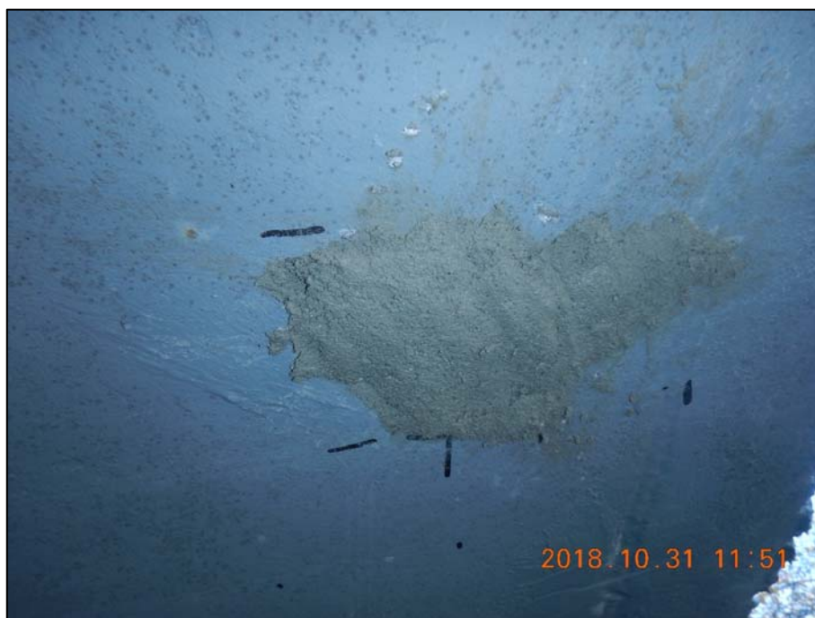
Foto 9: Pohled na zasanovanou sondu 4; sanace provedena hmotou Premix San B R2
