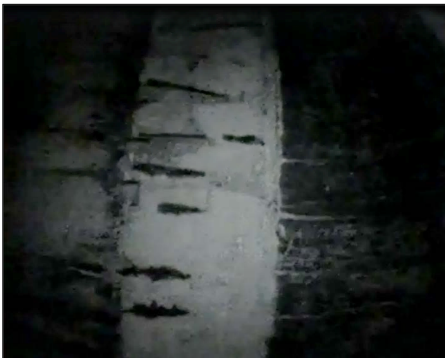
Foto 15: Pohled na dobetonávku a nosníky u horního líce nosníků krajního pole u podpěry P2; na fotografii patrná koroze měkké výztuže dobetonávky a nosníků, patrné stopy po zatékání vody podél dobetonávky
