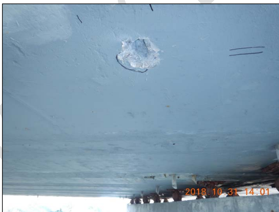
Foto 10: Pohled na sondu 5, která byla provedena mezi opěrou O1 a podpěrou P2 v krajním nosníku směrem od Prahy; osa předpínacího lana cca 270 mm od kraje nosníku, krytí lana cca 55 mm na hranu
