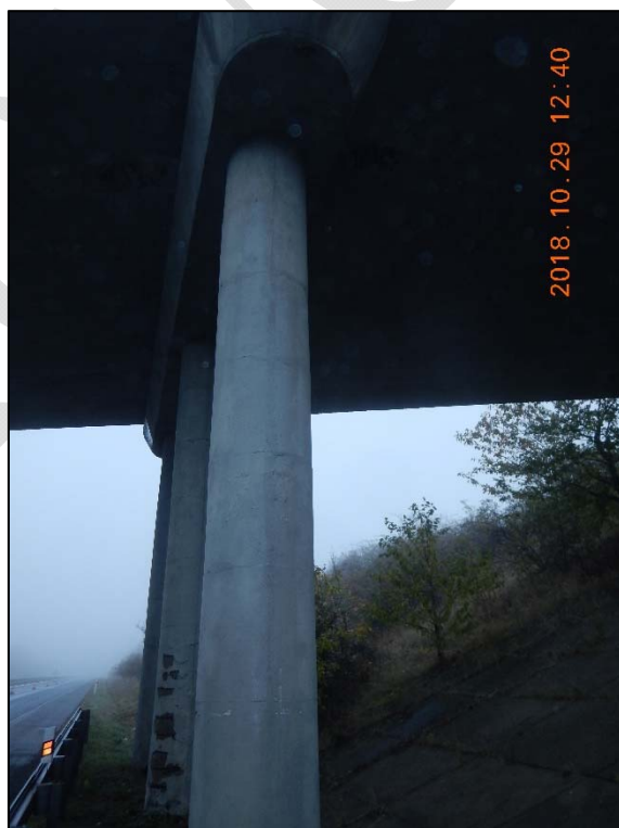
Foto 18: Pohled na první sloup v řadě členěné opěry P3; na fotografii patrná všesměrná síť trhlin s výkvěty solí; pohled od Prahy směr Karlovy Vary; na středním sloupu patrná degradace krycí vrstvy betonu
