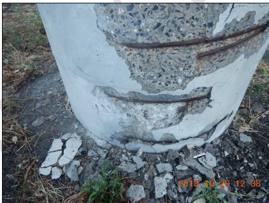
Foto 50: Detail chybějící krycí vrstvy betonu a silně až hloubkově korodující výztuže středního sloupu členěné podpěry P3; hloubka degradace povrchu betonu cca 50 mm
