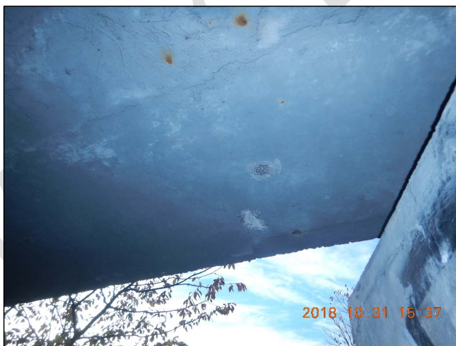
Foto 12: Pohled na sondu 6, která byla provedena mezi podpěrou P3 a opěrou O4 v krajním nosníku směrem od Karlových Varů; osa předpínacího lana cca 380 mm od kraje nosníku, krytí lana cca 66 mm na hranu
