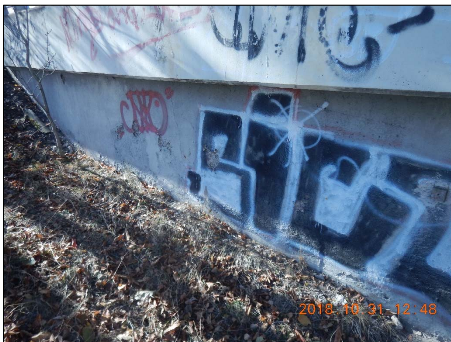
Foto 29: Pohled na křídlo opěry O1 směrem od Prahy; patrné odlupování se krycí vrstvy betonu (detail viz foto 30)
