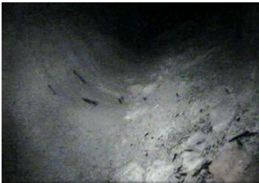
Foto 19: Pohled na spodní líc dutiny mezi nosníky; na fotografii patrné korozní zplodiny měkké výztuže dobetonávky a koroze měkké výztuže nosníku
