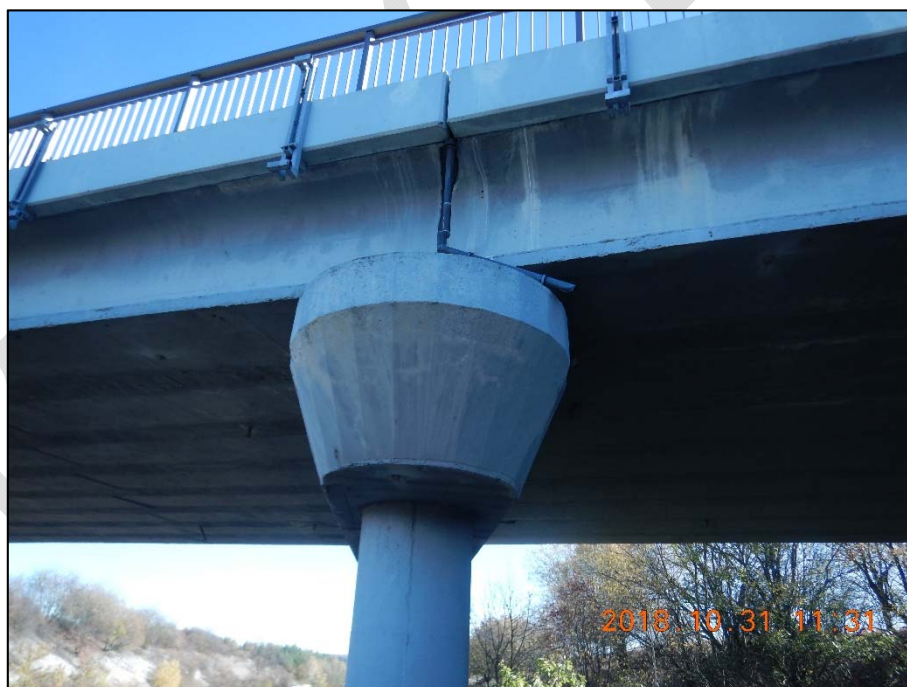
Foto 26: Pohled na uložení nosné konstrukce na úložný práh na členěné podpěře P2; na fotografii patrné stopy po stékání vody z vozovky; pohled ze směru od Karlových Varů na Prahu
