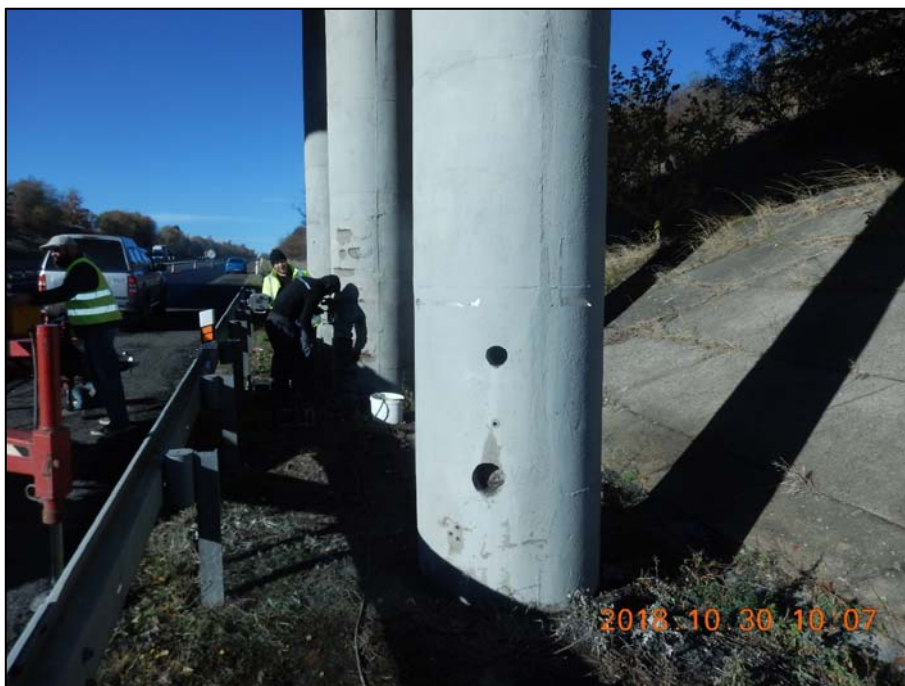
Foto 51: Pohled na členěnou podpěru P3; na prvním sloupu ze směru od Prahy provedeny vývrty V1 ( \varnothing 95 mm) a V3 ( \varnothing 140 mm)
