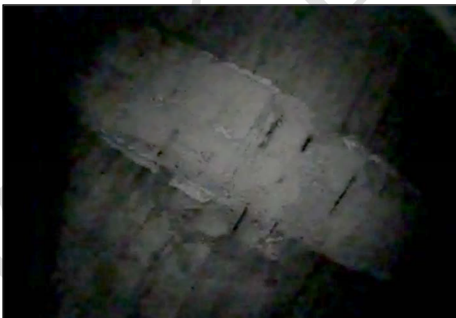
Foto 4: Pohled na dobetonávku u horního líce nosníků uprostřed rozpětí středního pole; na fotografii patrná koroze měkké výztuže dobetonávky
