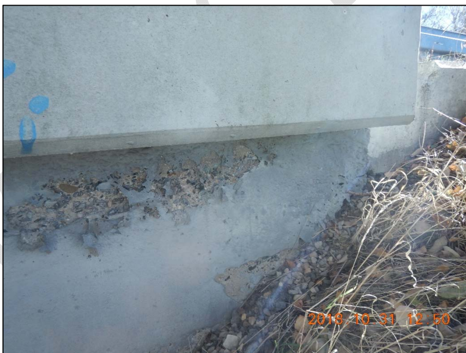
Foto 32: Detail odlupování se krycí vrstvy betonu
