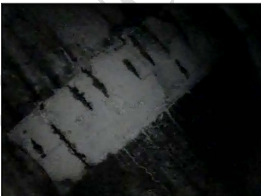
Foto 16: Pohled na dobetonávku a nosníky u horního líce nosníků krajního pole u podpěry P2; na fotografii patrná koroze měkké výztuže dobetonávky a nosníků, patrné stopy po zatékání vody podél dobetonávky a tvorba výluhů
