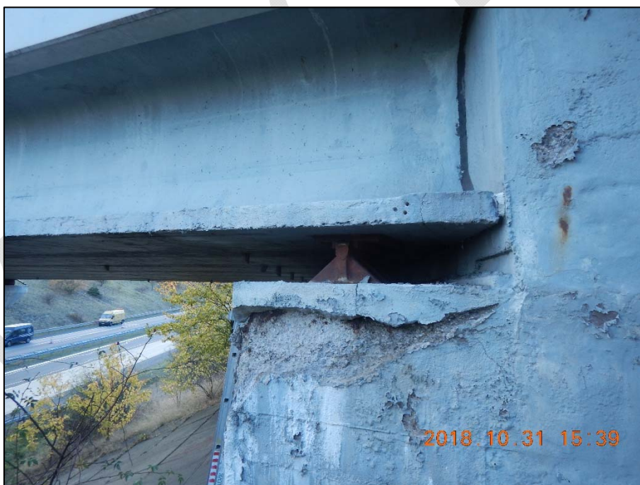
Foto 44: Pohled na uložení nosné konstrukce na úložný práh opěry O4 směrem od Prahy; nosná konstrukce uložena na pevných ocelolitinových kloubech; v místě uložení trhlina v I-nosníku (detail viz foto 45)
