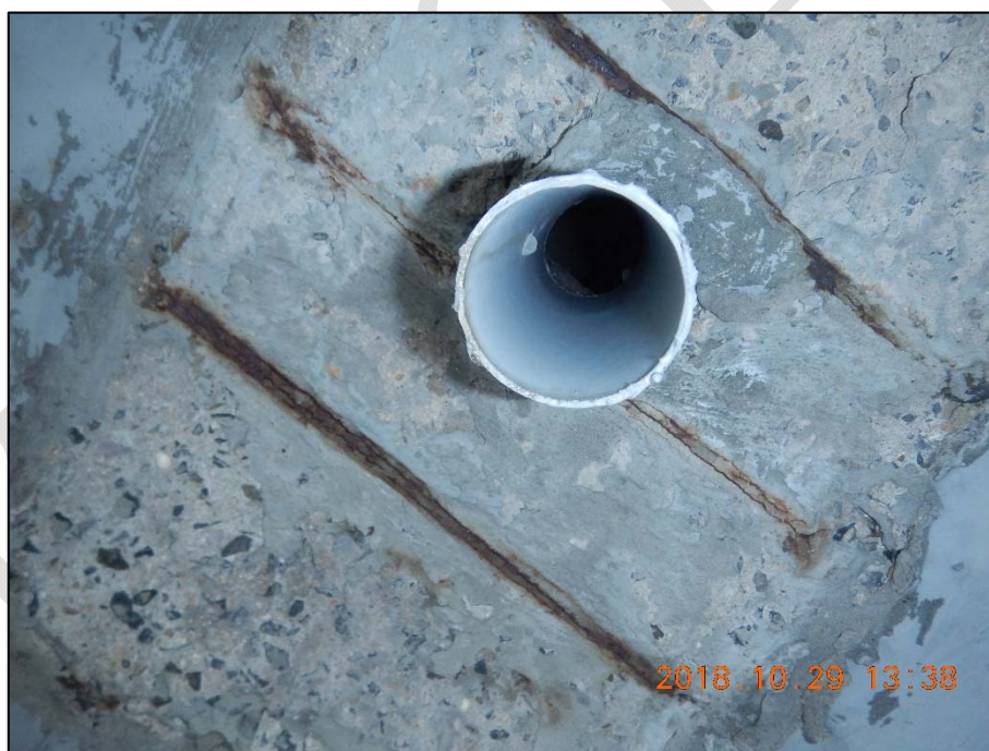
Foto 6: Detail korozní měkké výztuže v místě odvodňovače (viz Foto 5); patrná hloubková až extrémní korozní výztuže s tvorbou korozních zplodin; bez podrobnějšího průzkumu nelze stanovit přesnou míru korozní
