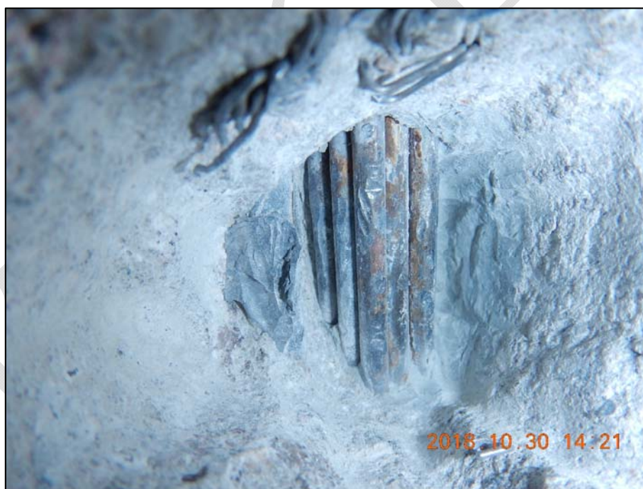
Foto 6: Detailní pohled do sondy 3, která byla provedena mezi podpěrou P3 a opěrou O4 v krajním nosníku směrem od Prahy; osová vzdálenost předpínacího lana od kraje nosníku je 240 mm, krytí lana cca 52 mm; sondou odkryto 7 drátů průměru 4,5 mm; na viditelných drátech patrná povrchová koroze
