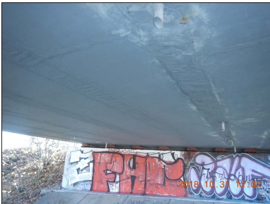
Foto 3: Pohled na spodní líc nosné konstrukce opatřené ochranným nátěrem / stěrkou a opěru O1, přes kterou jsou provedeny grafity
