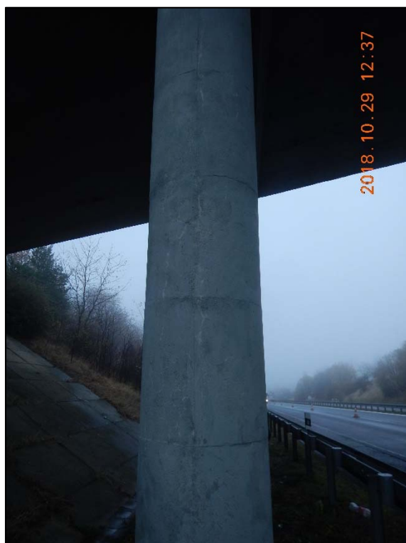
Foto 17: Pohled na první sloup v řadě členěné opěry P3; na fotografii patrná všesměrná síť trhlin s výkvěty solí a stopy po stékání dešťové vody; pohled od Karlových Varů směr Praha
