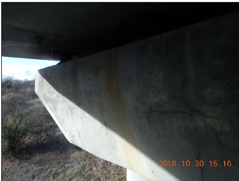
Foto 23: Pohled na úložný práh na členěné podpěře P3; na fotografii patrná síť všesměrných trhlin a stopy po stékání vody včetně známek koroze
