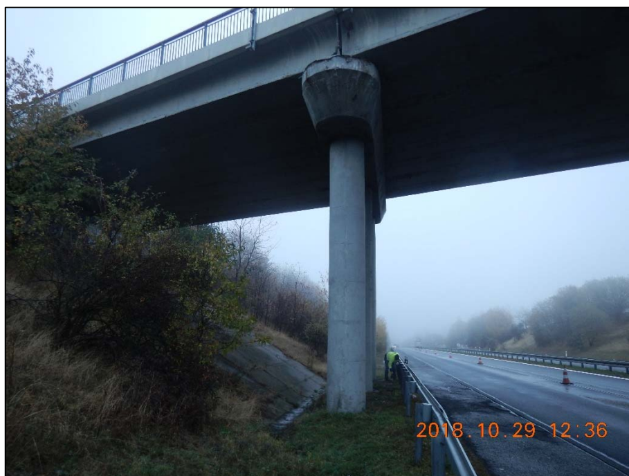
Foto 15: Pohled na členěnou podpěru P3; patrné stopy po zatékání v okolí flexibilního dilatačního závěru; detail viz foto 16; pohled od Karlových Varů směr Praha
