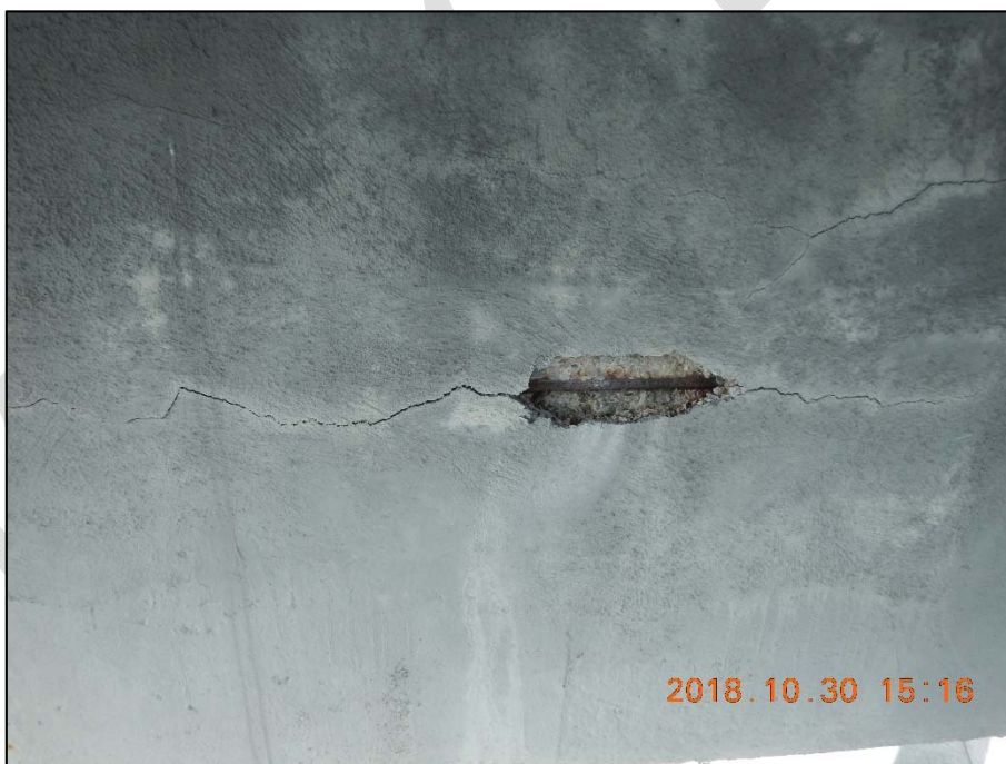
Foto 24: Pohled na chybějící krycí vrstvu betonu úložného prahu na členěné podpěře P3 včetně patrné silné koroze výztuže (detail viz foto 25)
