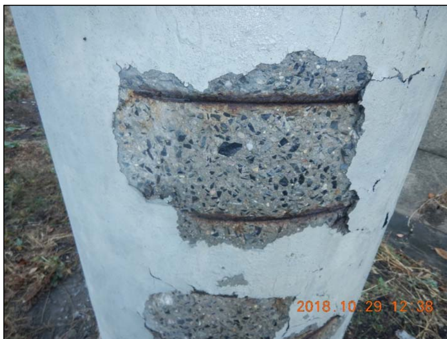
Foto 49: Detail chybějící krycí vrstvy betonu a silně až hloubkově korodující výztuže středního sloupu členěné podpěry P3
