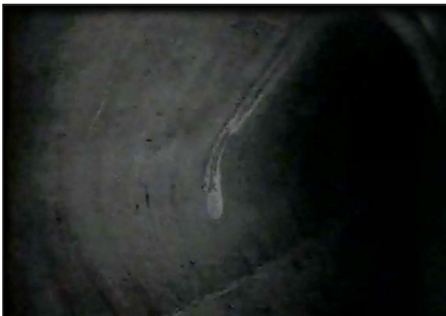
Foto 9: Pohled na stojinu nosníku; na fotografii patrná koroze měkké výztuže nosníku s chybějící krycí vrstvou výztuže
