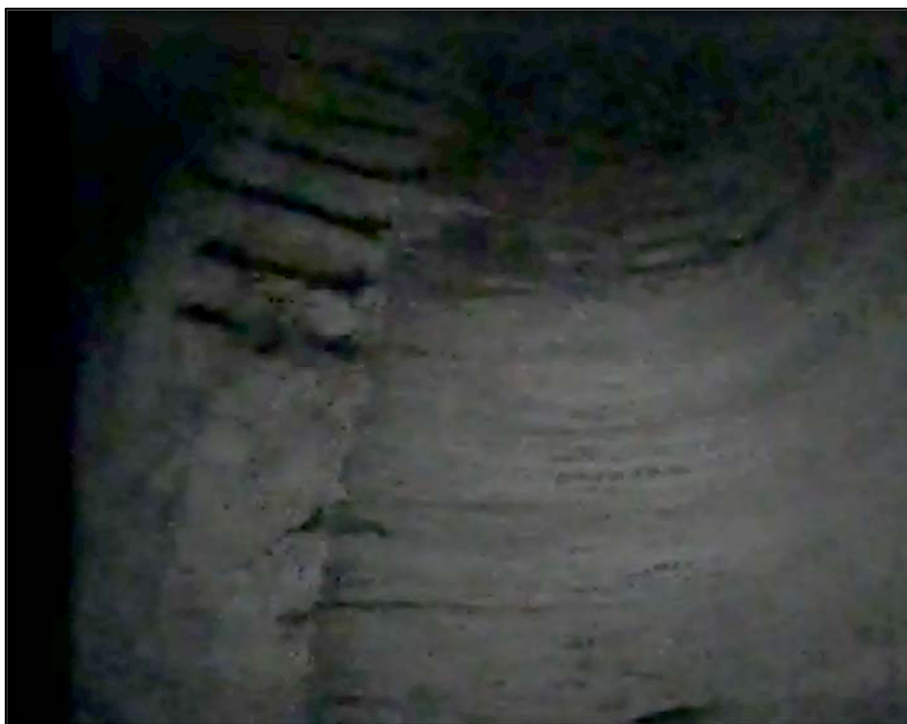
Foto 5: Pohled na dobetonávku u horního líce nosníků uprostřed rozpětí středního pole; na fotografii patrná koroze měkké výztuže dobetonávky
