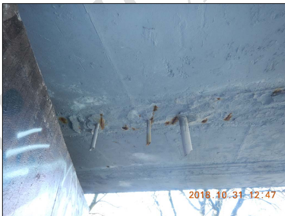
Foto 12: Detail koroze měkké výztuže v místě odvodňovačů u opěry O4; patrná koroze měkké výztuže a degradace krycí vrstvy betonu
