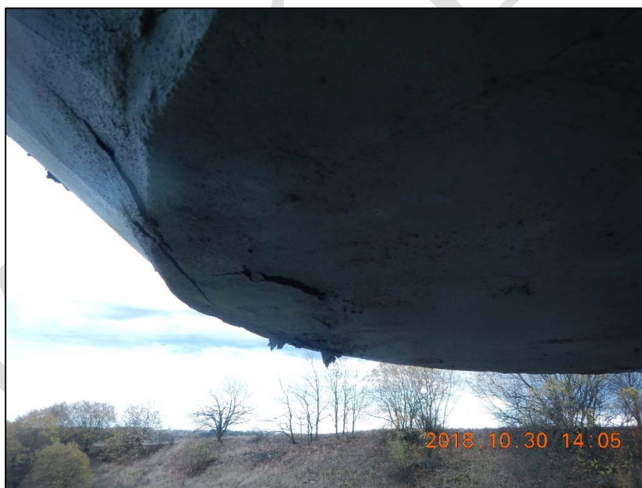
Foto 22: Detail spodního líce úložného prahu na členěné opěře P3; degradace povrchové vrstvy betonu
