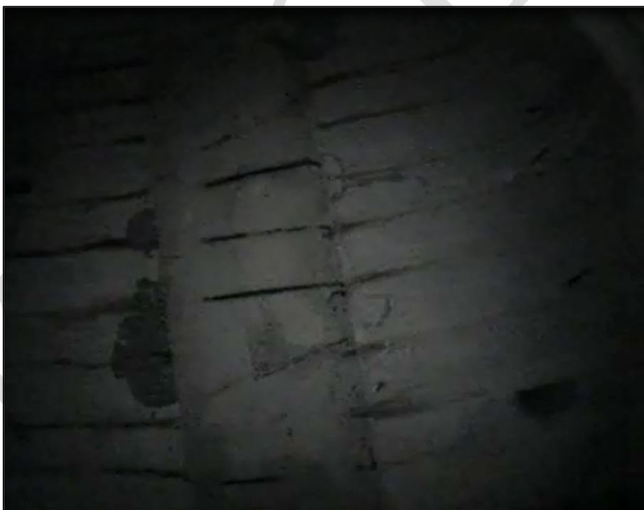
Foto 20: Pohled na dobetonávku a nosníky u horního líce nosníků krajního pole u podpěry P2; na fotografii patrná koroze měkké výztuže dobetonávky a nosníků, patrné stopy po zatékání vody podél dobetonávky; degradace krycí vrstvy výztuže
