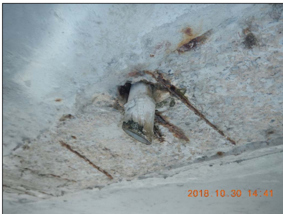
Foto 11: Detail koroze měkké výztuže v místě odvodňovače u úložného prahu členěné podpěry P3 (Foto 10); patrná hloubková až extrémní koroze výztuže s tvorbou korozních zplodin; bez podrobnějšího průzkumu nelze stanovit přesnou míru koroze
