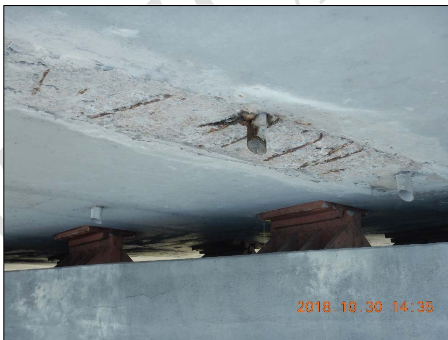
Foto 10: Detail koroze měkké výztuže v místě odvodňovače u úložného prahu členěné podpěry P3; patrná hloubková až extrémní koroze výztuže s tvorbou korozních zplodin; bez podrobnějšího průzkumu nelze stanovit přesnou míru koroze
