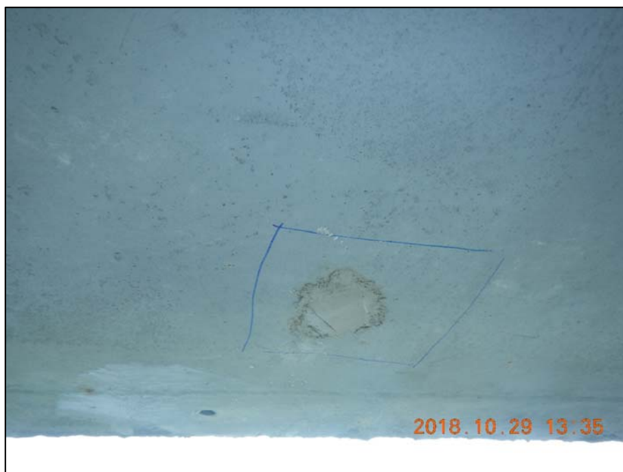
Foto 5: Pohled na zasanovanou sondu 2; sanace provedena hmotou Premix San B R2
