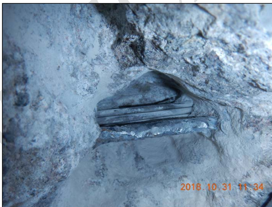
Foto 8: Detailní pohled do sondy 4; sondou odkryto 9 drátů průměru cca 4,5 mm; na viditelných drátech patrná povrchová koroze; sondou obnažena také výztuž kruhového průřezu typu T (10 338)
