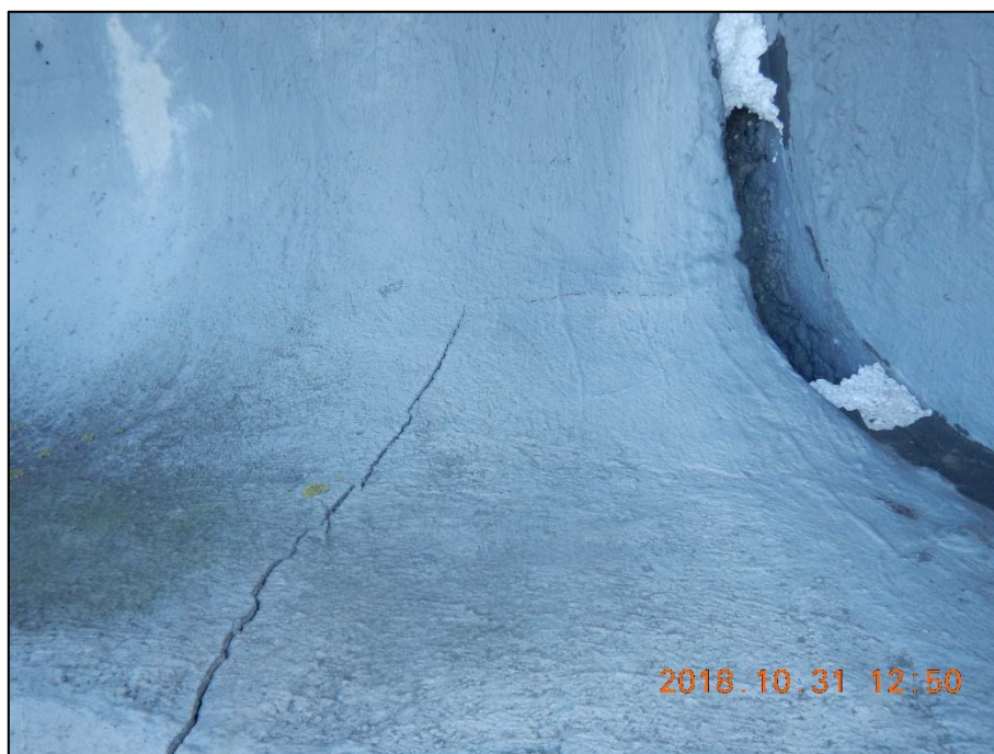
Foto 35: Detail konce krajního nosníku v místě uložení na opěru O1 směrem od Karlových Varů; trhлина probíhající od začátku dolní pásnice do stojiny prvku
