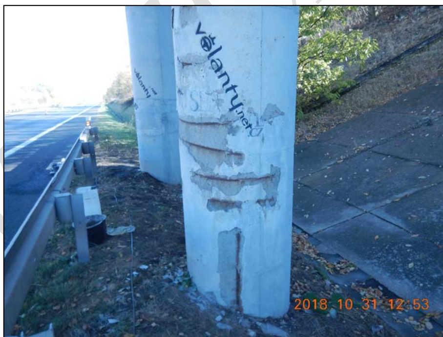
Foto 54: Detail chybějící krycí vrstvy betonu a silně až hloubkově korodující výztuže středního sloupu členěné podpěry P2
