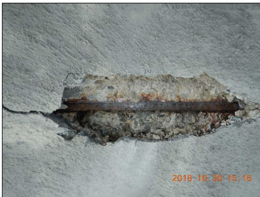
Foto 25: Detail chybějící krycí vrstvy betonu a silně korodující výztuže úložného prahu na členěné podpěře P3
