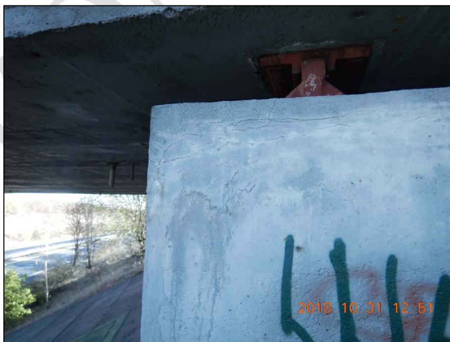
Foto 38: Pohled na hranu opěry O1 v místě uložení nosné konstrukce; patrná síť všesměrných trhlin a degradace povrchových vrstev betonu
