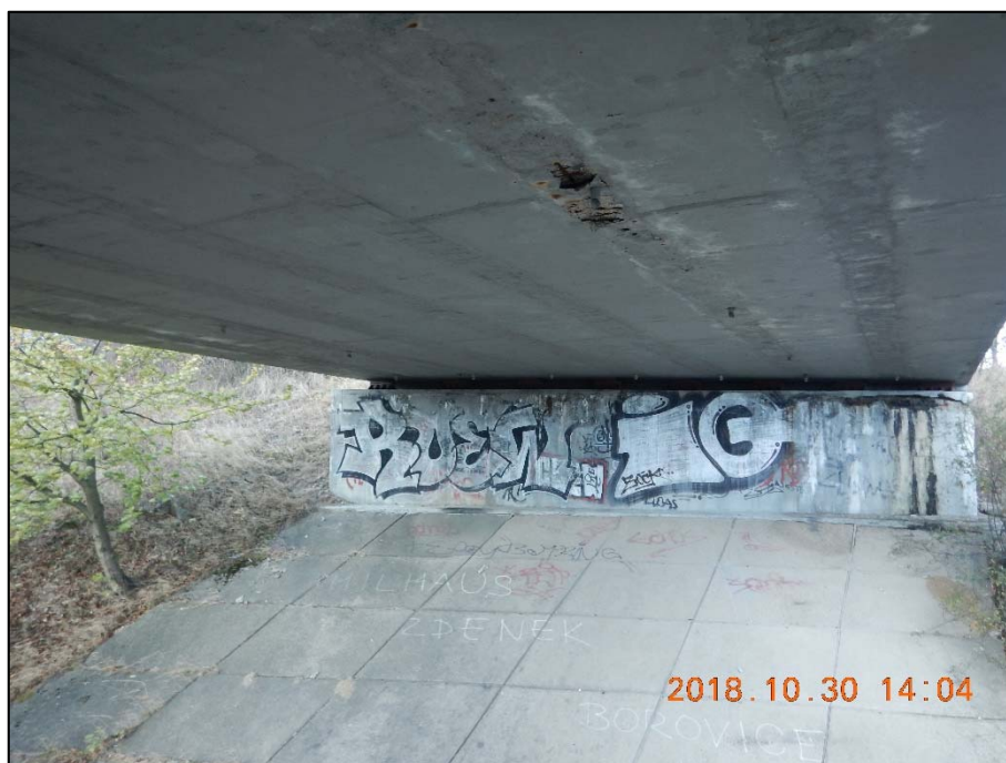
Foto 7: Pohled na spodní líc nosné konstrukce mezi podpěrou P3 a opěrou O4 s patrnou degradací krycí vrstvy betonu a hloubkovou až extrémní korozí měkké výztuže dobetonávky s tvorbou korozních zplodin; bez podrobnějšího průzkumu nelze stanovit přesnou míru koroze
