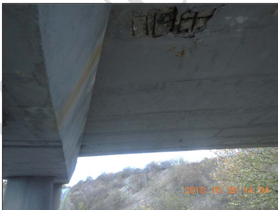
Foto 8: Pohled na spodní líc nosné konstrukce v místě úložného prahu na členěné podpěře P3 s degradací krycí vrstvy betonu dobetonávky
