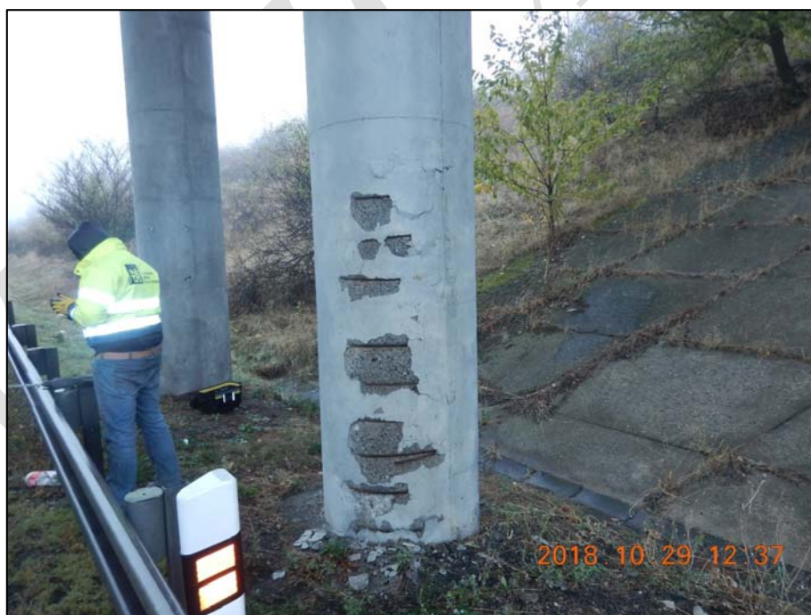
Foto 48: Pohled na střední sloup členěné podpěry P3; na sloupu chybějící krycí vrstvy betonu a koroze třmínek různé intenzity; bez podrobného průzkumu nelze stanovit míru koroze výztuže (detail viz foto 49 a foto 50)
