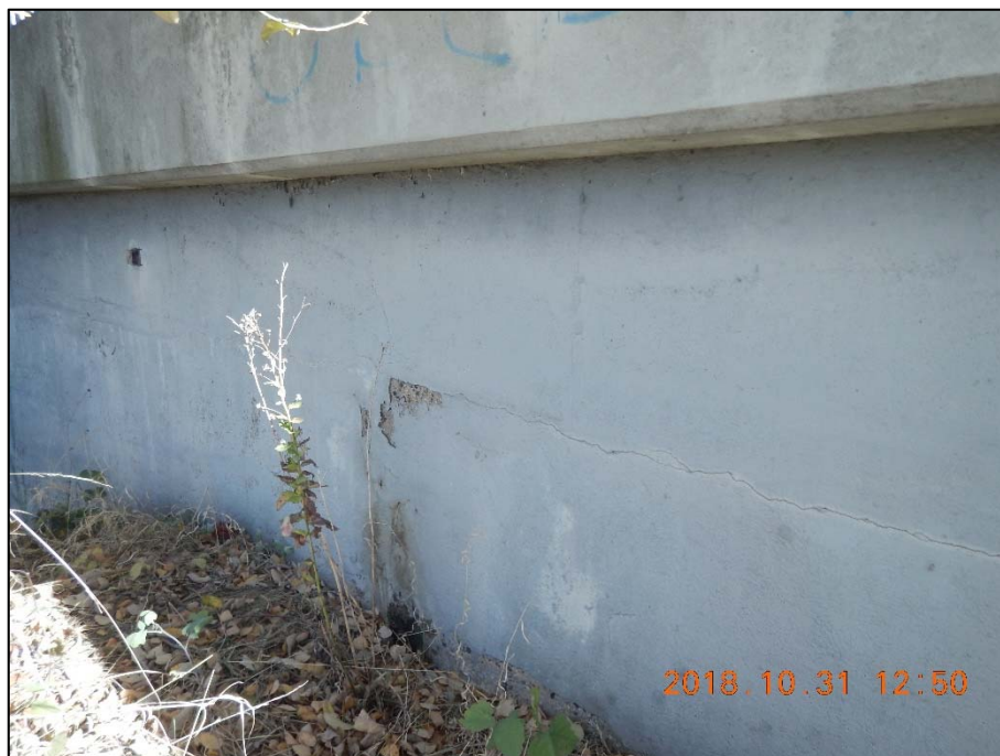
Foto 33: Pohled na křídlo opěry O1 směrem od Karlových Varů s vodorovnou trhlinou v místě pracovní spáry / vodorovné výztuže
