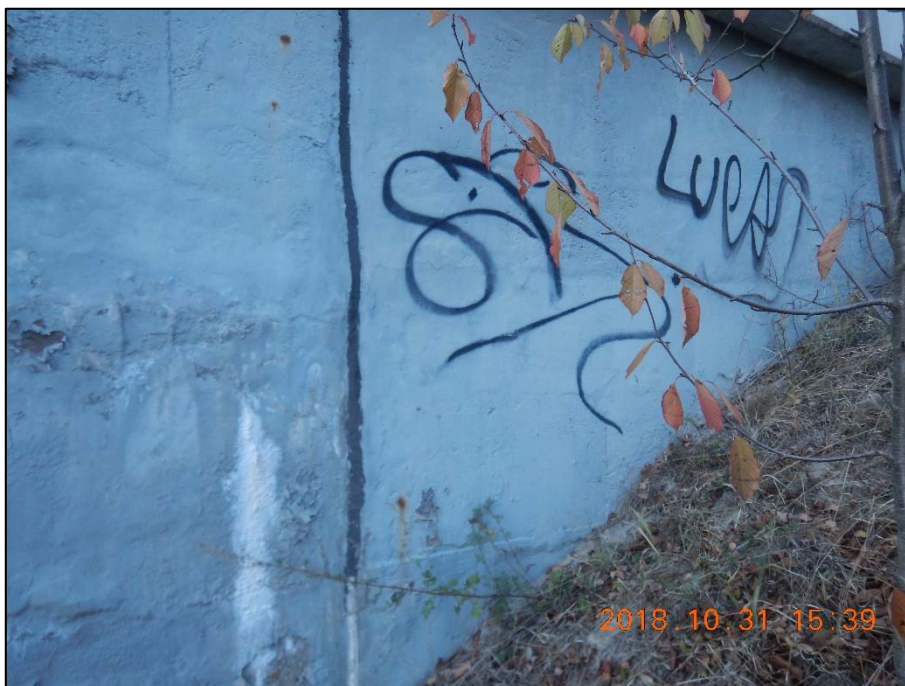
Foto 43: Pohled na křídlo opěry O4 s patrnými výluhy solí a degradací povrchových vrstev betonu
