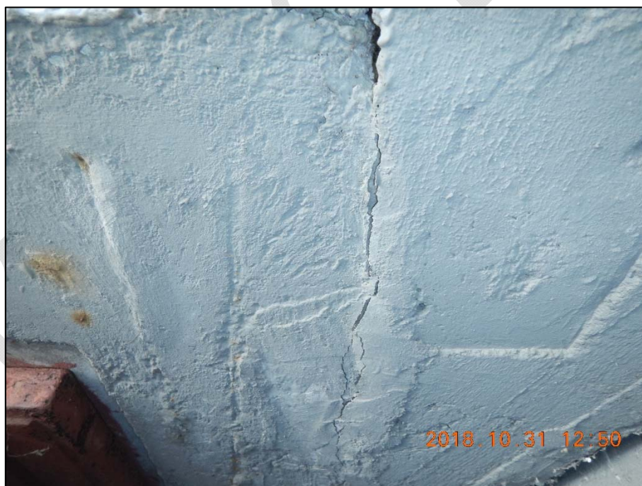
Foto 36: Detail konce krajního nosníku v místě uložení na opěru O1 směrem od Karlových Varů – spodní líc; trhлина probíhající od začátku dolní pásnice do stojiny prvku
