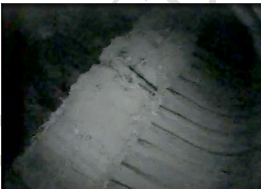
Foto 12: Pohled na dobetonávku u horního líce nosníků středního pole; na fotografii patrná koroze měkké výztuže dobetonávky a nosníků včetně stop po zatékání
