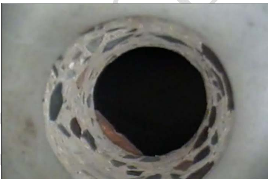
Foto 10: Pohled do odvodňovače v místě vložené průchodky do dobetonávky
