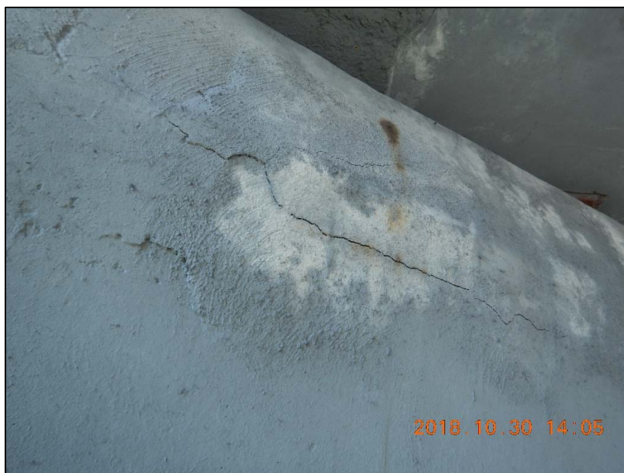
Foto 21: Detail trhliny v úložném prahu na podpěře P3
