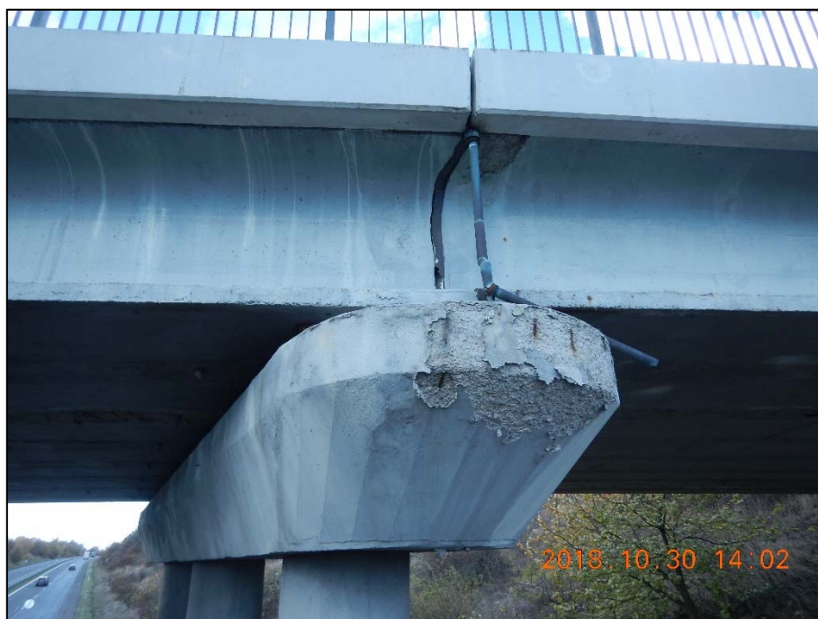
Foto 19: Detail úložného prahu členěné podpěry P3; patrná degradace betonu úložného prahu včetně tvorby výkvětů solí a korodující výztuže; pohled od Prahy směr Karlovy Vary
