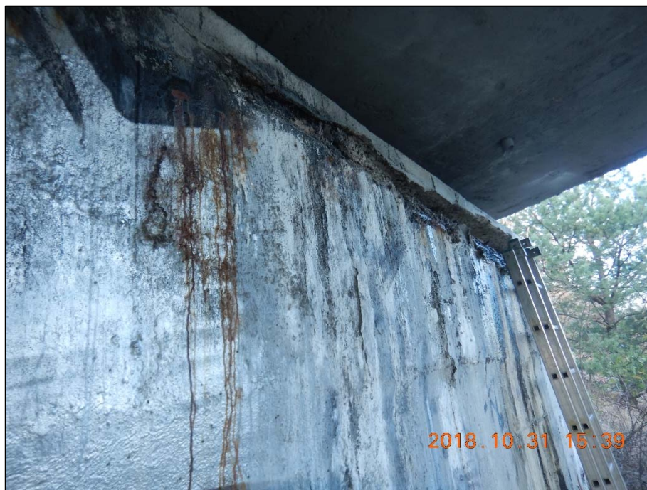
Foto 41: Pohled na opěru O4; vysoká degradace povrchových vrstev betonu a hloubkové až extrémní koroze výztuže
