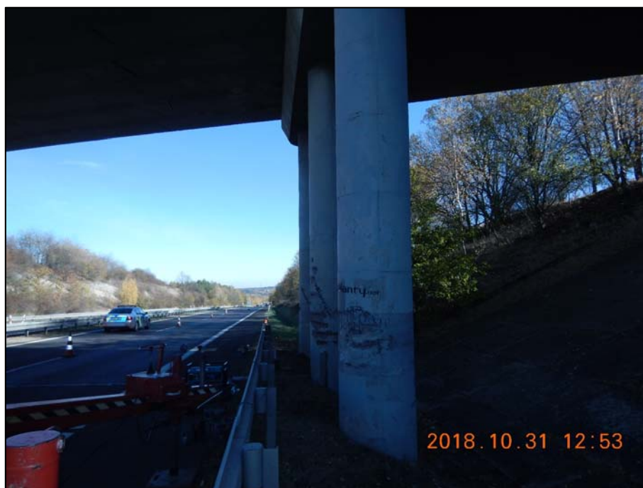
Foto 53: Pohled na členěnou podpěru P2; na středním sloupu chybějící krycí vrstvy betonu a koroze třmínků různé intenzity; bez podrobného průřezu nelze stanovit míru koroze výztuže (detail viz foto 54 a foto 55)
