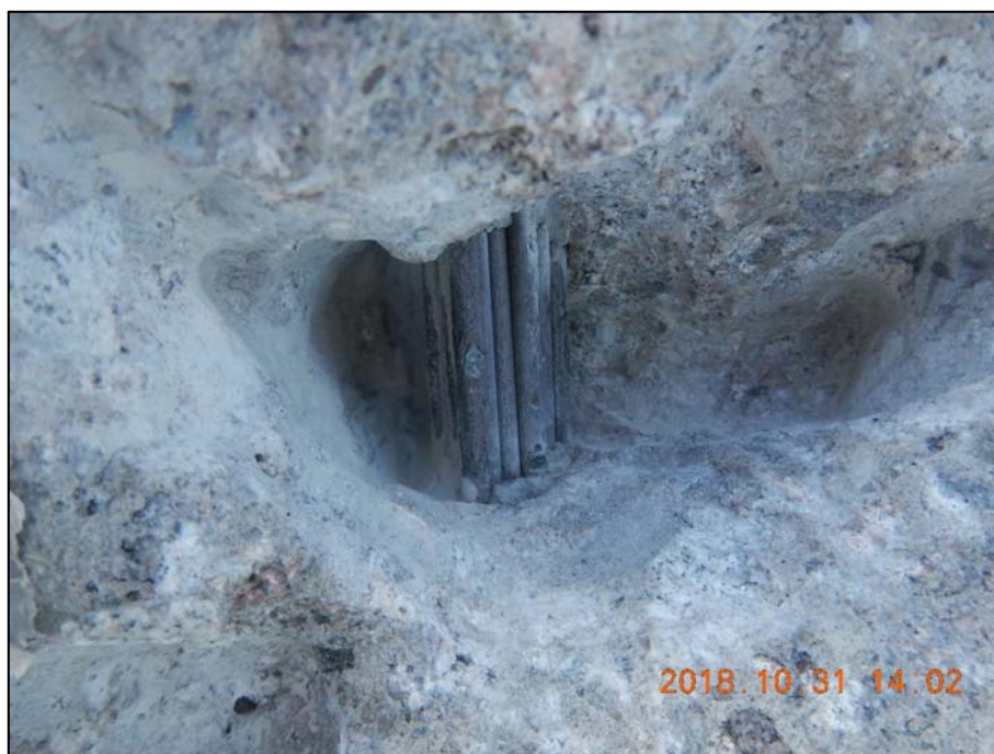
Foto 11: Detailní pohled do sondy 5; sondou odkryto 8 drátů průměru cca 4,7 mm; viditelné dráty buďto bez známek koroze nebo s povrchovou korozí
