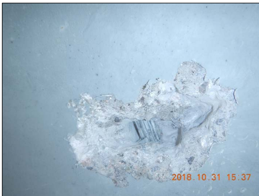
Foto 13: Detailní pohled do sondy 6; sondou odkryto 7 drátů průměru cca 4,5 mm; viditelné dráty buďto bez známek koroze nebo s povrchovou korozí
