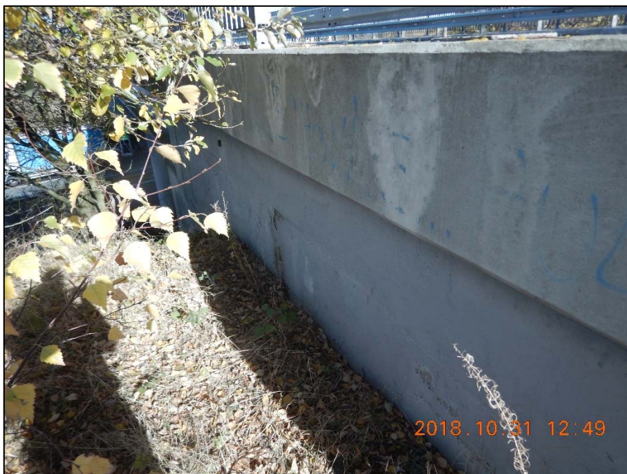
Foto 31: Pohled na křídlo opěry O1 směrem od Karlových Varů, pod římsou odlupování se krycí vrstvy betonu (detail viz foto 32)
