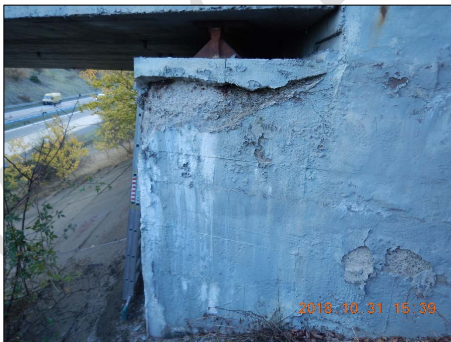
Foto 42: Pohled na opěru O4 směrem od Prahy; vysoká degradace povrchových vrstev betonu a hloubkové až extrémní koroze výztuže; patrné odlupování povrchových vrstev betonu
