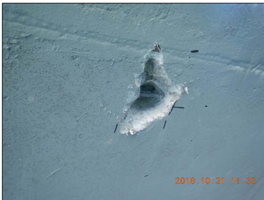
Foto 7: Pohled na sondu 4, která byla provedena mezi opěrou O1 a podpěrou P2 v krajním nosníku směrem od Karlových Varů; osa předpínacího lana cca 280 mm od kraje nosníku, krytí lana cca 68 mm na hranu
