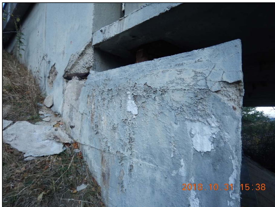
Foto 39: Pohled na opěru O4 ze směru od Karlových Varů s výraznou povrchovou degradací betonu
