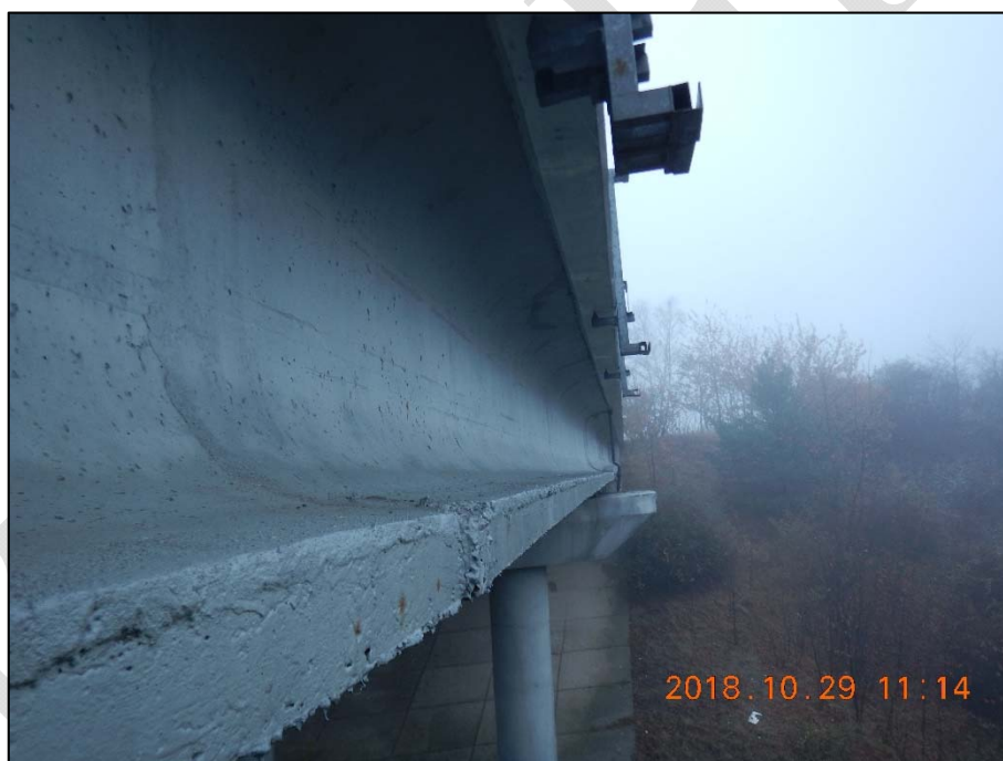
Foto 2: Pohled na boční líc nosné konstrukce opatřenou ochranným nátěrem / stěrkou a úložný práh členěné opěry P2
