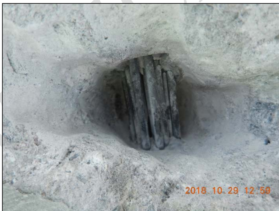
Foto 4: Detailní pohled do sondy 2, sondou odkryto 9 drátů průměru 4,52 mm; viditelné dráty bez známek koroze
