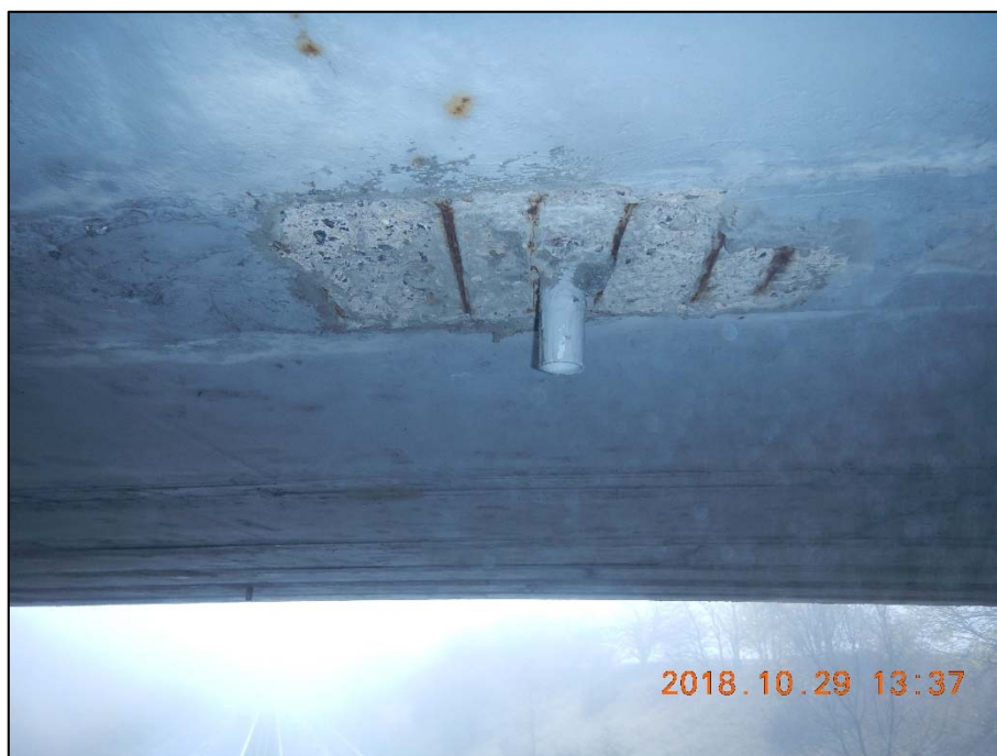
Foto 5: Detail korozní měkké výztuže v místě odvodňovače mezi podpěrami P2 a P3
