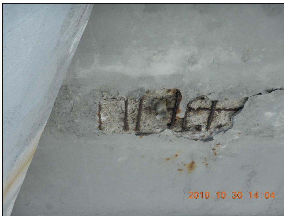
Foto 9: Detail koroze měkké výztuže v místě odvodňovače (viz Foto 8) u úložného prahu členěné podpěry P3; patrná hloubková až extrémní koroze výztuže s tvorbou korozních zplodin; bez podrobnějšího průzkumu nelze stanovit přesnou míru koroze
