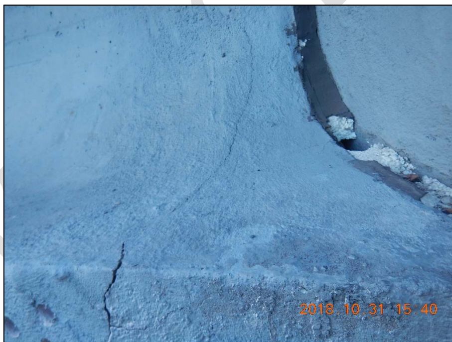
Foto 46: Detail konce krajního nosníku v místě uložení na opěru O4 směrem od Prahy; trhлина probíhající od začátku dolní pásnice do stojiny prvku
