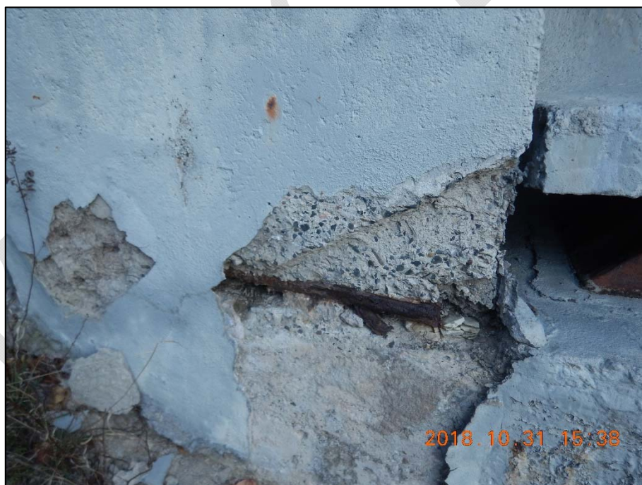
Foto 40: Detailní pohled na opěru O4 směrem od Karlových Varů; chybějící krycí vrstva betonu a hloubková až extrémní koroze výztuže s nedostatečným krytím
