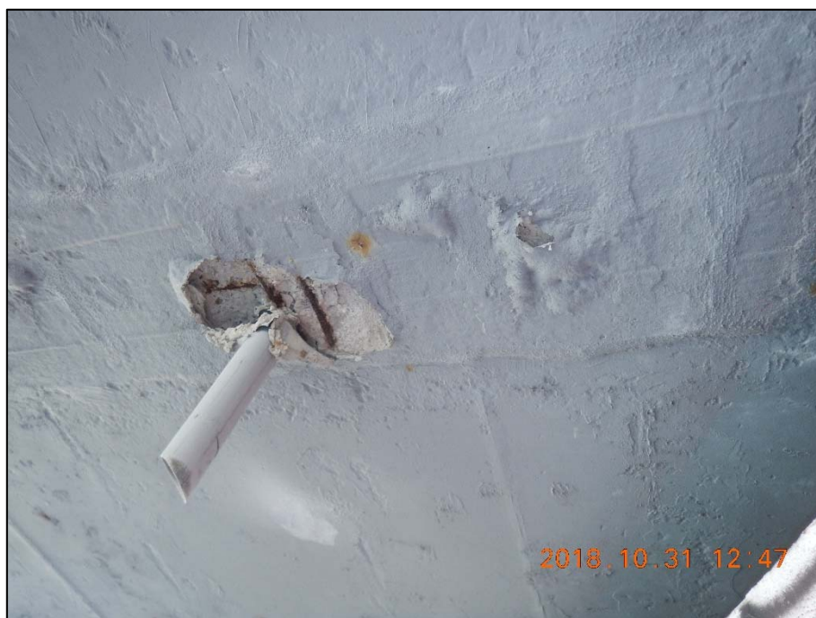
Foto 13: Detail koroze měkké výztuže v místě odvodňovače mezi opěrou O1 a členěnou podpěrou P2; patrná koroze měkké a degradace krycí vrstvy betonu
