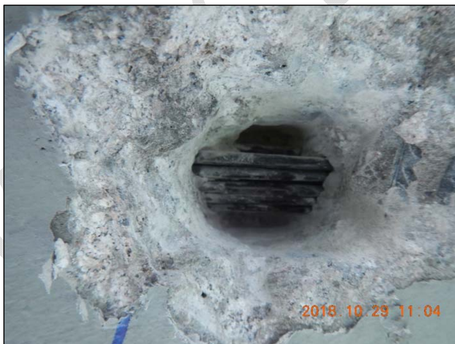
Foto 2: Detailní pohled so sondy 1, sondou odkryto 11 drátů průměru 4,52 mm; viditelné dráty buďto bez známek koroze nebo s povrchovou korozí
