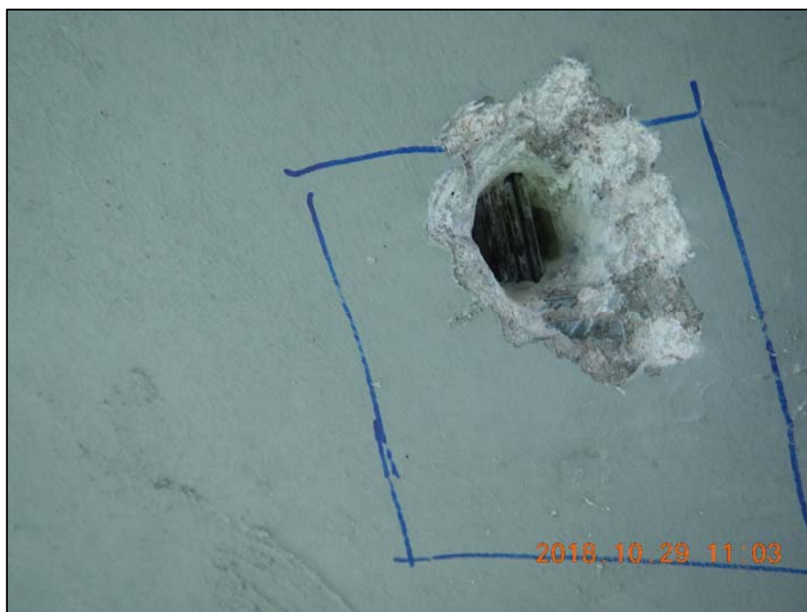
Foto 1: Pohled do sondy 1, která byla provedena v krajním nosníku středního pole směrem od Prahy; osa předpínacího lana cca 190 mm od kraje nosníku, krytí lana cca 41 mm na hranu
