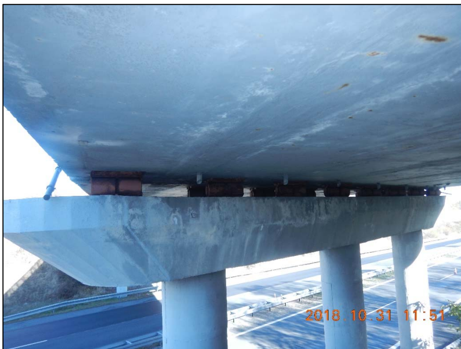
Foto 27: Pohled na úložný práh na členěné podpěře P2
