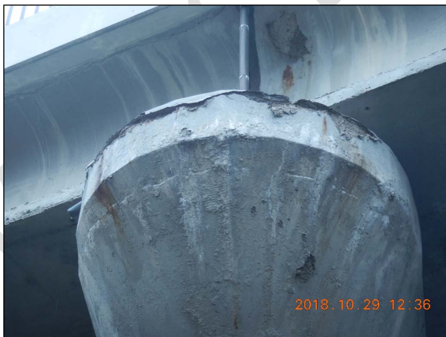
Foto 16: Detail úložného prahu členěné podpěry P3; patrná degradace betonu úložného prahu včetně tvorby výkvětů solí a korodující výztuže; pohled od Karlových Varů směr Praha
