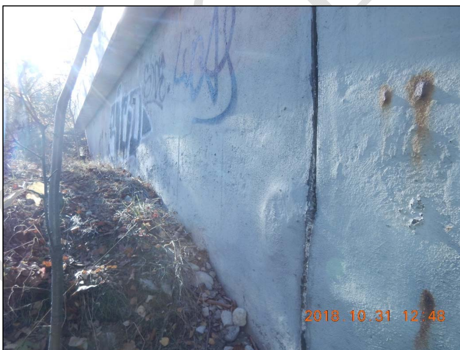
Foto 28: Pohled na křídlo opěry O1 v místě dilatace, na fotografii patrná degradace povrchu a výkvěty způsobené korozi výztuže / kovových prvků
