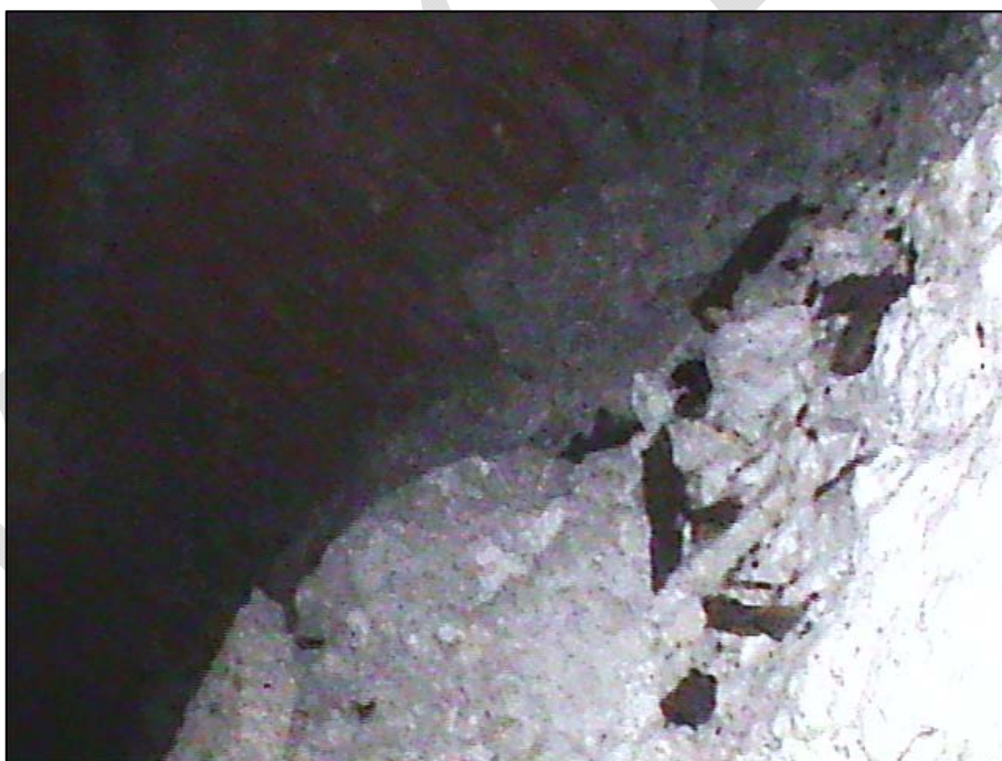
Foto 2: Pohled na konec nosníku u podpěry P3; mezi středním a krajním polem provedena vyzdívka; na dně nosníku úlomky betonu a korozní prvky
