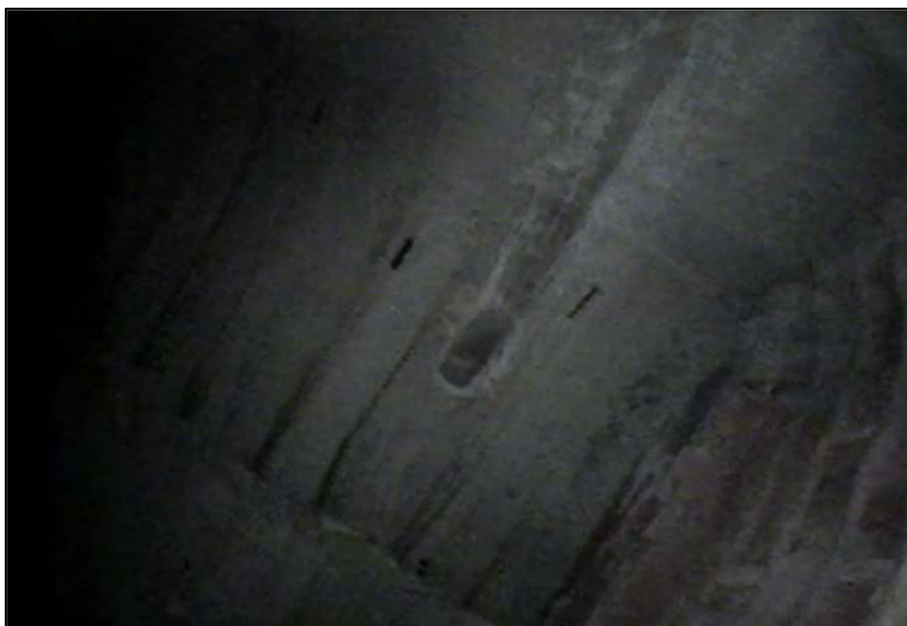
Foto 11: Pohled na konec nosníku středního pole v místě podpěry 2; na snímku patrné stopy po zatékání, koroze měkké výztuže nosníků a výluhů, včetně vyzdívky mezi nosníky
