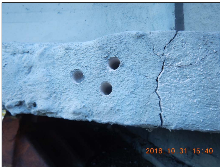
Foto 45: Detail konce krajního nosníku v místě uložení na opěru O4 směrem od Prahy; trhлина probíhající od začátku dolní pásnice do stojiny prvku
