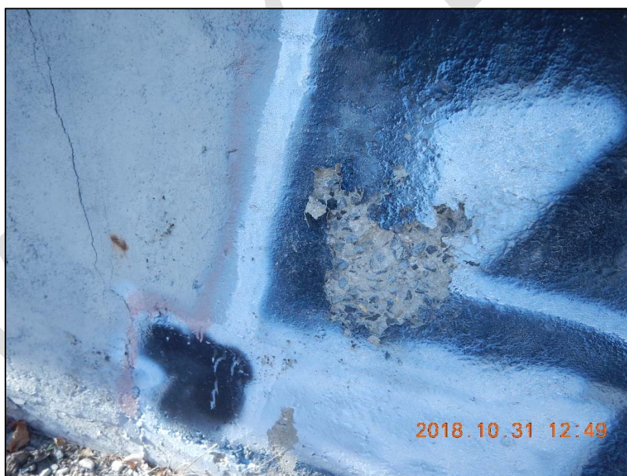
Foto 30: Detail odlupování se krycí vrstvy betonu a svislá trhлина v křídle opěry
