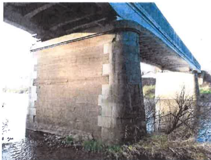
Pohled na P bok mostu s pilířem P3 v popředí.
