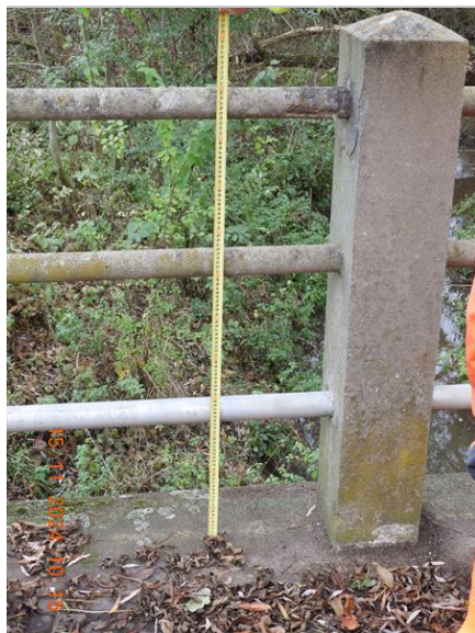
036_Výška zábradlí .jpg
