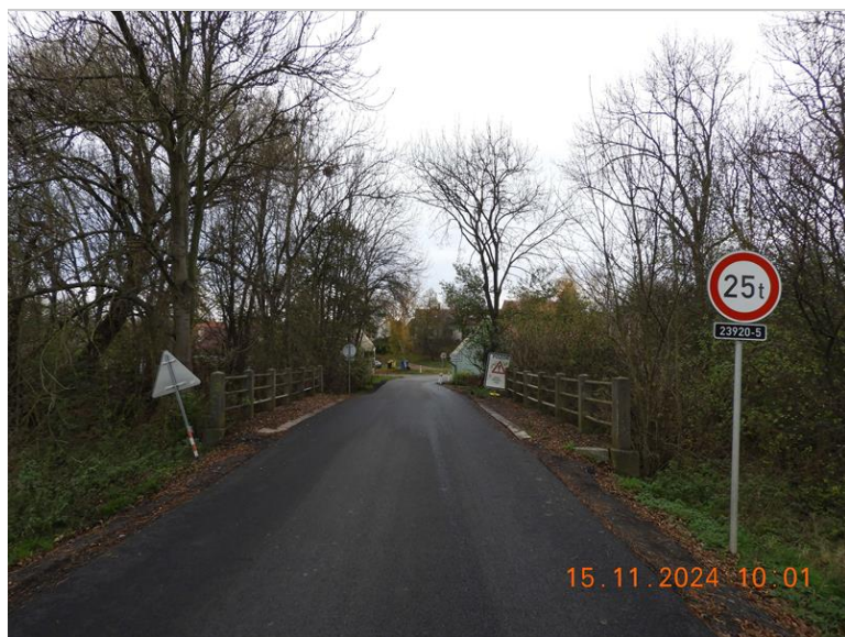
001_Celkový pohled ve směru staničení .jpg
