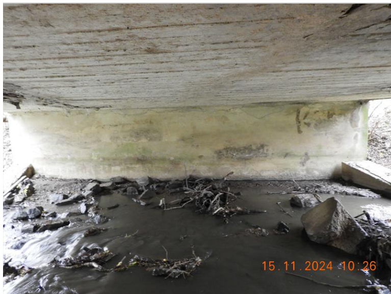
006_Pohled na opěru OP1 .jpg
