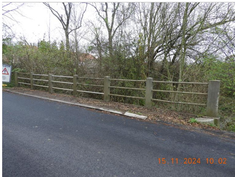
025_Pohled na pravou římsu a zábradlí .jpg
