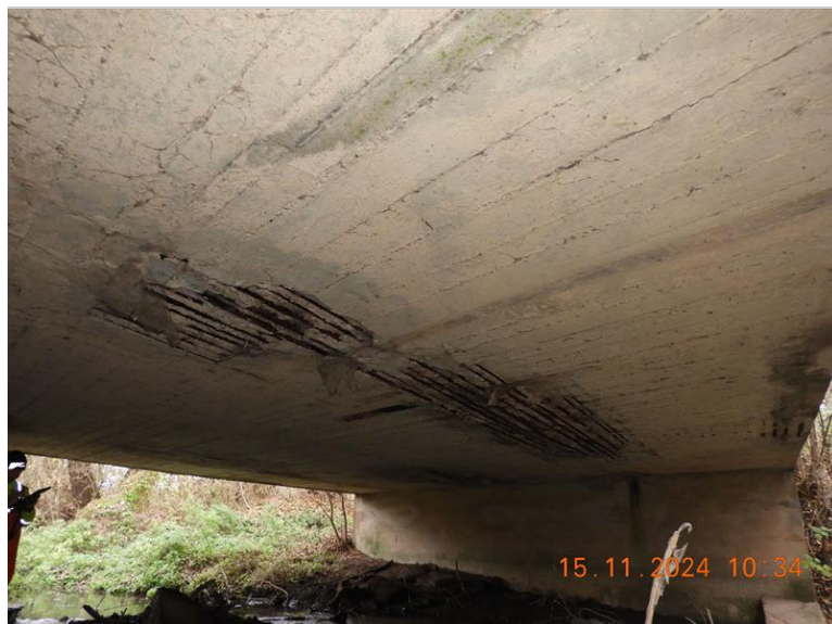
013_Podhled NK ve směru staničení .jpg
