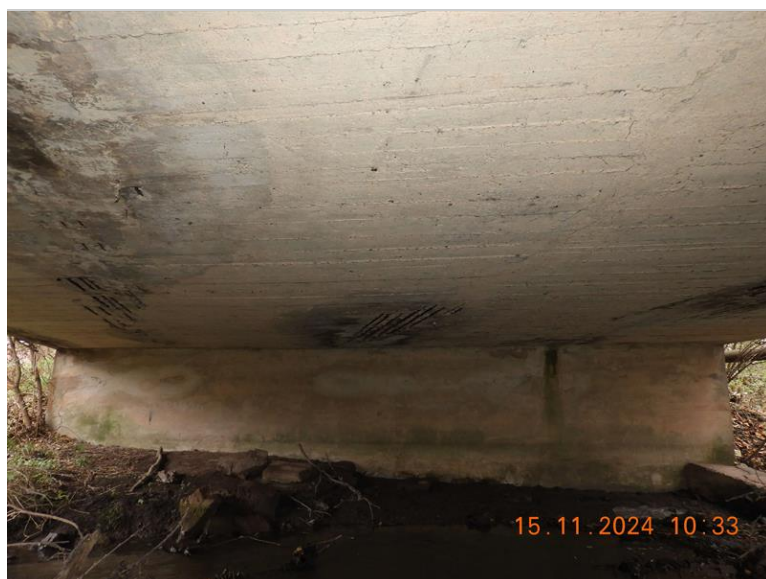
011_Podhled NK proti směru staničení .jpg
