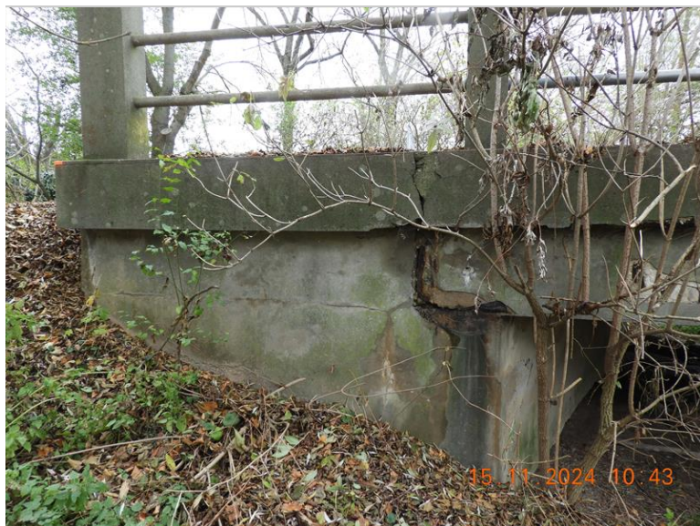
019_Pohled na levé křídlo opěry OP2 .jpg
