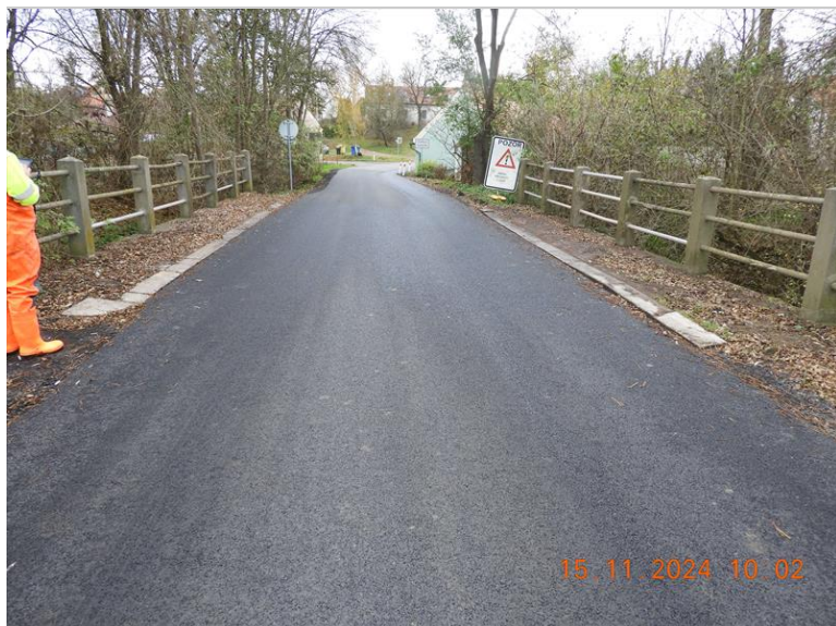
022_Pohled na vozovku ve směru staničení - po opravě.jpg
