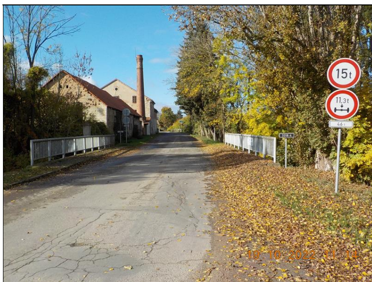
Pohled ve směru staničení.
