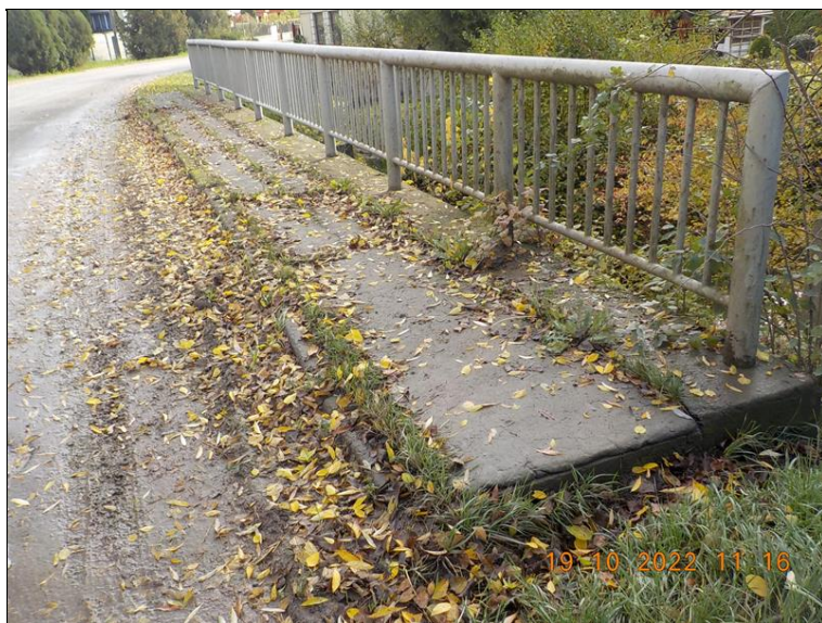
Levá strana mostu.
