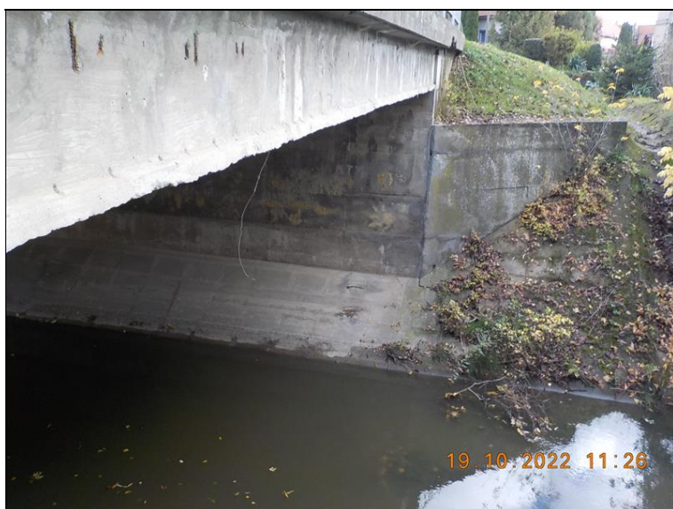
Opěra 1 a křídlo zleva.
