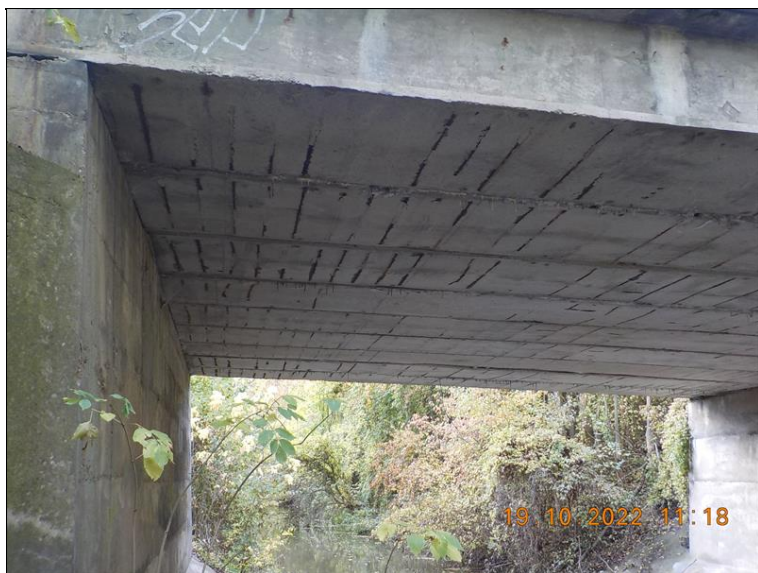
Opěra 1 a podhled NK.
