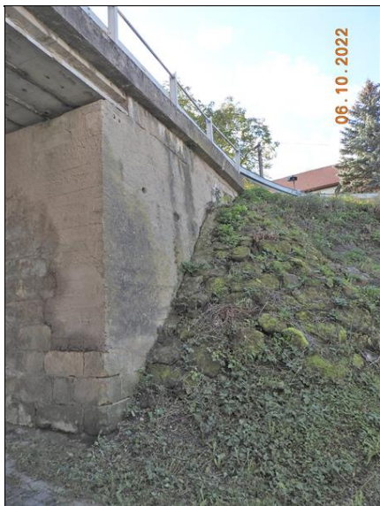
Pravé křídlo OP2.
