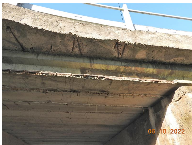
Nosná konstrukce - levý bok.
