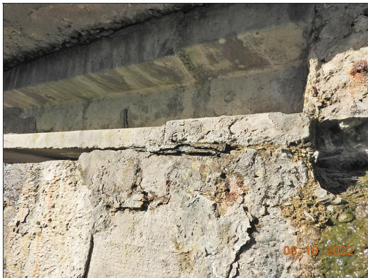
Uložení na OP1.
