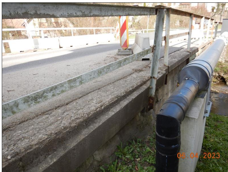
Detail vykloněného zábradlí na levé straně za O2.
