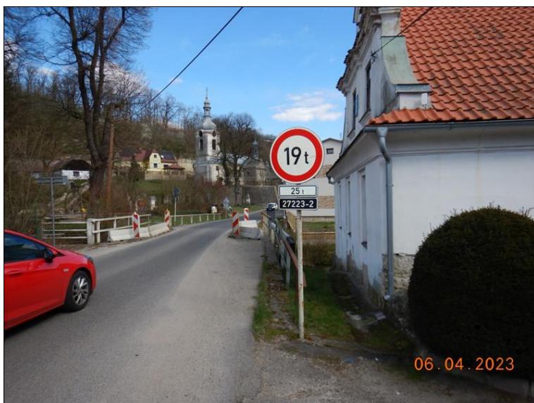
Celkový pohled proti směru staničení.
