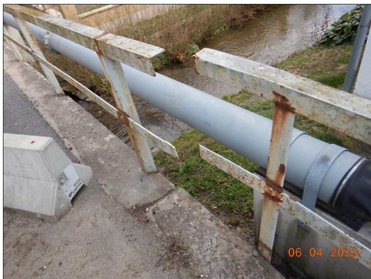
Koroze zábradlí - typický stav.
