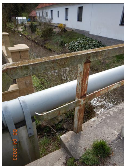
Koroze zábradlí - typický stav.
