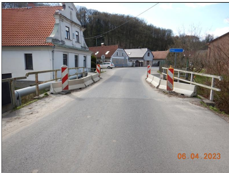
Celkový pohled po směru staničení.
