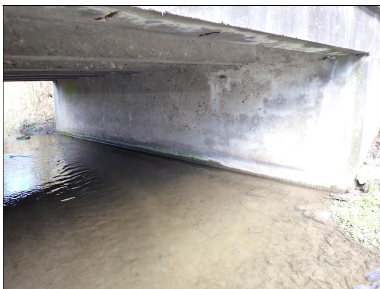
Celkový pohled na opěru O1.
