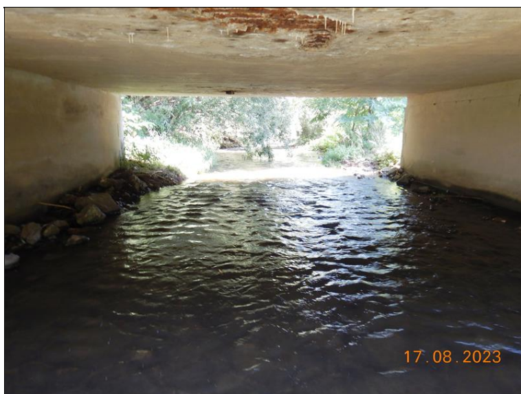
022_Území pod mostem 2. pole. .jpg
