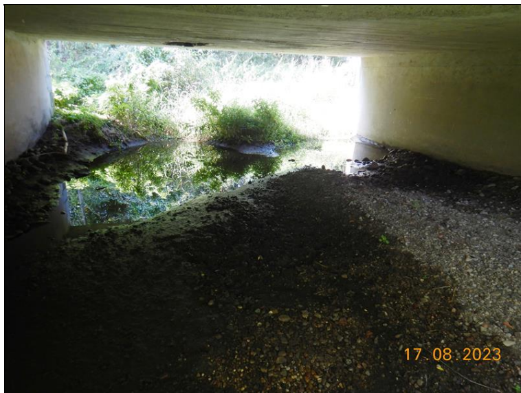
030_Území pod mostem 1. pole. .jpg
