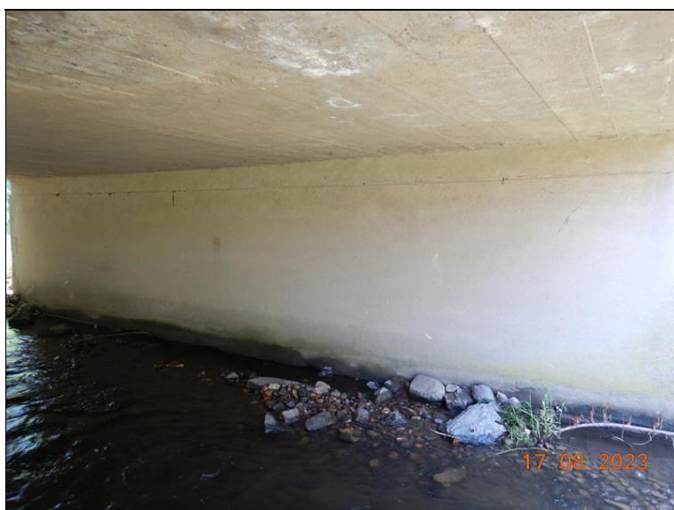
023_Pilíř č. 2 v protisměru. .jpg
