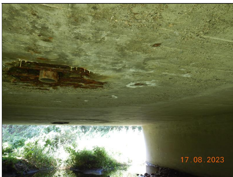
032_Podhled nosné konstrukce 1. pole. .jpg
