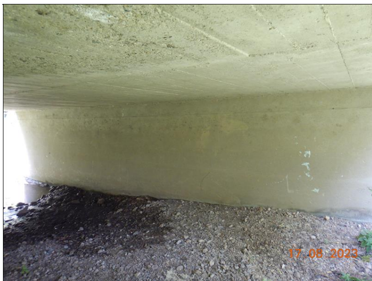
031_Pilíř č. 2 po směru staničení. .jpg
