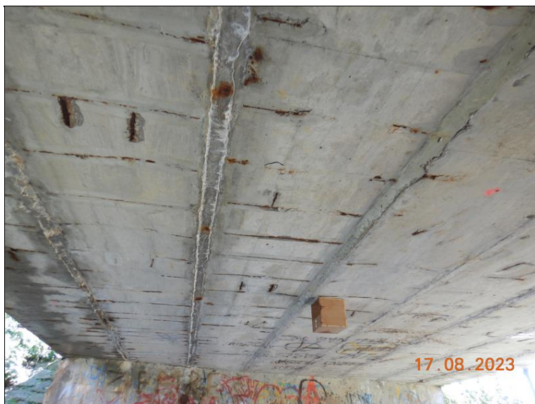
010_Podhled nosné konstrukce. .jpg
