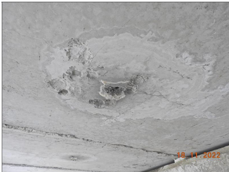
Odvodňovací kanálek nad OP2.
