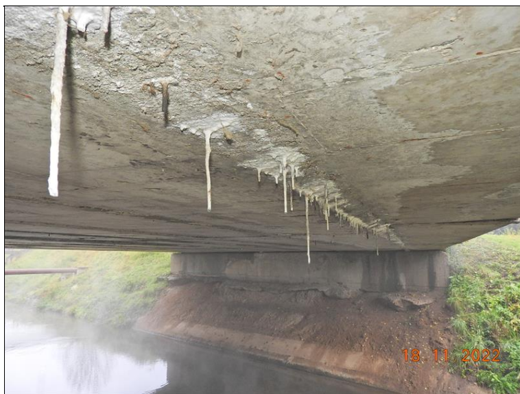
Spára mezi posledními nosníky.
