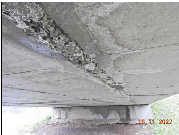
Spára mezi levými nosníky.
