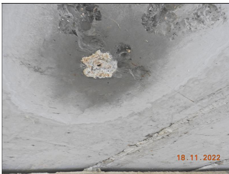
Odvodňovací kanálek nad OP2.
