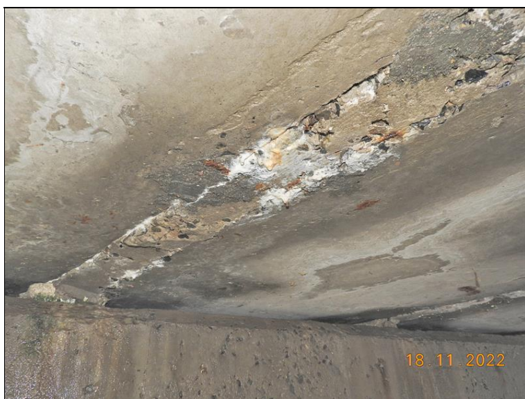
Spára mezi levými nosníky.
