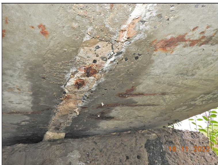
Spára mezi posledními nosníky.
