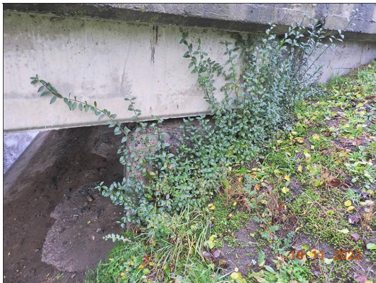
Pravé křídlo OP2.
