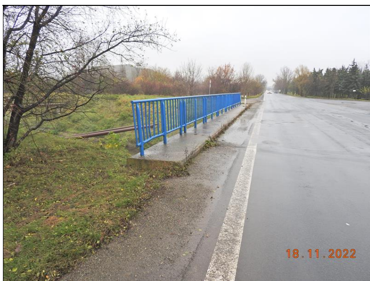
Levá strana mostu.
