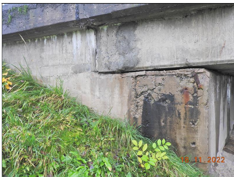
Pravé křídlo OP1.
