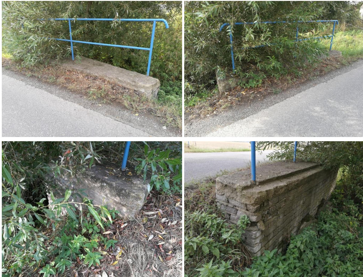
Shora zleva, směr Kyšice – Beroun, pravá strana: 1, 2 – celkové pohledy od silnice, 3 – detail postranní části čela s kotvením zábradlí, 4 – detail zdiva postranní části čela
