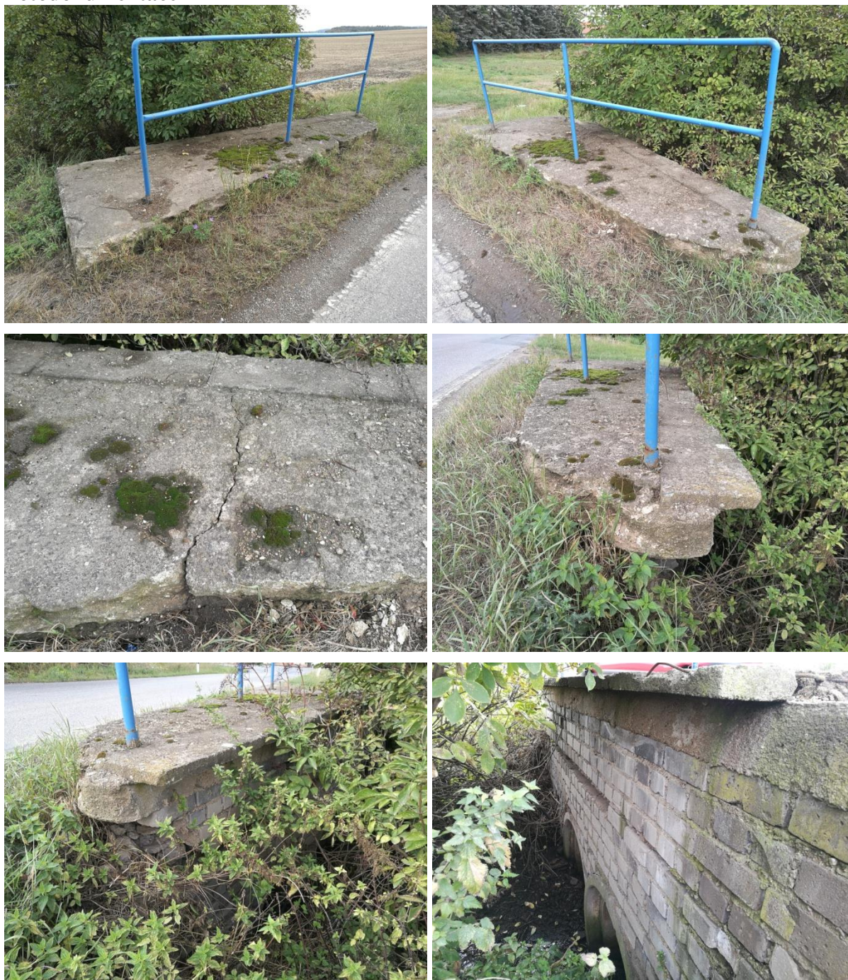
Shora zleva, směr Kyšice – Beroun, levá strana: 1 - 1, 2 – celkové pohledy od silnice, 3 – detail horní desky, 4, 5 – detail postranní části čela s kotvením zábradlí, 6 – detail zdiva a římsy
