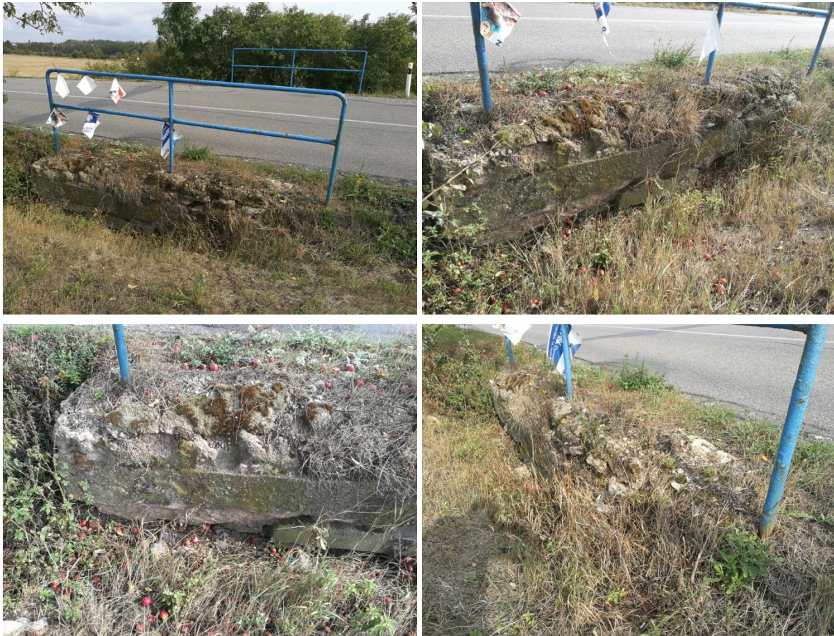
Shora zleva, směr Kyšice – Beroun, pravá strana: 1 – celkový pohled z pole, 2 – detail čela propustku, 3 – detail postranní části s kotvením zábradlí, 4 – detail horní desky s kotvením zábradlí
