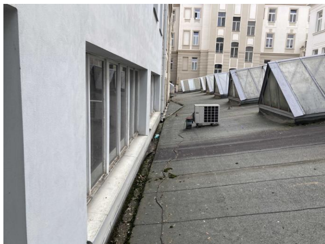
Foto /6/ Pohled na část předmětné střechy
