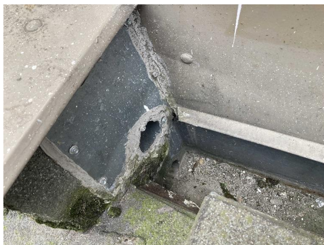
Foto /8/ Odvodnění žlabů chrličem skrze atiku
