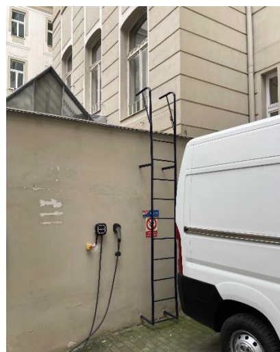
Foto /4/ Přístup na předmětnou střechu
