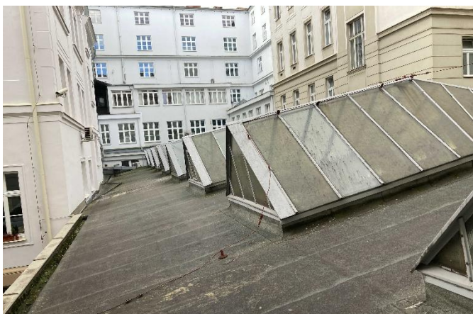
Foto /5/ Pohled na část předmětné střechy
