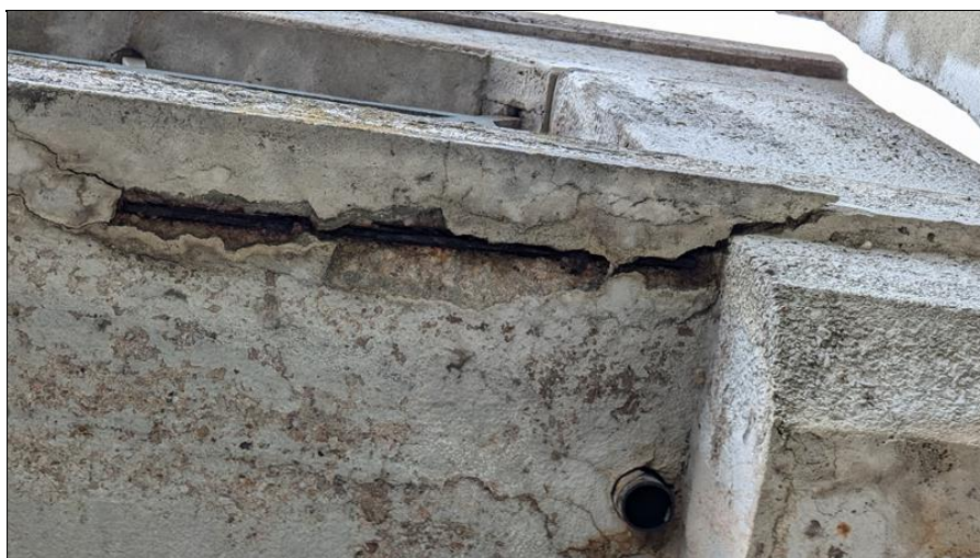
Podhled konzoly NK u OP1 vlevo - v místě pod projevenou poruchou v chodníku - detail.
