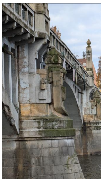
Detail_poruchy NK, provedení vyústění odvodnění a historické prvky na P3 zleva
