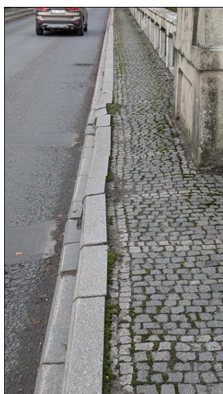
Detail rozvolnění obrub nad dilatační spárou nad OP1
