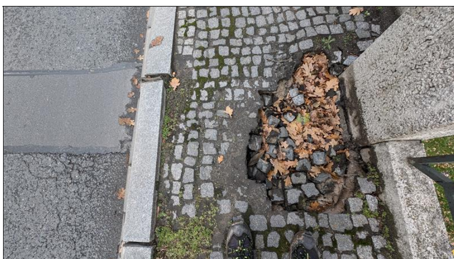
Propadlá dlažba v chodníku nad OP1 vlevo - detail
