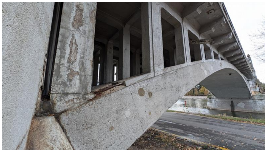
Odrtržená odvodňovací trubičky z povrchu izolace - podhled 1 mostního pole vpravo
