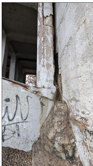
Detail napojení spodního ŽLB oblouku prvního pole NK na OP1 - poruchy krycí vrstvy betonu způsobené korozí výztuže.
