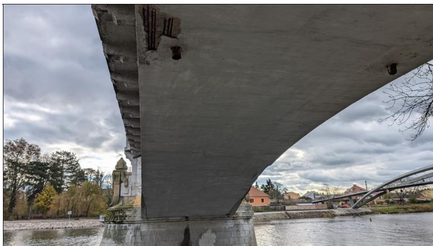
Poruchy výztuže v podhledu ve vrcholu oblouku 1 mostního pole
