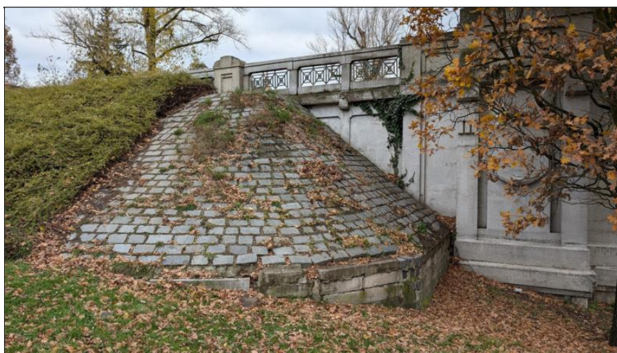
Očištěné dláždění kužele zemního tělesa u OP1 vpravo
