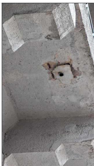
Odrtržená odvodňovací trubičky z povrchu izolace - podhled 1 mostního pole vpravo
