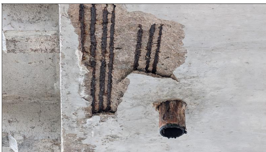
Poruchy na podhledu NK - oblouk 1 mostního pole zprava
