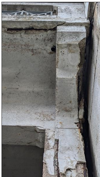
Detail pohledu dilatační spáry mezi 1 polem mostu a OP1 vlevo
