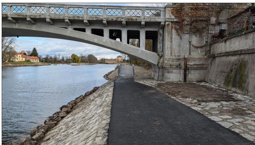
NK v napojení na OP4 zprava - poruchy krycí vrstvy betonu signalizují pokračující korozi výztuže
