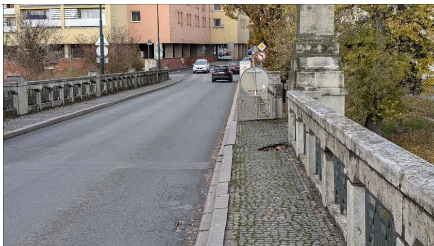
Porucha v kamenném krytu chodníku nad OP1 vlevo
