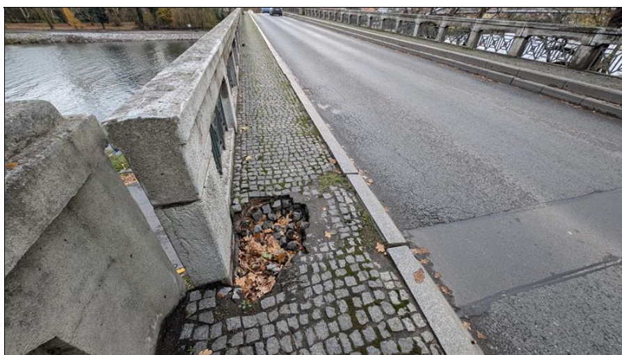
Porucha v dlážděném krytu chodníku nad OP1 vlevo
