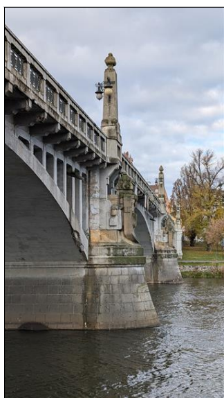
Poruchy NK, provedení vyústění odvodnění a historické prvky na P3 zleva
