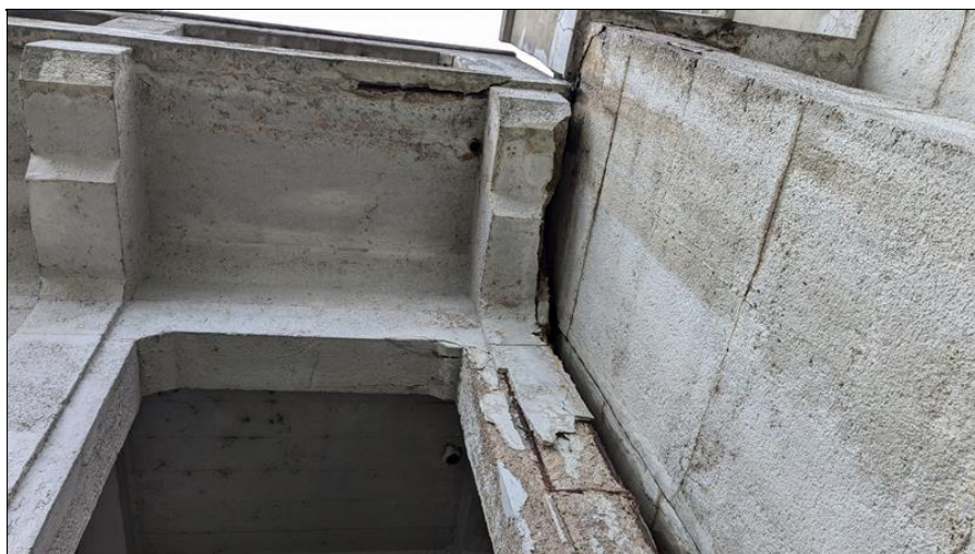
Podhled konzoly NK u OP1 vlevo - v místě pod projevenou poruchou v chodníku.
