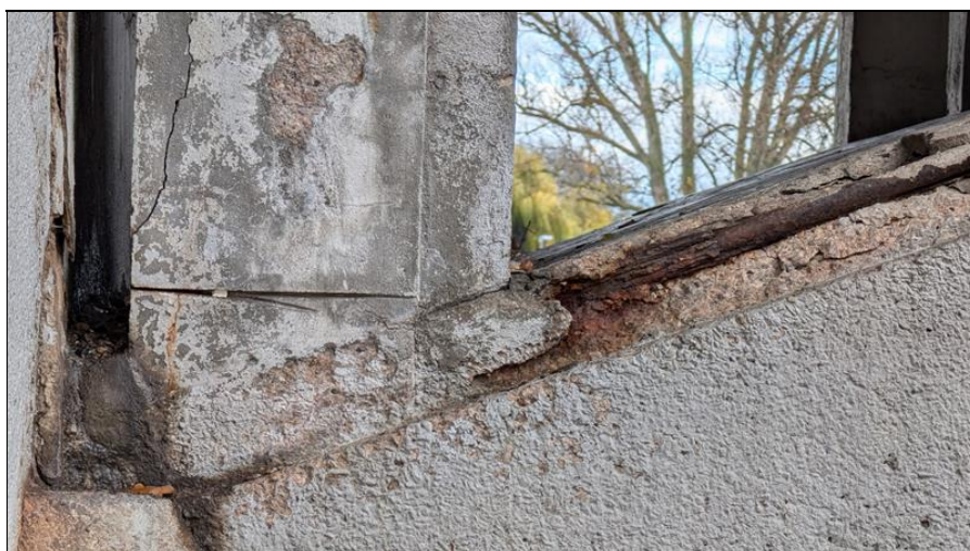
Detail vetknutí oblouku 1 pole NK do OP1 vpravo, poruchy výztuže se značným korozním úbytkem
