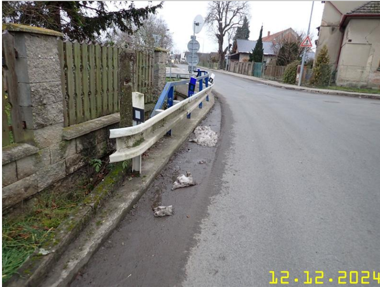
027 - levá římsa krajnice svodidlo.jpg
