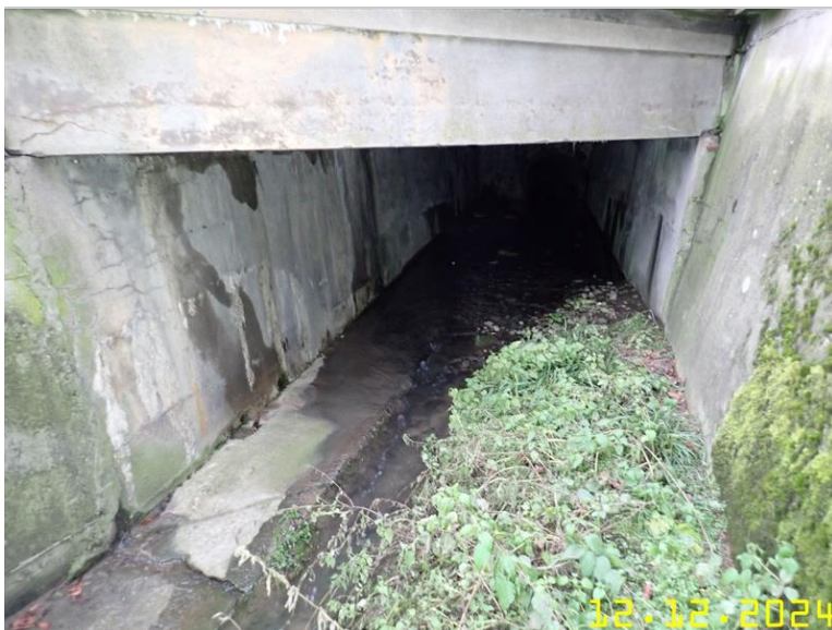
032 - prostor pod mostem na levé straně.jpg
