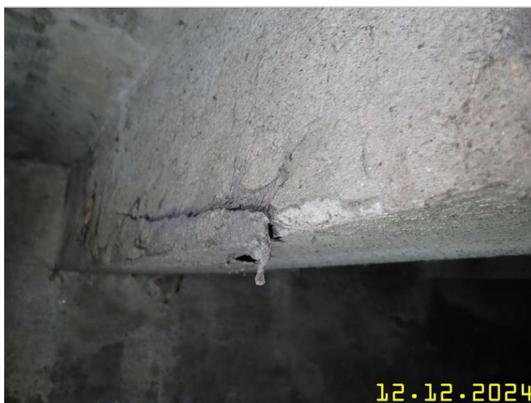
047 detail trémové konstrukce.jpg
