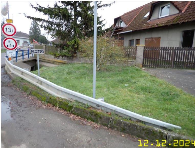
009 - levá římsa v pohledu proti směru staničení.jpg
