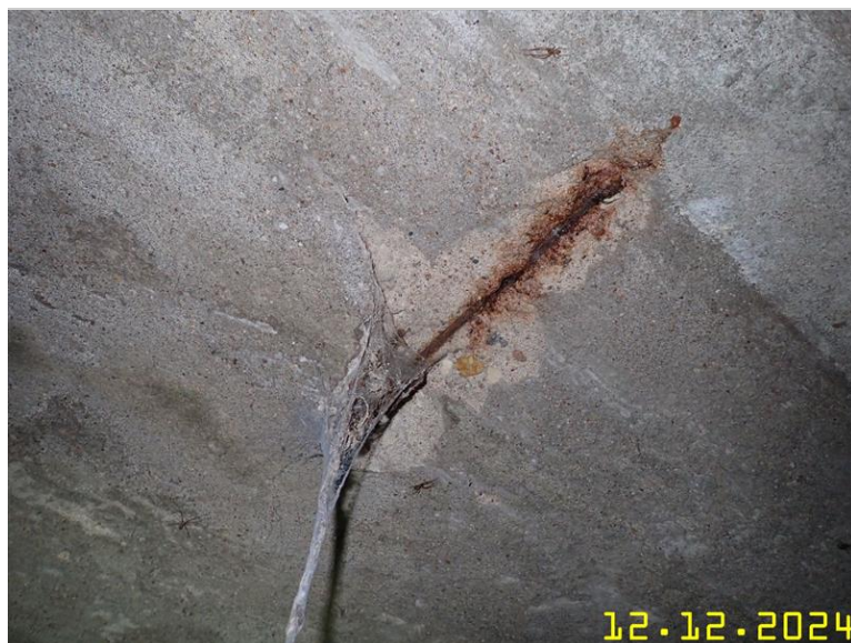
054 detail desky trámové konstrukce.jpg
