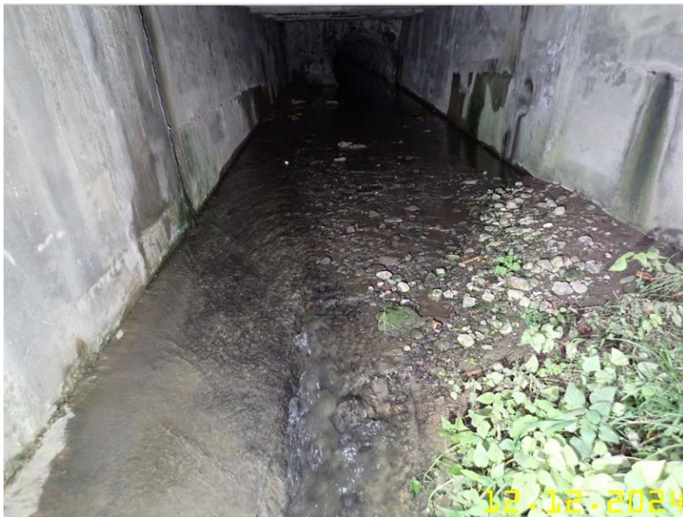
037 - prostor pod mostem.jpg
