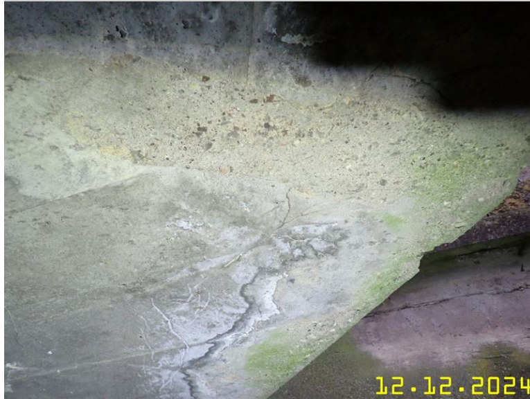
039 pohled NK levá krajní hrana.jpg
