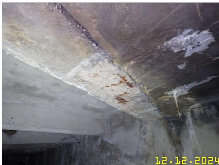
069 pohled rozhraní mezi trémovou a deskovou konstrukcí.jpg
