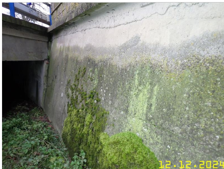
033 - přilehlá opěrná zeď na levé straně opěry O1.jpg
