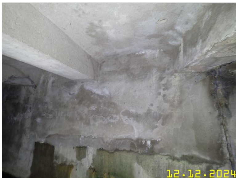
044 O1 a podhled trémové konstrukce.jpg
