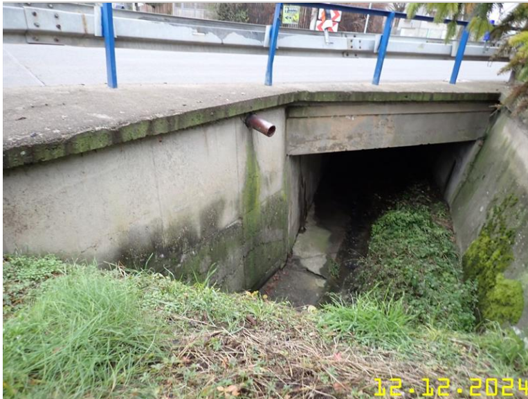
022 - pohled na most z levé straně.jpg
