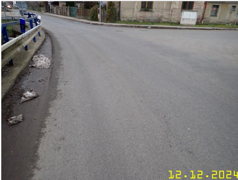
028 vozovka na mostě.jpg
