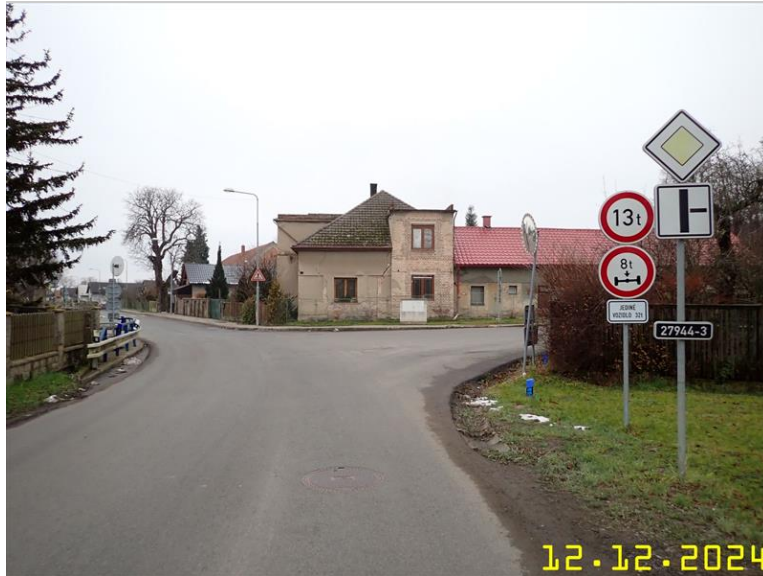
001 - prostorové uspořádání na mostě ve směru staničení.jpg
