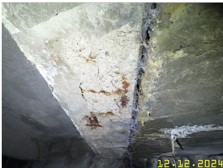
043 spára mezi deskovou a trémovou konstrukcí.jpg
