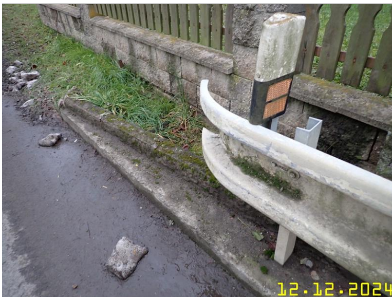
026 - ukončení svodidla na levé straně za opěrou O1.jpg
