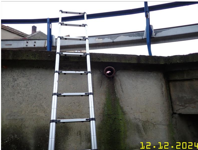
031 - levá strana opěry O2 a římsy.jpg
