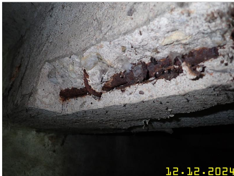
048 detail trémové konstrukce.jpg
