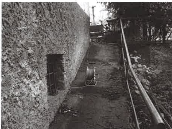
Obr. 6: snímač SN1 na sklepním okně
