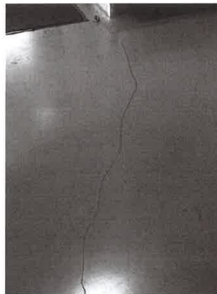
Obr. 12 a 13: Převzaté foto trhlin v podlahách v objektu
