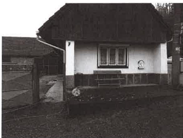
Obr. 8: snímač SN4 v čele objektu
