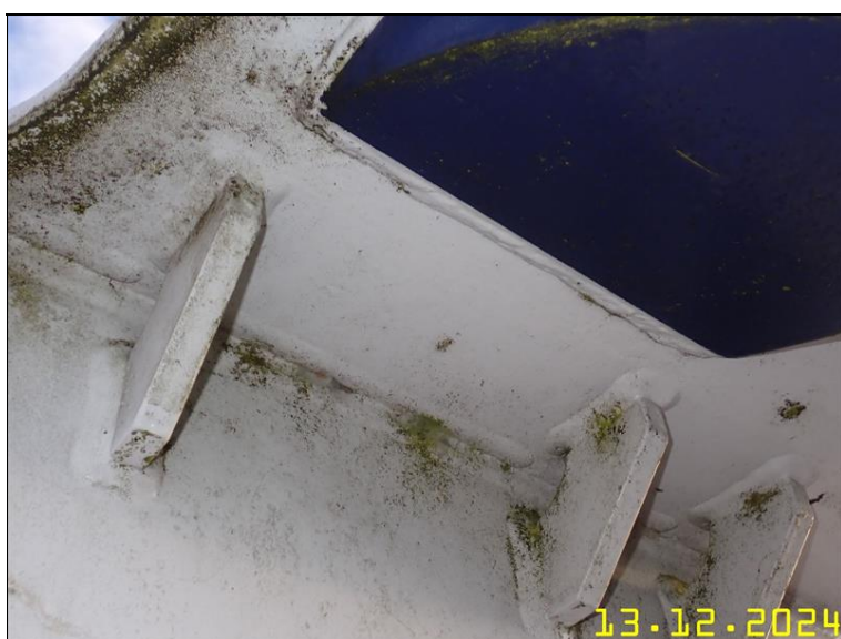
228 PRVKY OCELOVÉ KONSTRUKCE Z PLOŠINY.JPG
