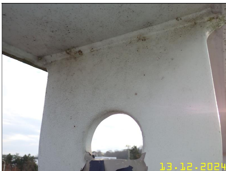
243 PRVKY OCELOVÉ KONSTRUKCE Z PLOŠINY.JPG
