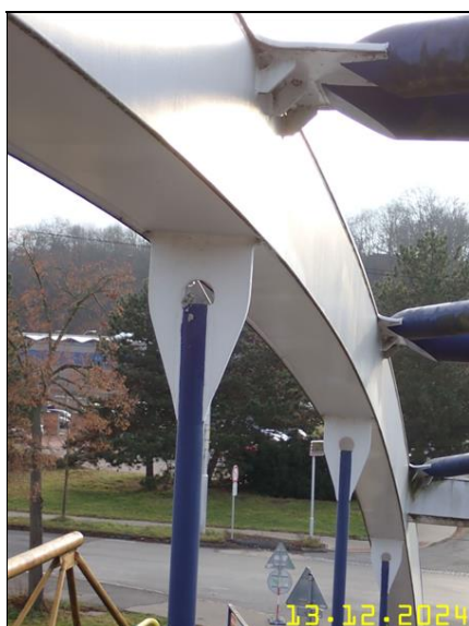
252 PRVKY OCELOVÉ KONSTRUKCE Z PLOŠINY.JPG
