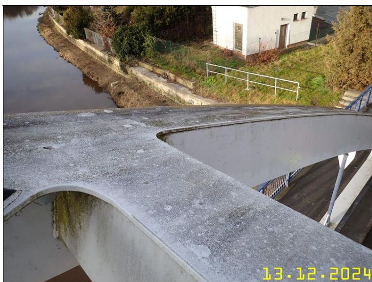
267 PRVKY OCELOVÉ KONSTRUKCE Z PLOŠINY.JPG
