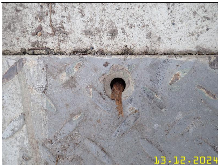
100 MDZ O2 - CHYBĚJÍCÍ SPOJOVACÍ MATERIÁL.JPG
