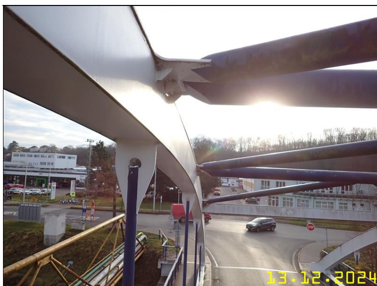
261 PRVKY OCELOVÉ KONSTRUKCE Z PLOŠINY.JPG
