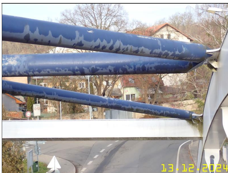
255 PRVKY OCELOVÉ KONSTRUKCE Z PLOŠINY.JPG
