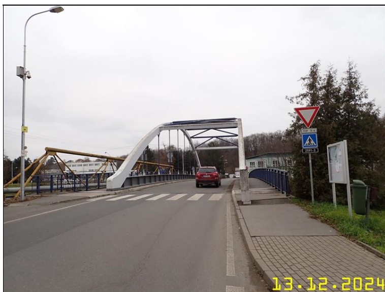
001 PROSTOROVÉ USPOŘÁDÁNÍ V POHLEDU VE SMĚRU STANIČENÍ.JPG
