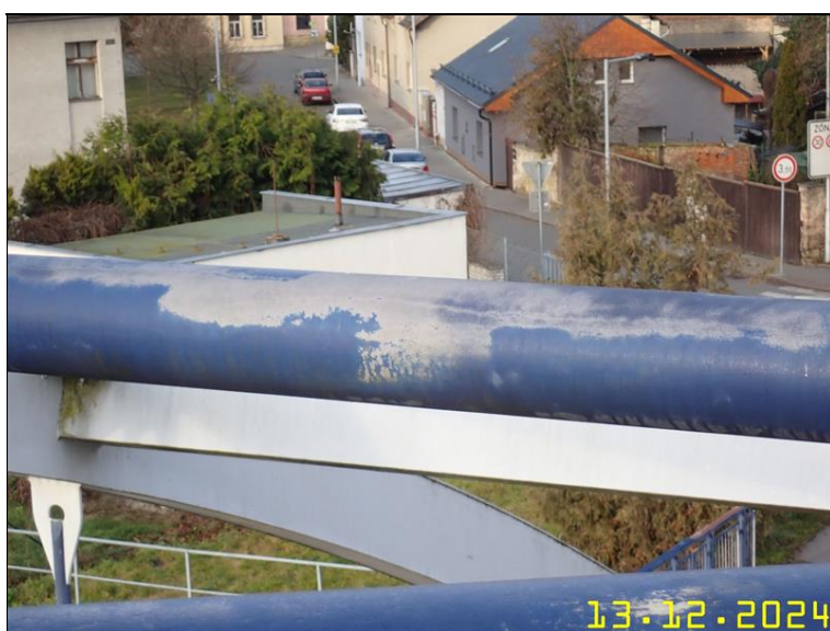
231 PRVKY OCELOVÉ KONSTRUKCE Z PLOŠINY.JPG
