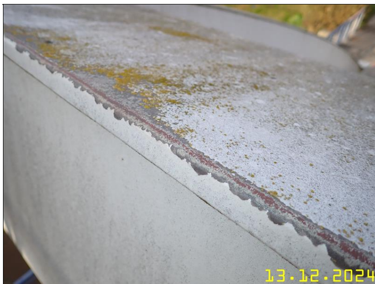
268 PRVKY OCELOVÉ KONSTRUKCE Z PLOŠINY.JPG
