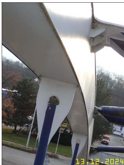
254 PRVKY OCELOVÉ KONSTRUKCE Z PLOŠINY.JPG
