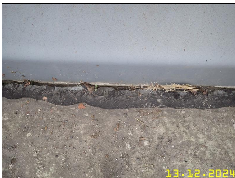
123 ZATĚSNĚNÍ OCEL BETON.JPG
