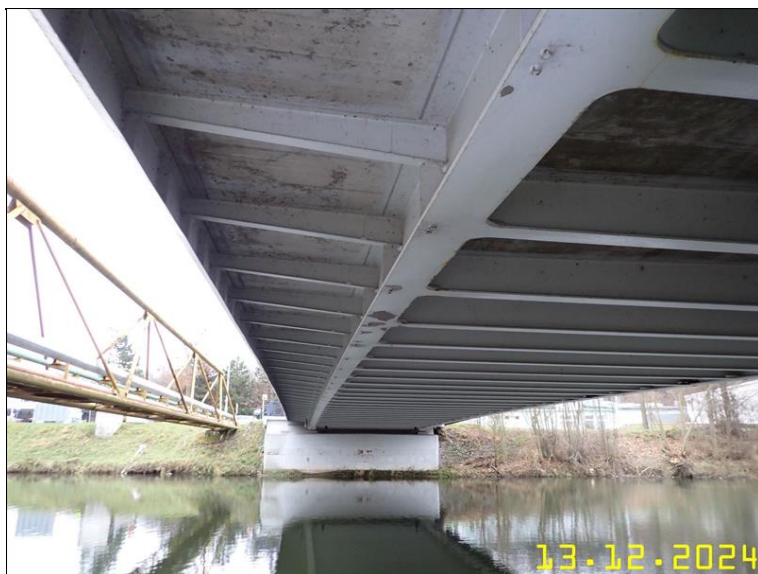
142 PODHLED NK VLEVO SMĚŘEM OD O1.JPG
