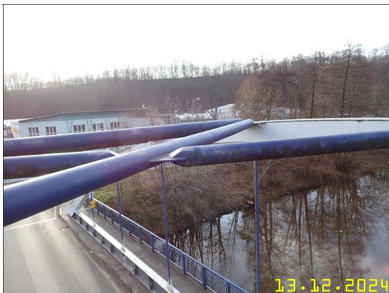
236 PRVKY OCELOVÉ KONSTRUKCE Z PLOŠINY.JPG
