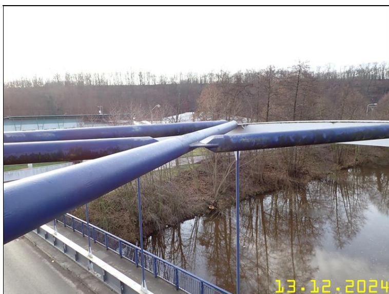
219 PRVKY OCELOVÉ KONSTRUKCE Z PLOŠINY.JPG
