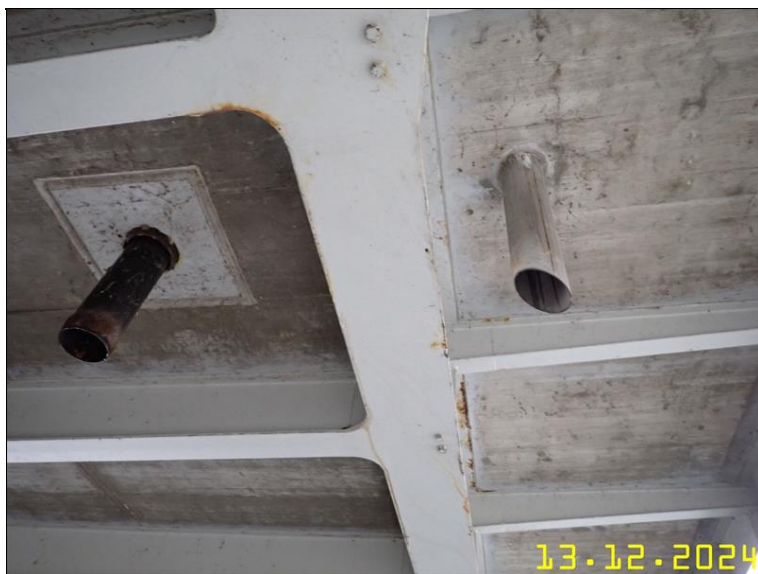
190 ODVODNĚNÍ U O2 L.JPG
