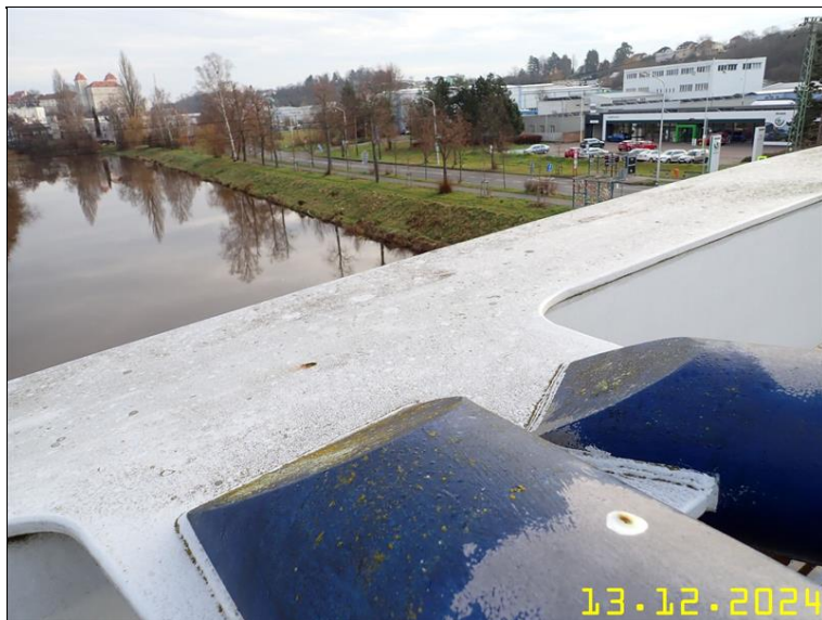
217 PRVKY OCELOVÉ KONSTRUKCE Z PLOŠINY.JPG
