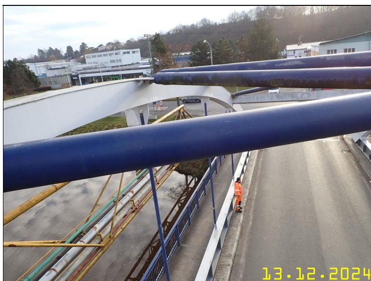
237 PRVKY OCELOVÉ KONSTRUKCE Z PLOŠINY.JPG
