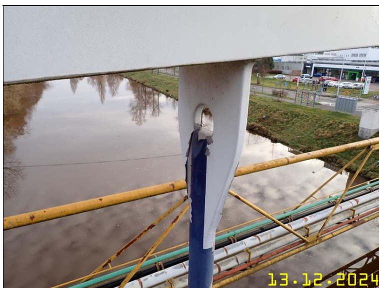
216 PRVKY OCELOVÉ KONSTRUKCE Z PLOŠINY.JPG
