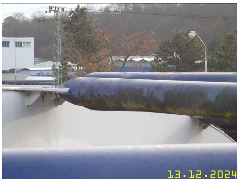
239 PRVKY OCELOVÉ KONSTRUKCE Z PLOŠINY.JPG
