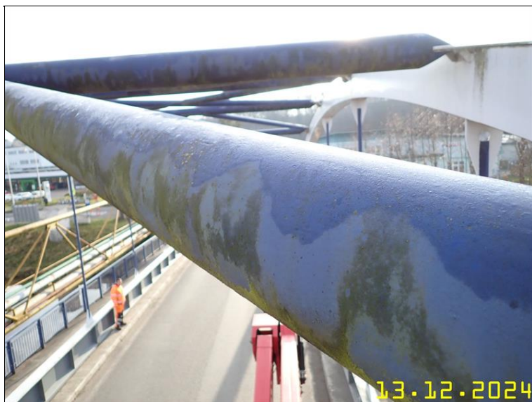
271 PRVKY OCELOVÉ KONSTRUKCE Z PLOŠINY.JPG
