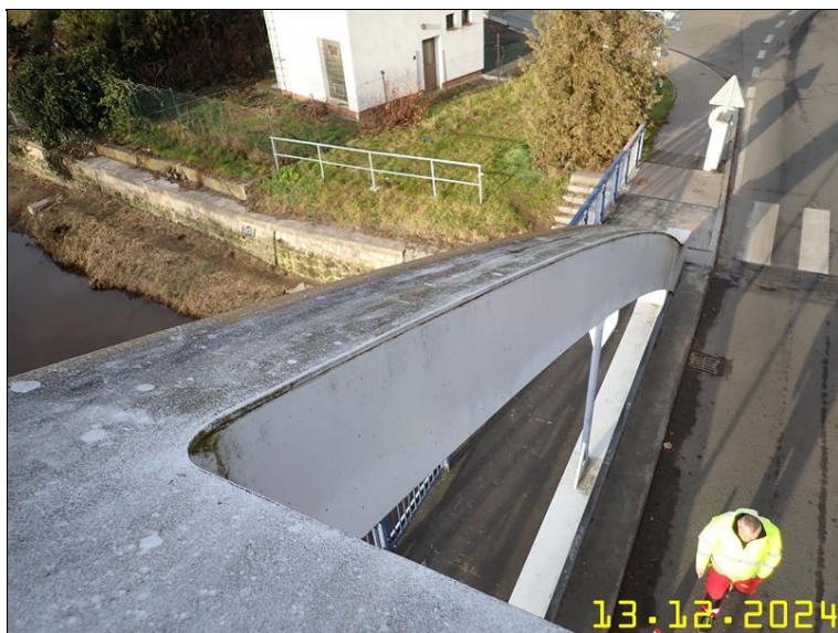
272 PRVKY OCELOVÉ KONSTRUKCE Z PLOŠINY.JPG
