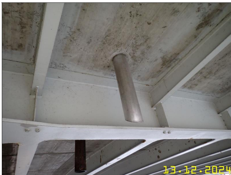
136 ODVODNĚNÍ V PODHLÉDU.JPG
