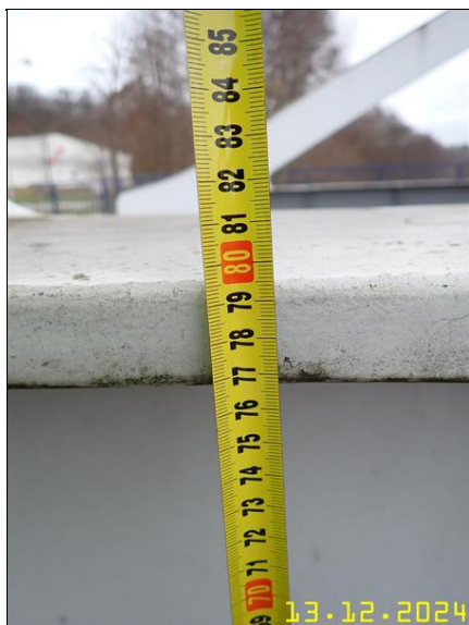
106 VÝŠKA PARAPETU VLEVO.JPG
