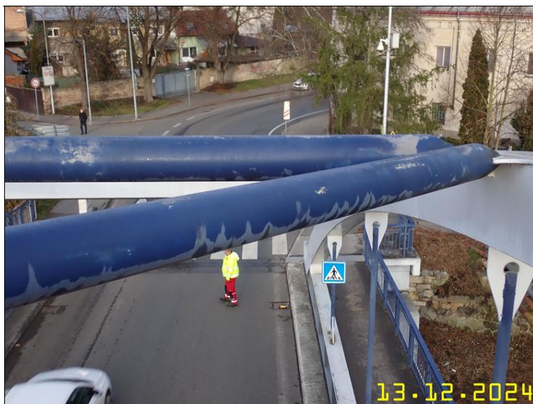
229 PRVKY OCELOVÉ KONSTRUKCE Z PLOŠINY.JPG
