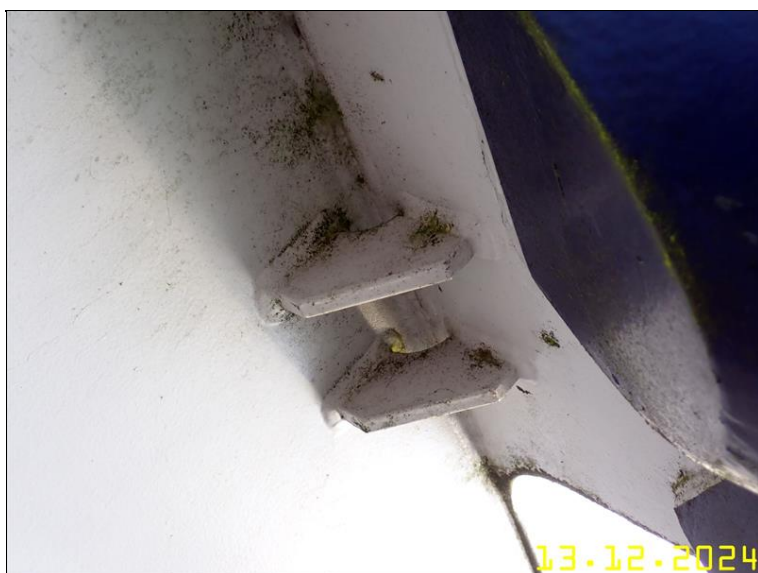
227 PRVKY OCELOVÉ KONSTRUKCE Z PLOŠINY.JPG
