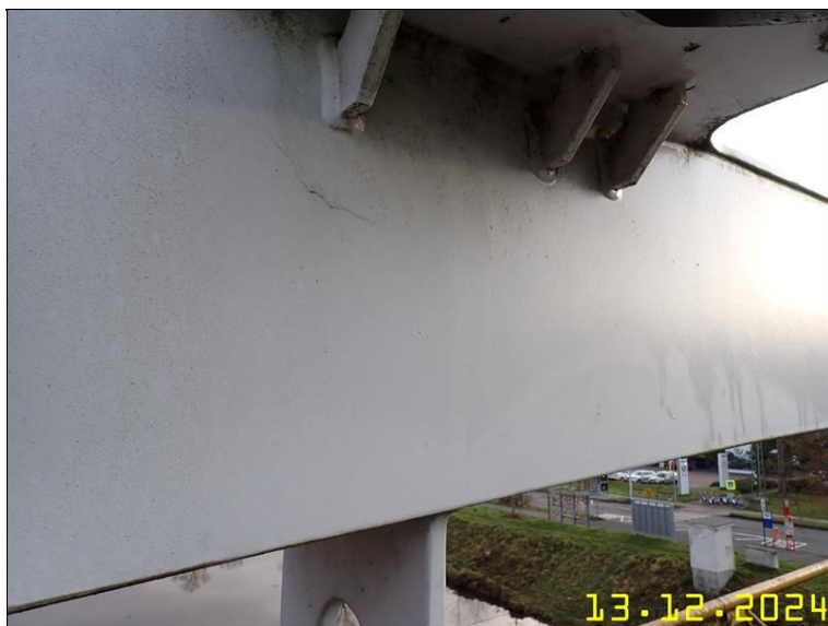
215 PRVKY OCELOVÉ KONSTRUKCE Z PLOŠINY.JPG
