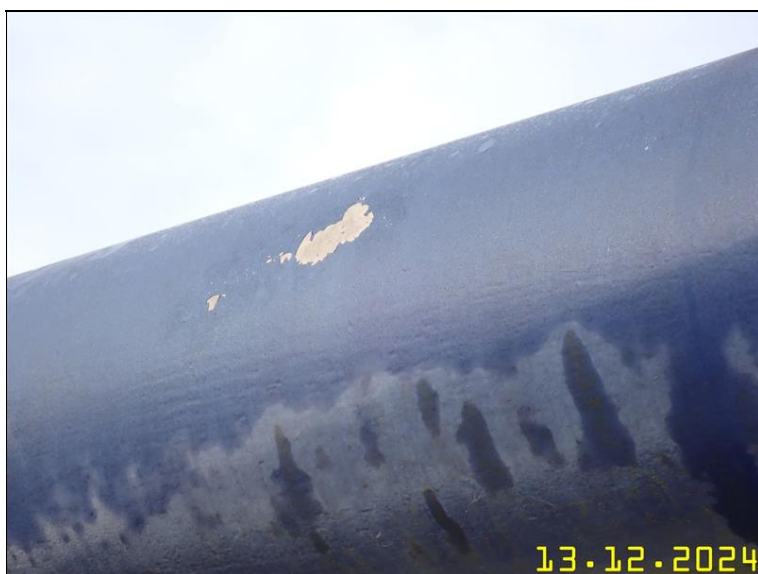
258 PRVKY OCELOVÉ KONSTRUKCE Z PLOŠINY.JPG
