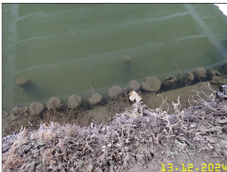
144 OPEVNĚNÍ KORYTA O1.JPG
