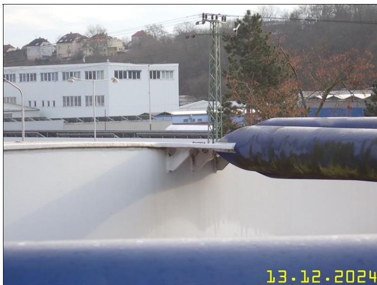
238 PRVKY OCELOVÉ KONSTRUKCE Z PLOŠINY.JPG
