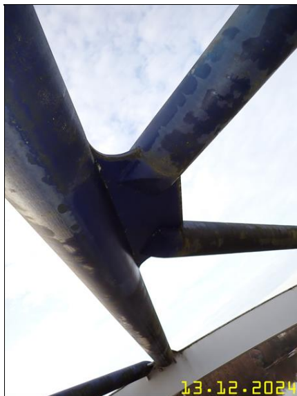
262 PRVKY OCELOVÉ KONSTRUKCE Z PLOŠINY.JPG
