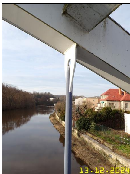
282 PRVKY OCELOVÉ KONSTRUKCE Z PLOŠINY.JPG
