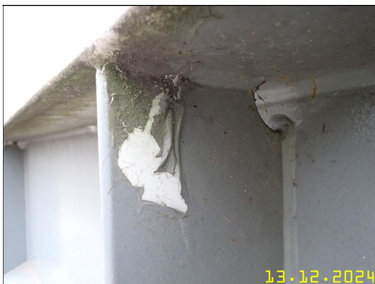
114 PKO LEVÉHO PARAPETU.JPG
