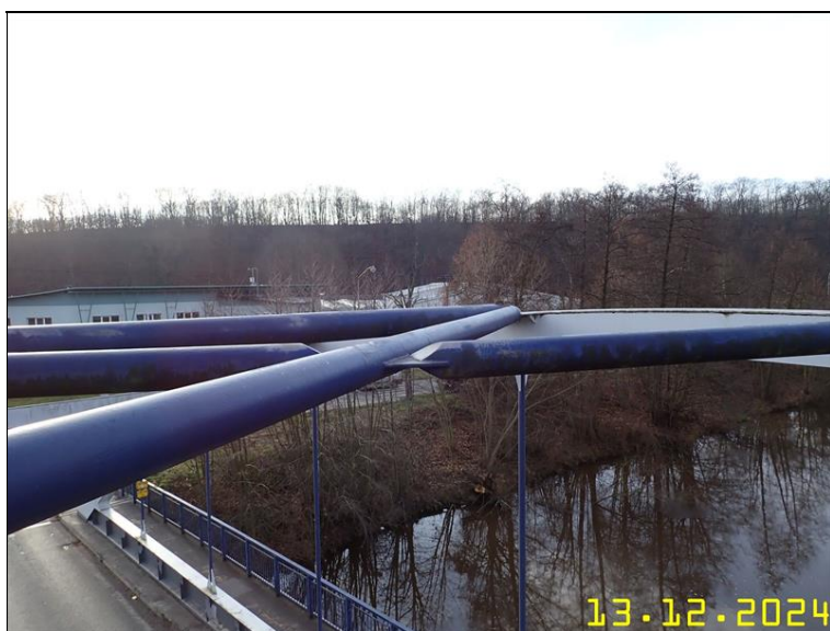
234 PRVKY OCELOVÉ KONSTRUKCE Z PLOŠINY.JPG
