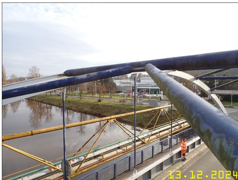
275 PRVKY OCELOVÉ KONSTRUKCE Z PLOŠINY.JPG
