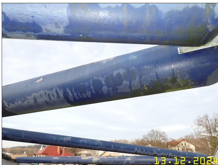
257 PRVKY OCELOVÉ KONSTRUKCE Z PLOŠINY.JPG
