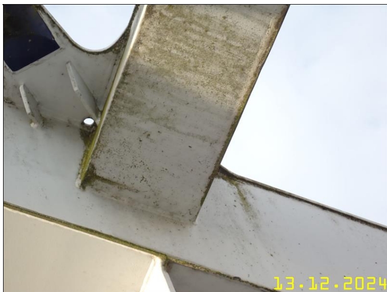
284 PRVKY OCELOVÉ KONSTRUKCE Z PLOŠINY.JPG
