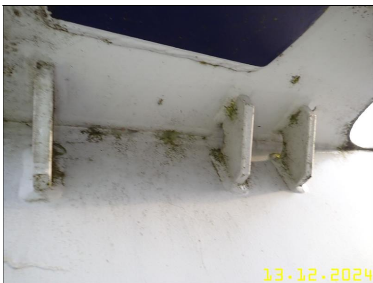
246 PRVKY OCELOVÉ KONSTRUKCE Z PLOŠINY.JPG
