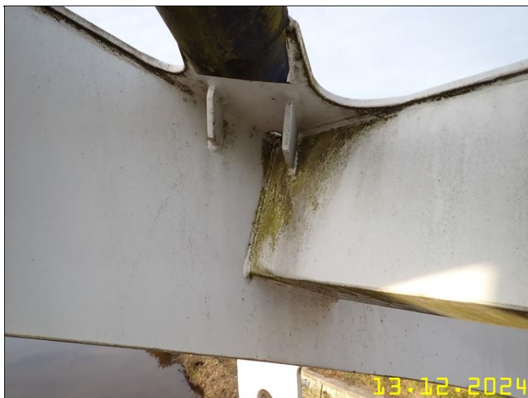
263 PRVKY OCELOVÉ KONSTRUKCE Z PLOŠINY.JPG
