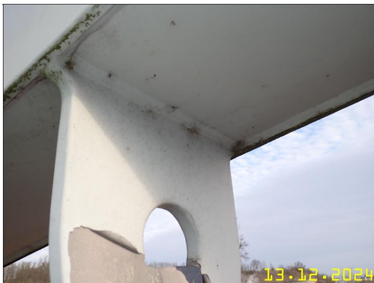
244 PRVKY OCELOVÉ KONSTRUKCE Z PLOŠINY.JPG
