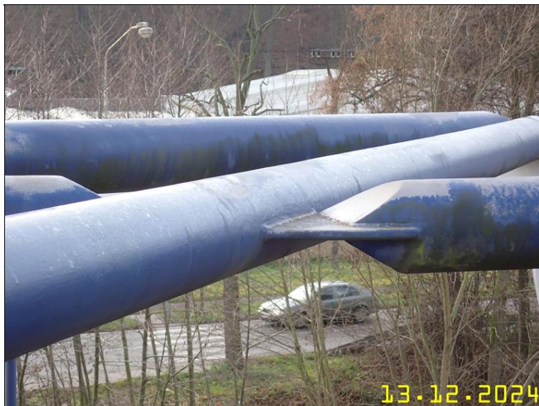
220 PRVKY OCELOVÉ KONSTRUKCE Z PLOŠINY.JPG
