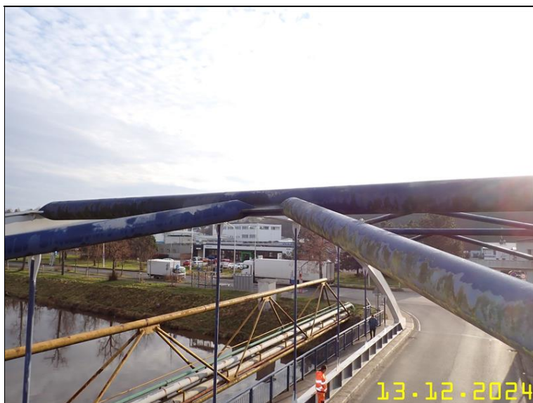
276 PRVKY OCELOVÉ KONSTRUKCE Z PLOŠINY.JPG
