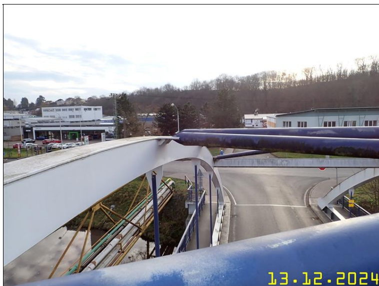
218 PRVKY OCELOVÉ KONSTRUKCE Z PLOŠINY.JPG
