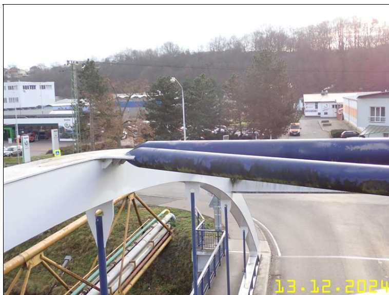
223 PRVKY OCELOVÉ KONSTRUKCE Z PLOŠINY.JPG
