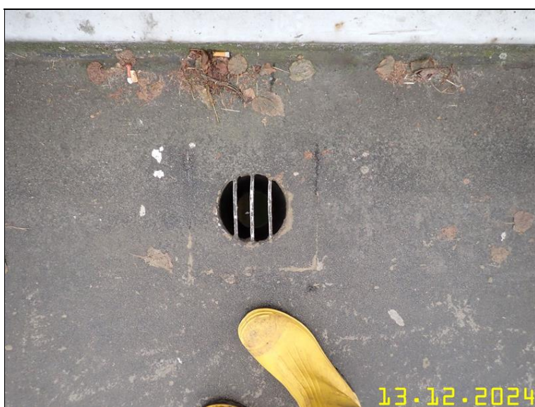
096 ODVODNENÍ LEVÁ ŘÍMSA.JPG
