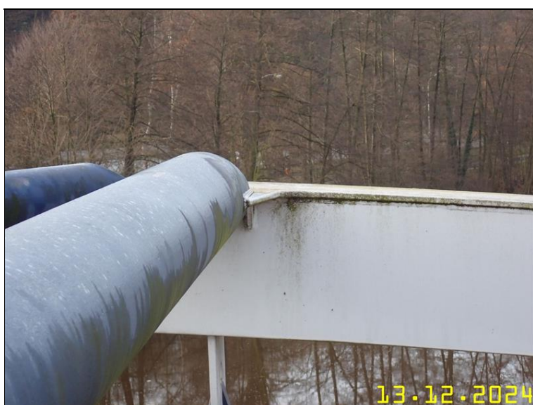
240 PRVKY OCELOVÉ KONSTRUKCE Z PLOŠINY.JPG
