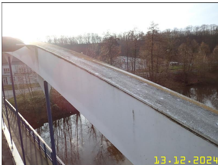
273 PRVKY OCELOVÉ KONSTRUKCE Z PLOŠINY.JPG
