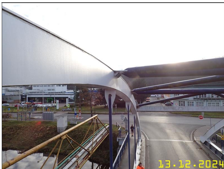
249 PRVKY OCELOVÉ KONSTRUKCE Z PLOŠINY.JPG
