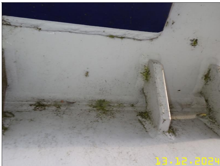
245 PRVKY OCELOVÉ KONSTRUKCE Z PLOŠINY.JPG
