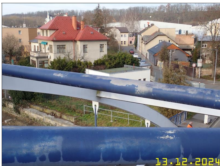
230 PRVKY OCELOVÉ KONSTRUKCE Z PLOŠINY.JPG
