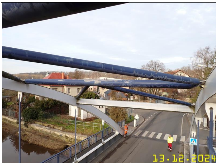
256 PRVKY OCELOVÉ KONSTRUKCE Z PLOŠINY.JPG
