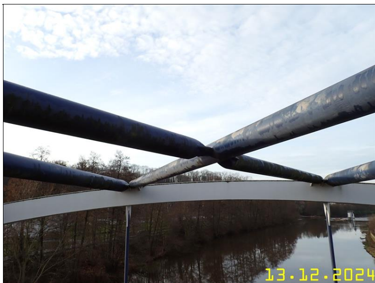
260 PRVKY OCELOVÉ KONSTRUKCE Z PLOŠINY.JPG
