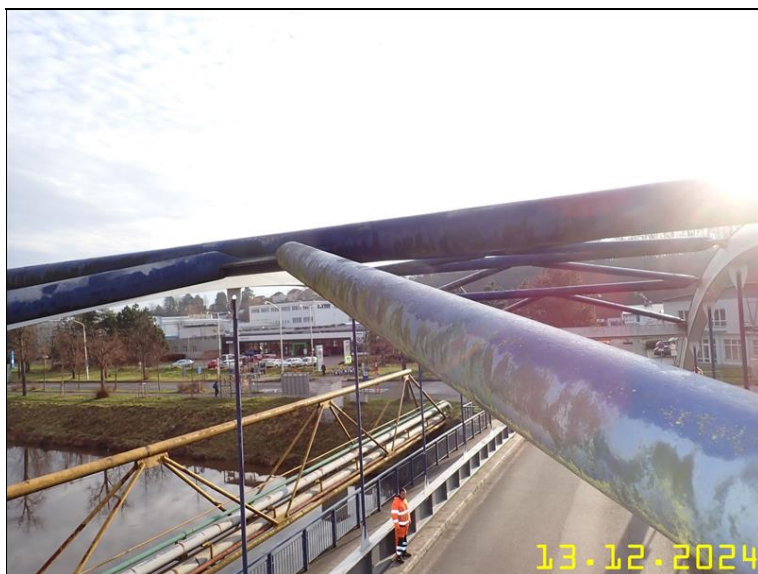
270 PRVKY OCELOVÉ KONSTRUKCE Z PLOŠINY.JPG
