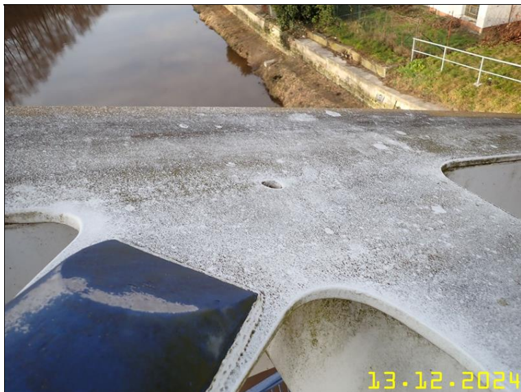
265 PRVKY OCELOVÉ KONSTRUKCE Z PLOŠINY.JPG
