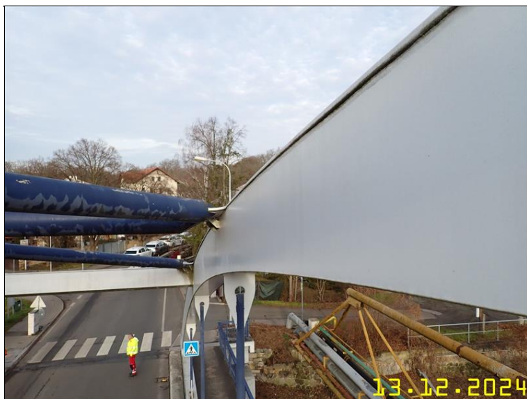
247 PRVKY OCELOVÉ KONSTRUKCE Z PLOŠINY.JPG
