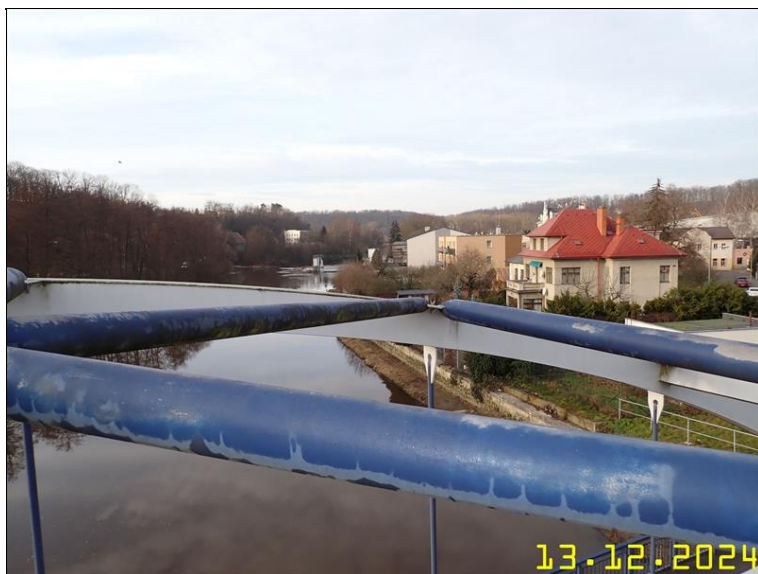
232 PRVKY OCELOVÉ KONSTRUKCE Z PLOŠINY.JPG
