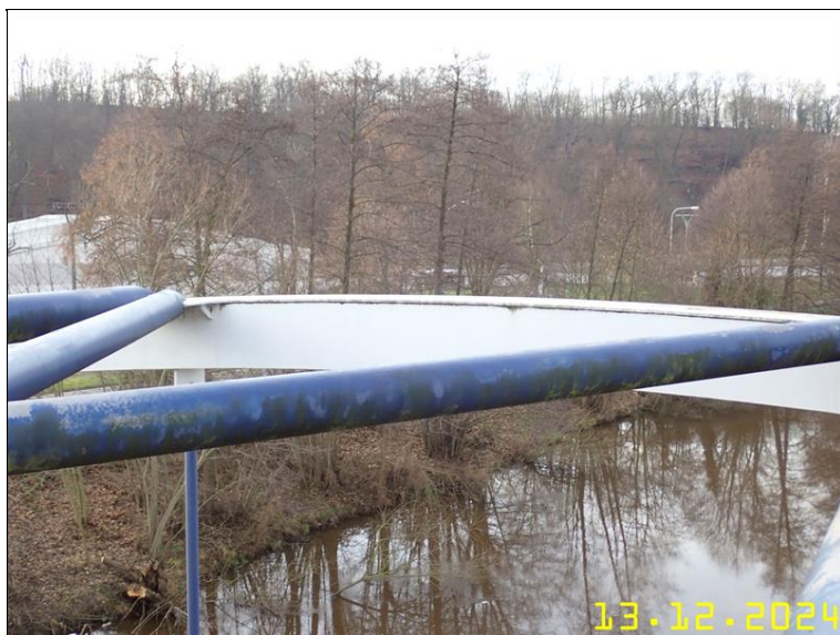
224 PRVKY OCELOVÉ KONSTRUKCE Z PLOŠINY.JPG
