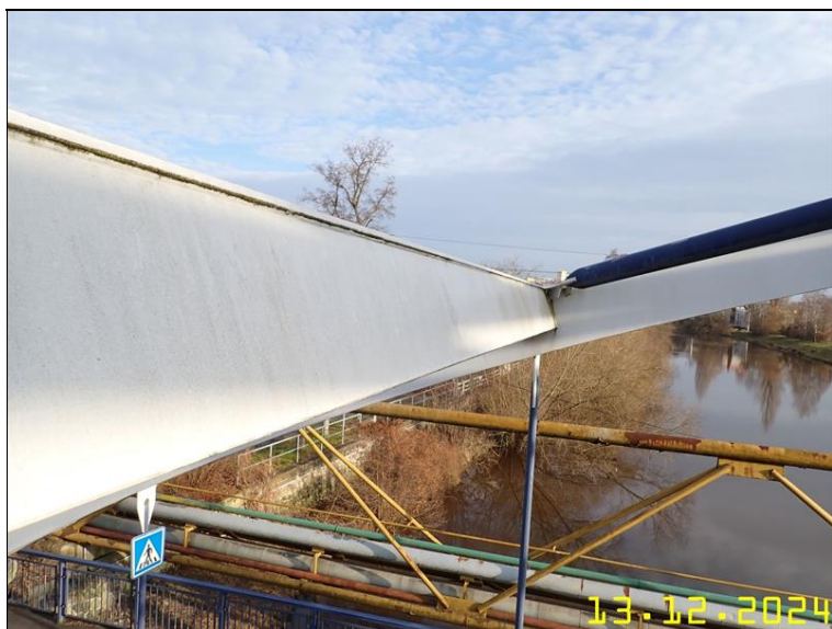
264 PRVKY OCELOVÉ KONSTRUKCE Z PLOŠINY.JPG
