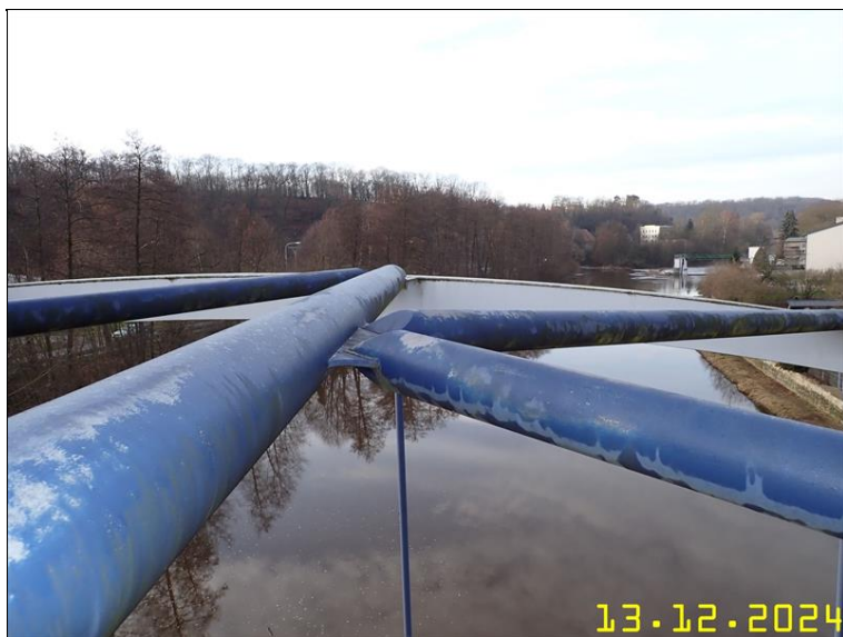
233 PRVKY OCELOVÉ KONSTRUKCE Z PLOŠINY.JPG
