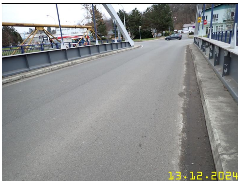
057 NK VPRAVO PRAVÁ KRAJNICE.JPG
