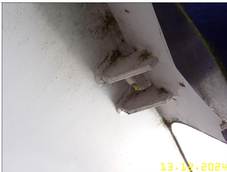
226 PRVKY OCELOVÉ KONSTRUKCE Z PLOŠINY.JPG
