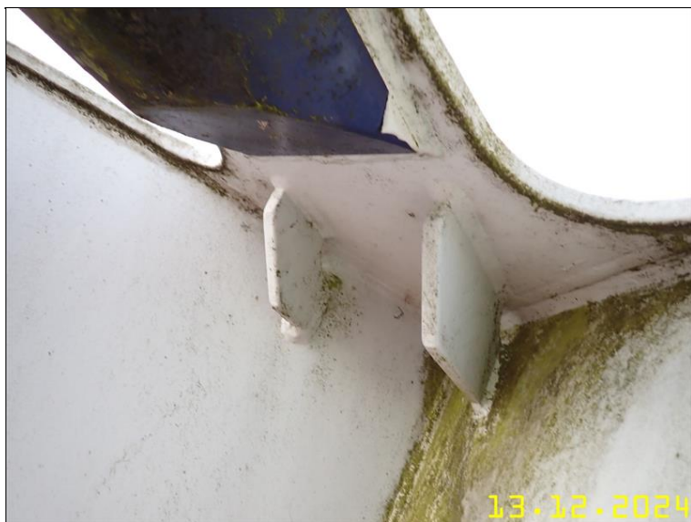
266 PRVKY OCELOVÉ KONSTRUKCE Z PLOŠINY.JPG
