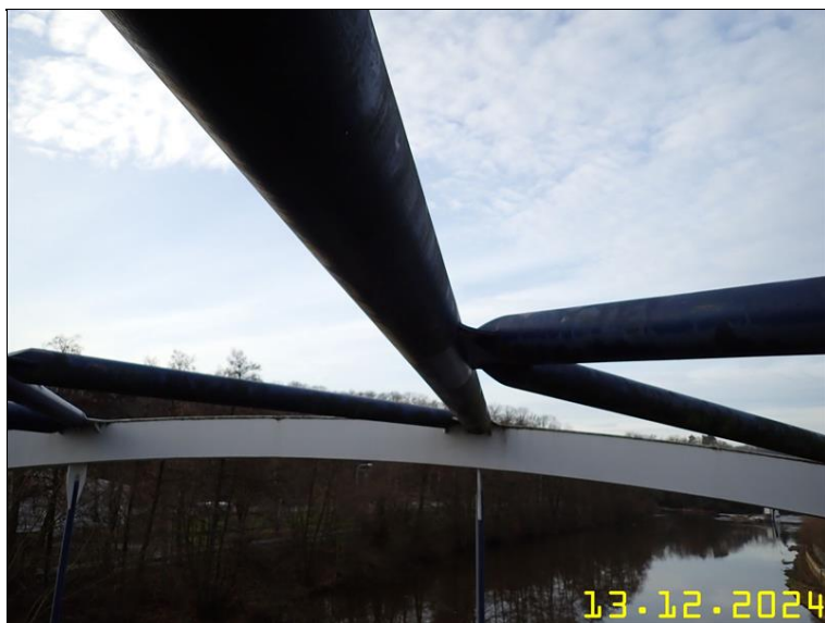
248 PRVKY OCELOVÉ KONSTRUKCE Z PLOŠINY.JPG
