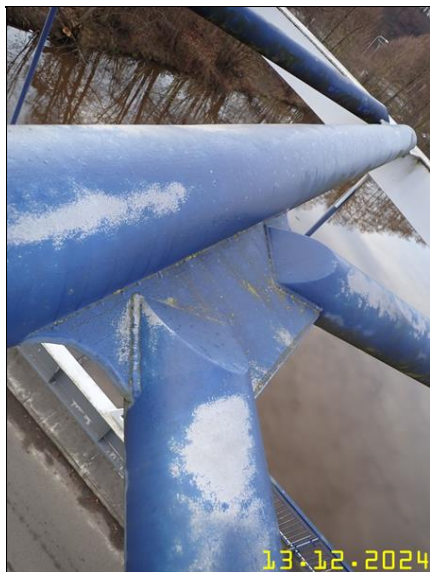
235 PRVKY OCELOVÉ KONSTRUKCE Z PLOŠINY.JPG
