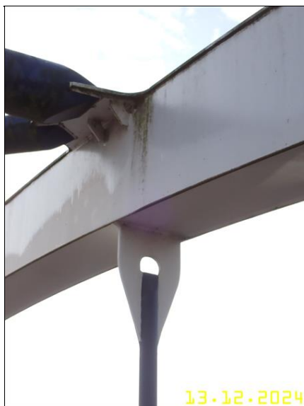
283 PRVKY OCELOVÉ KONSTRUKCE Z PLOŠINY.JPG
