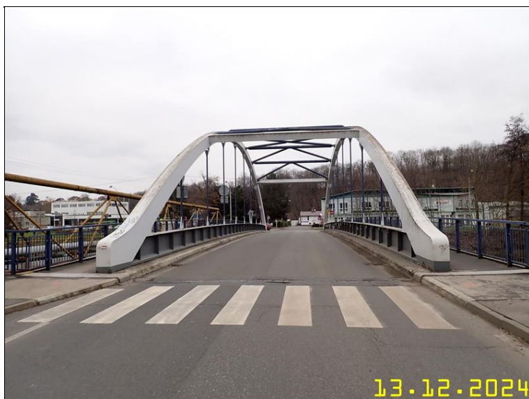
002 PROSTOROVÉ USPOŘÁDÁNÍ V POHLEDU VE SMĚRU STANIČENÍ.JPG
