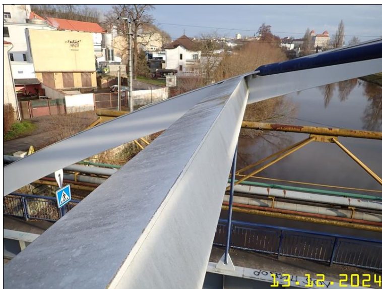
269 PRVKY OCELOVÉ KONSTRUKCE Z PLOŠINY.JPG
