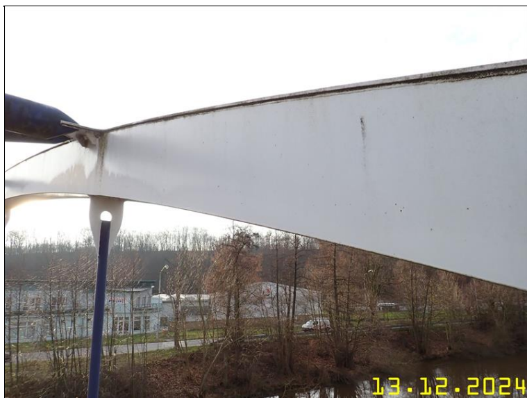
278 PRVKY OCELOVÉ KONSTRUKCE Z PLOŠINY.JPG
