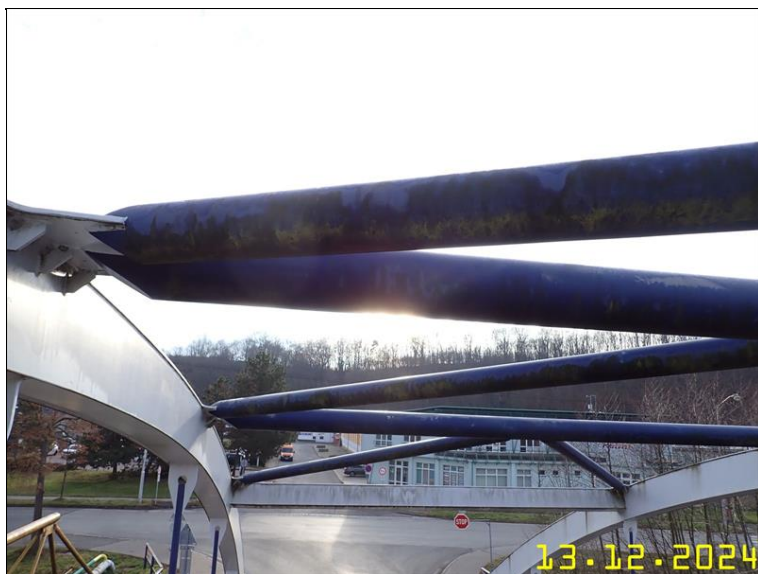
259 PRVKY OCELOVÉ KONSTRUKCE Z PLOŠINY.JPG
