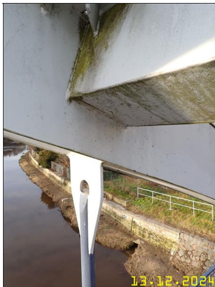
277 PRVKY OCELOVÉ KONSTRUKCE Z PLOŠINY.JPG
