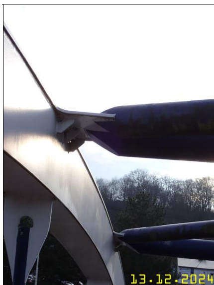
253 PRVKY OCELOVÉ KONSTRUKCE Z PLOŠINY.JPG
