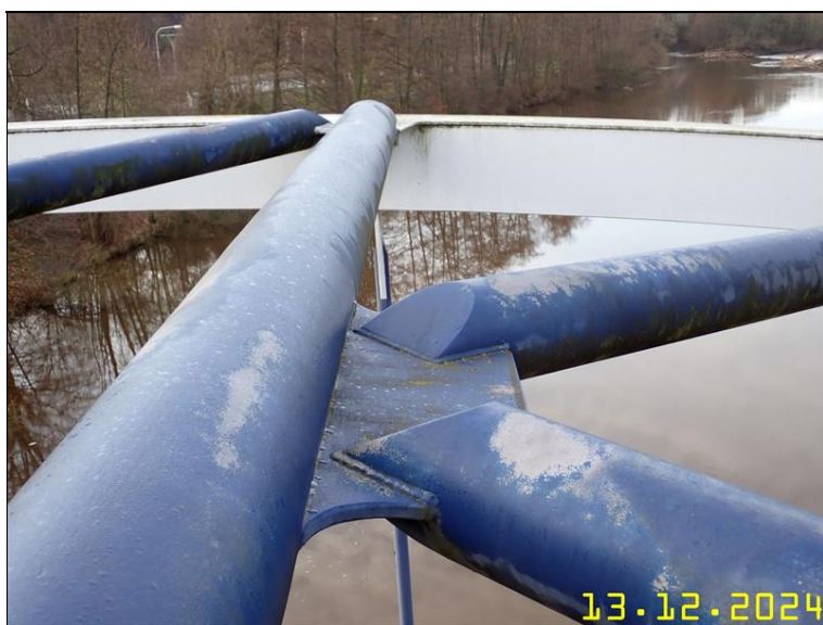
225 PRVKY OCELOVÉ KONSTRUKCE Z PLOŠINY.JPG
