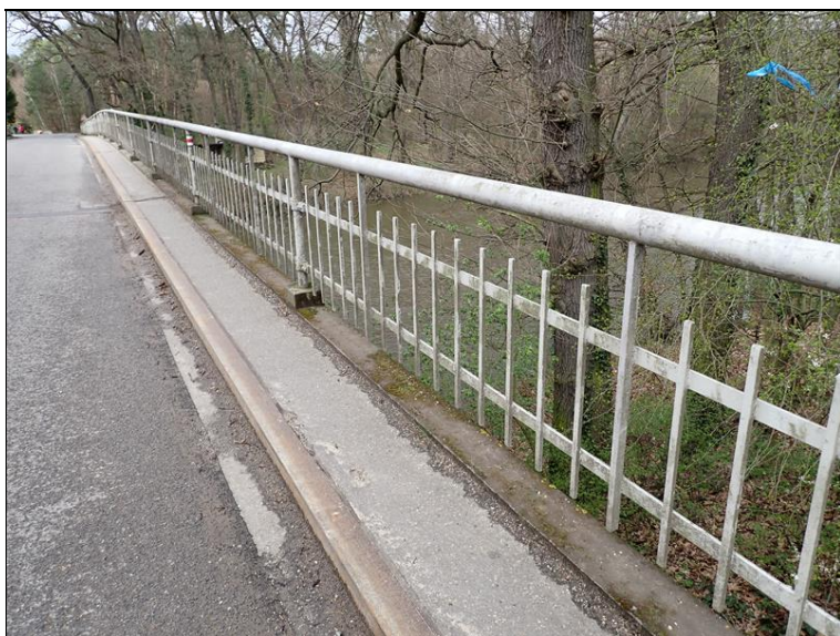
Okraj mostu vlevo.
