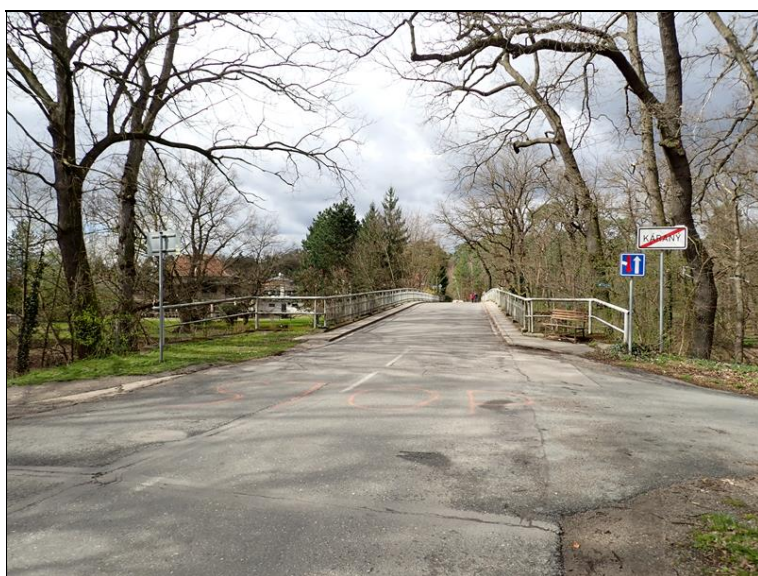
Pohled na most proti směru staničení.
