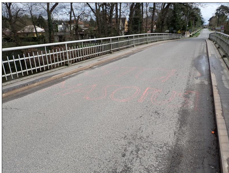
Vozovka na mostě.
