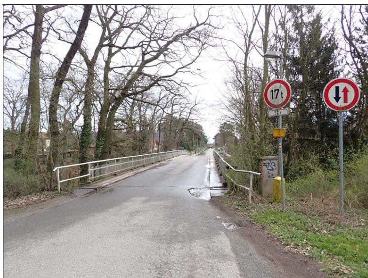
Pohled na most ve směru staničení.
