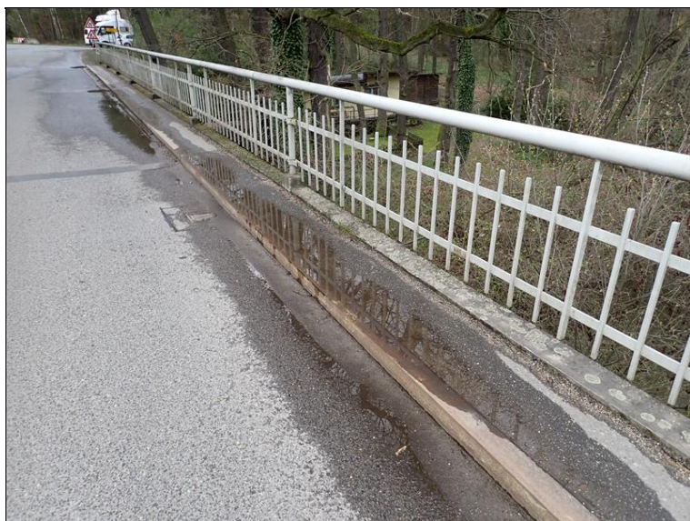
Okraj mostu vlevo.
