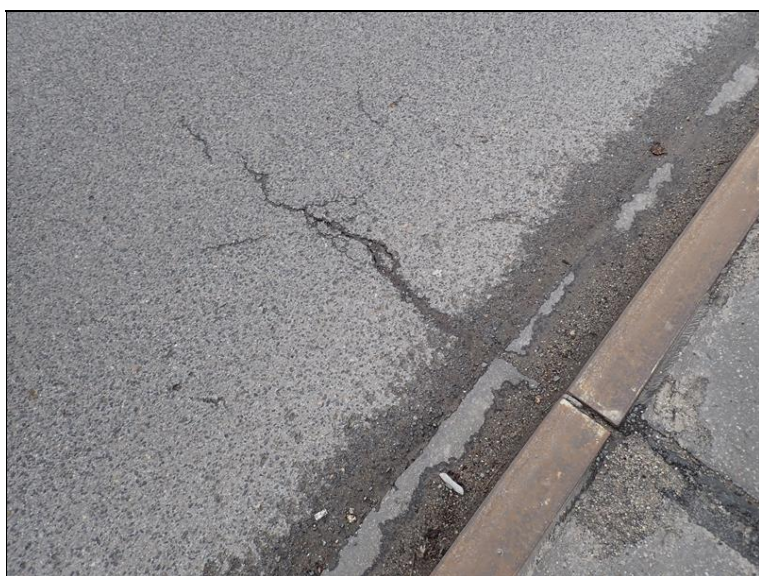
Vozovka na mostě.
