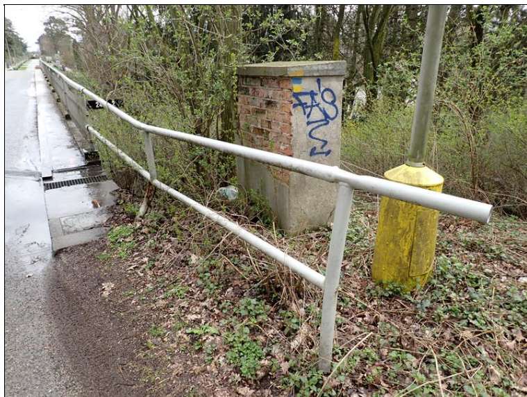
Okraj mostu vpravo.
