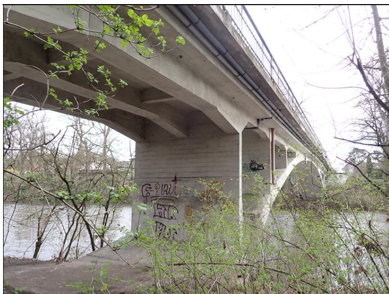
Pohled na most zprava.
