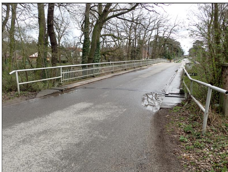
Pohled na most ve směru staničení.
