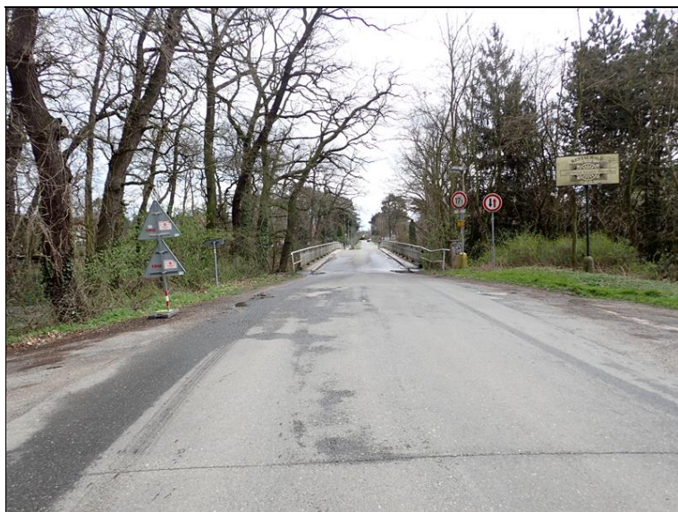
Pohled na most ve směru staničení.
