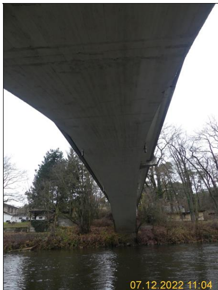
Nosná konstrukce 4. pole
