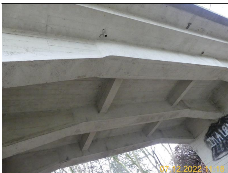
Nosná konstrukce 2. pole
