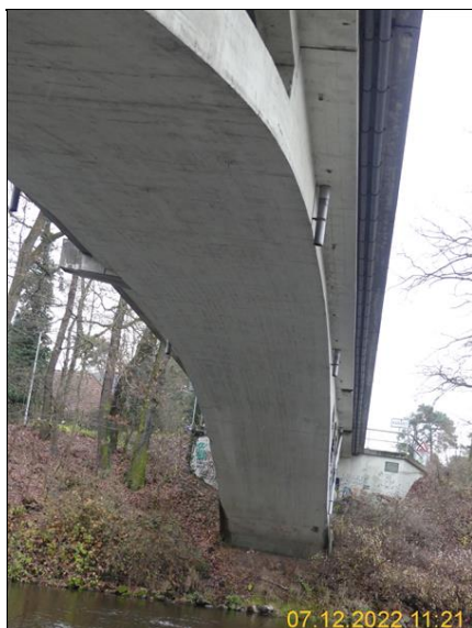
Nosná konstrukce 4. pole
