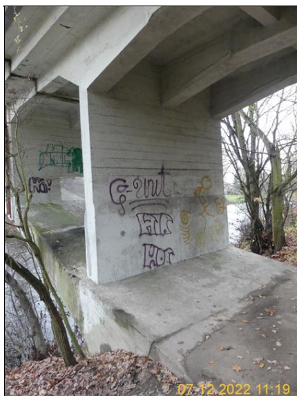
P4 po směru staničení
