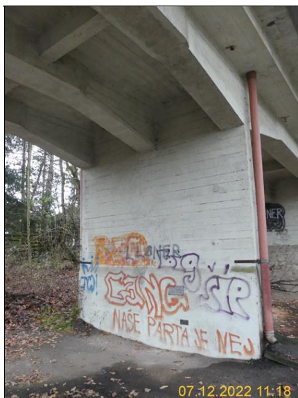
P3 proti směru staničení
