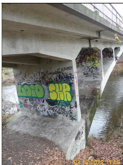
P5 proti směru staničení
