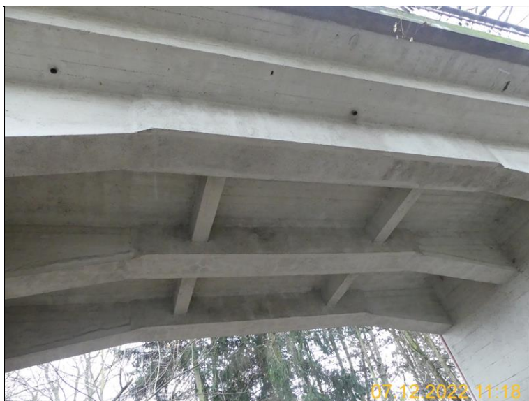
Nosná konstrukce 3. pole
