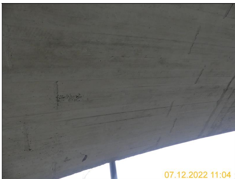
Nosná konstrukce 4. pole
