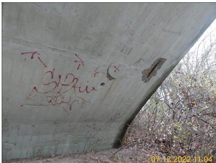
Trhlina na nosné konstrukci 4. pole
