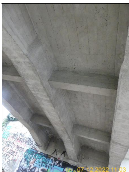
Nosná konstrukce 5. pole
