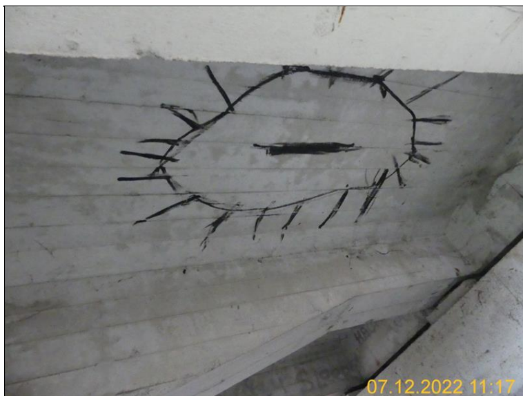
Nosná konstrukce 1. pole
