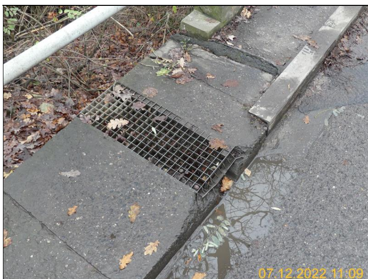
Odvodňovací kanálek před mostem
