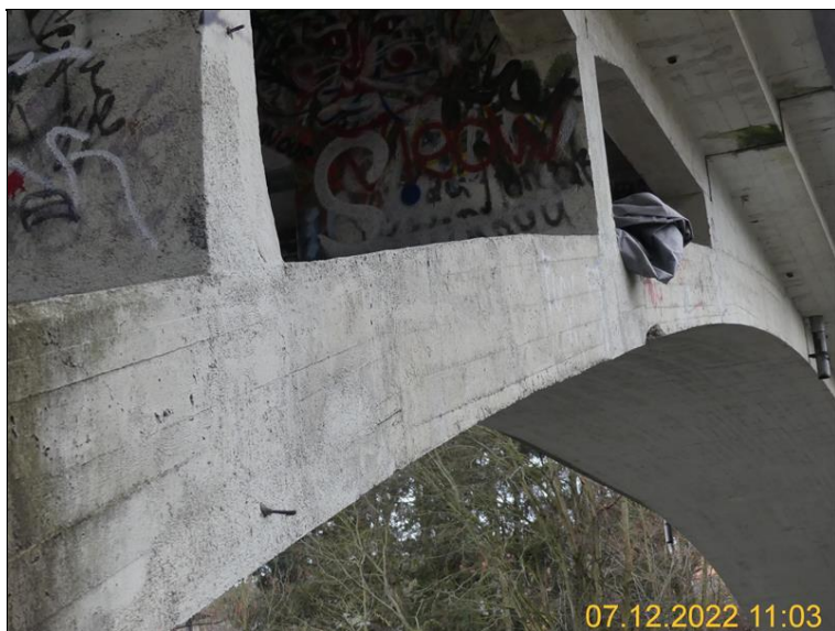
Nosná konstrukce 4. pole
