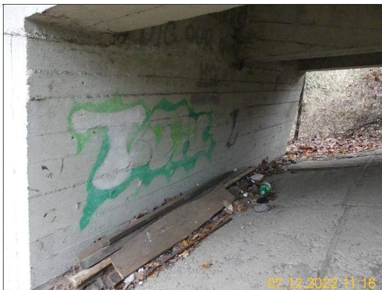
P2 po směru staničení
