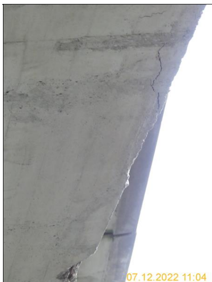
Trhlina na nosné konstrukci 4. pole
