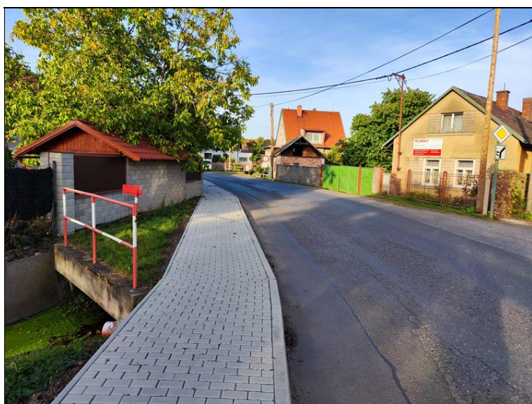
uspořádání na mostě ve směru staničení - levá strana
