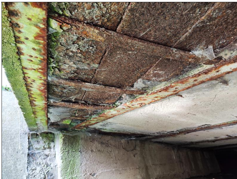
Podhled NK vlevo
