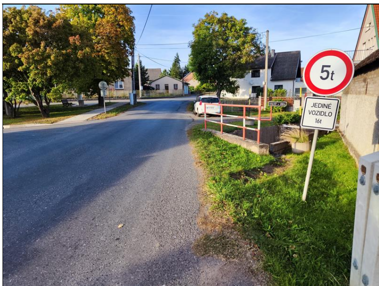
uspořádání na mostě ve směru staničení - pravá strana
