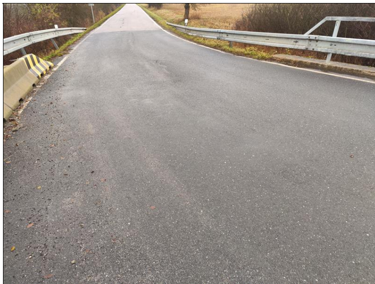
vozovka na mostě
