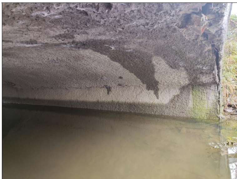
Deska - četné trhliny s výluhy a inkrustací na pohledu. Během HPM pohled mokry.
