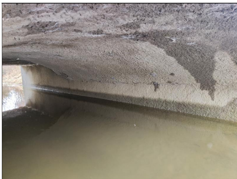
Deska - četné trhliny s výluhy a inkrustací na pohledu. Během HPM pohled mokry.
