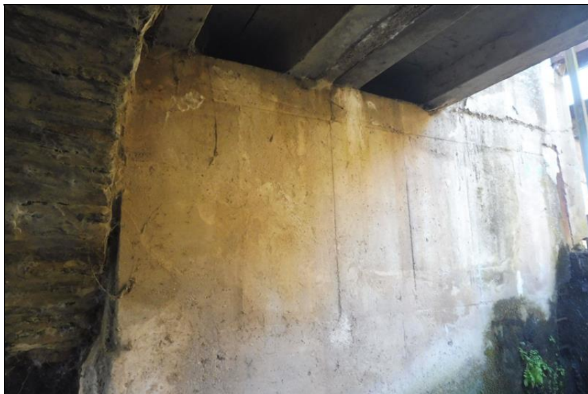
Pohled na opěru 1 pod žb rozšířením.
