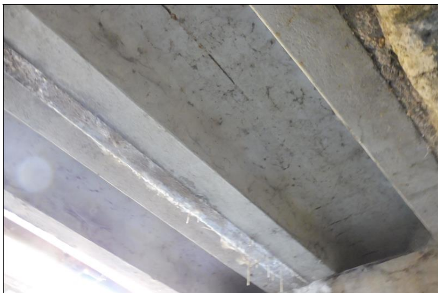
Pohled na spodek nosné konstrukce - žb. rozšíření.
