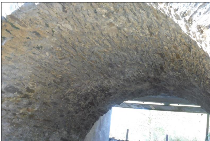
Pohled na spodek nosné konstrukce.
