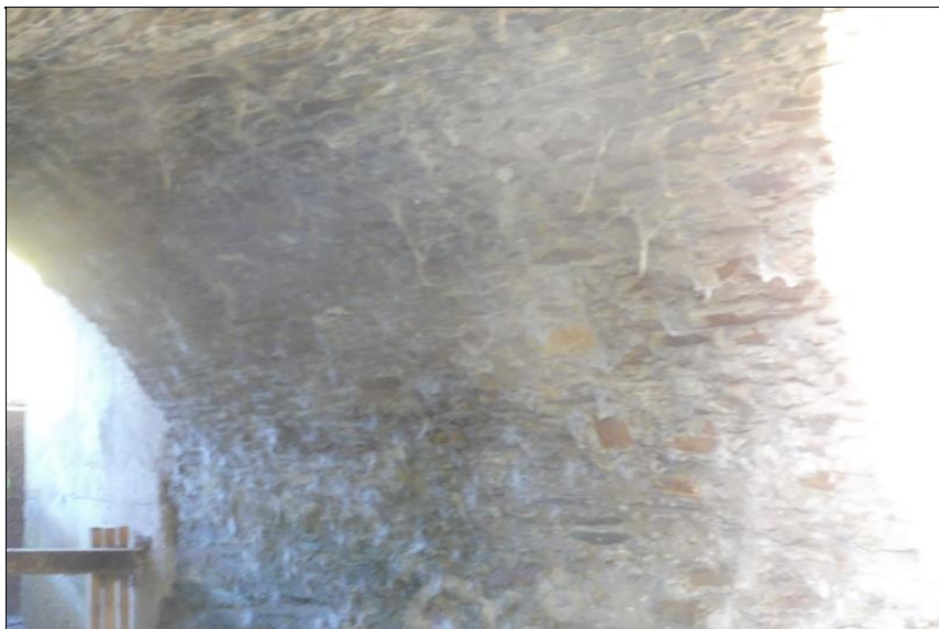
Pohled na spodek nosné konstrukce.
