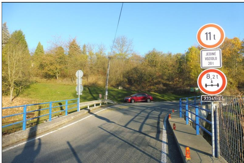
Pohled na most po směru staničení.
