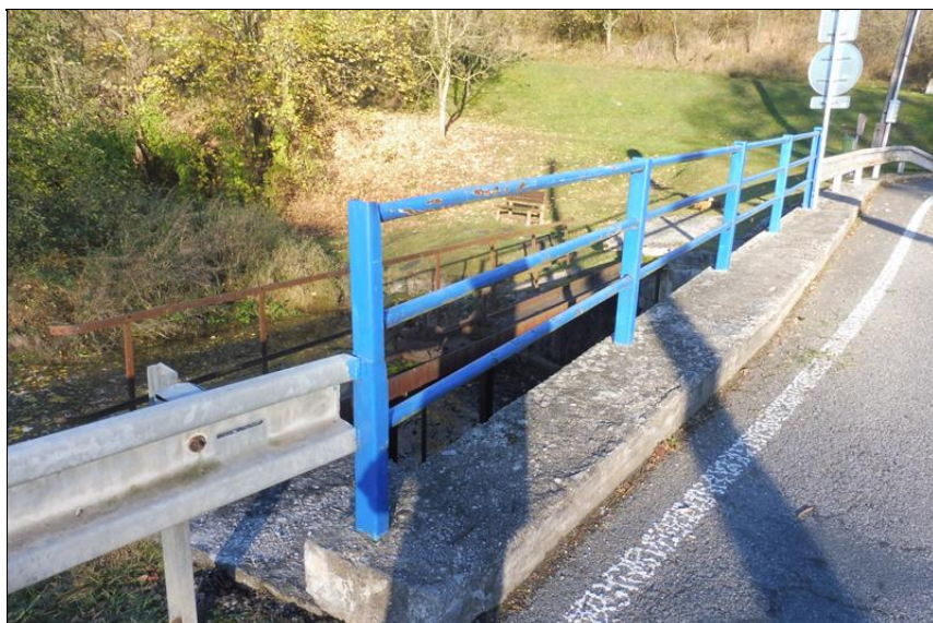
Pohled na levou stranu mostu.
