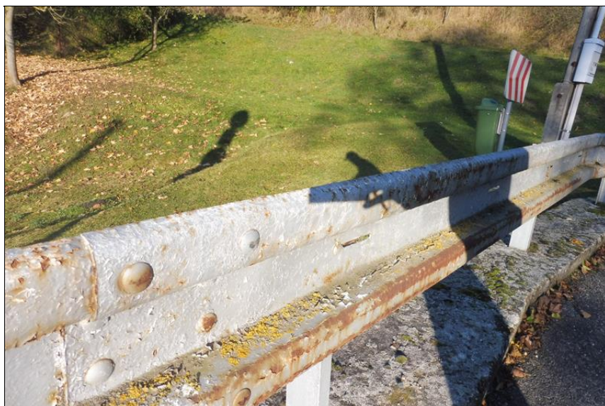
Koroze svodnice.
